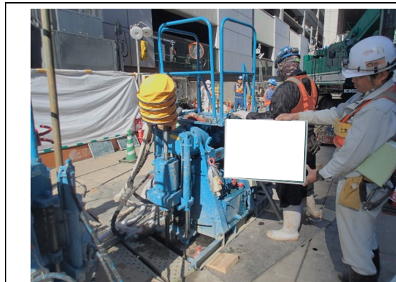
写真-1-1 薬液注入工法における指針の順守の状況 (地点 01)
