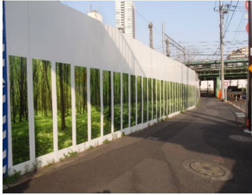
写真-2-1 仮囲い・防音シート等の設置状況 (地点 02)
