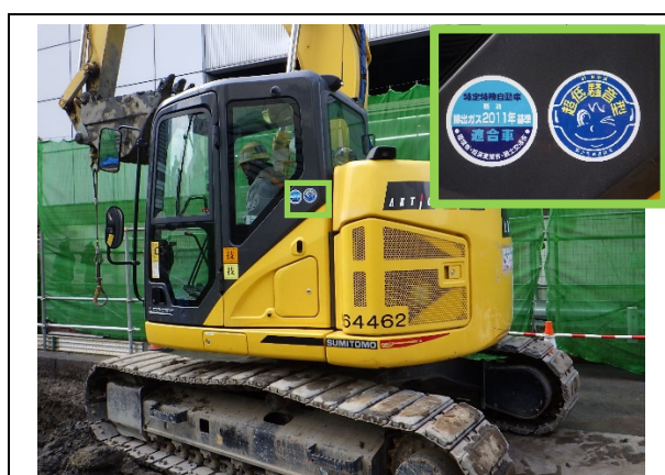
写真-1-1 排出ガス対策型建設機械の採用状況 (地点 01)
