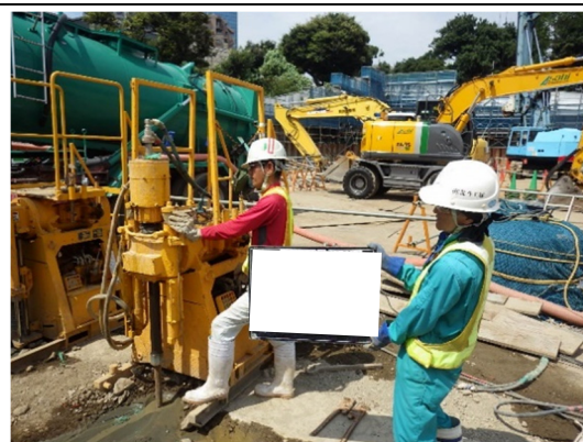
写真-1-2 薬液注入工法における指針の順守の状況 (地点 02)
