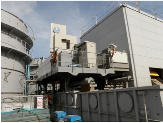
写真-1 建設汚泥の脱水処理の状況 (地点 02)
