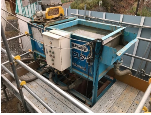
写真-9 工事排水の処理状況（地点 05）
