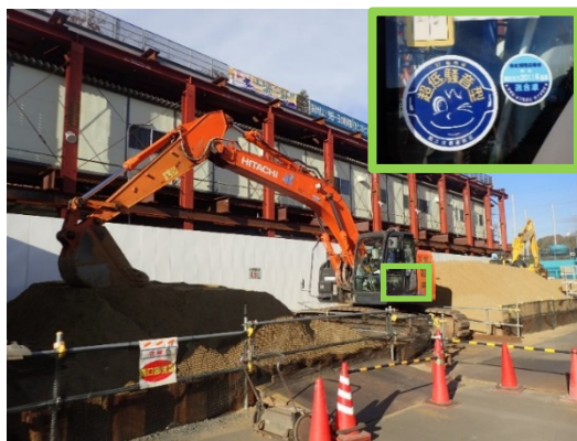
写真-5 超低騒音型建設機械の採用（地点 02）
