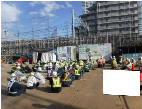
写真-4-1 工事従事者への講習・指導状況 (地点 02)
