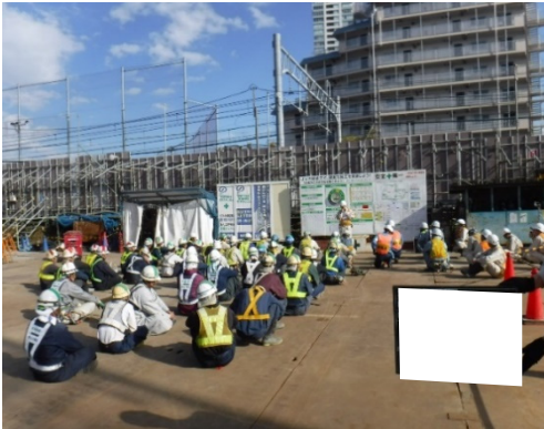
写真-3-1 工事従事者への講習・指導の状況 (地点 02)
