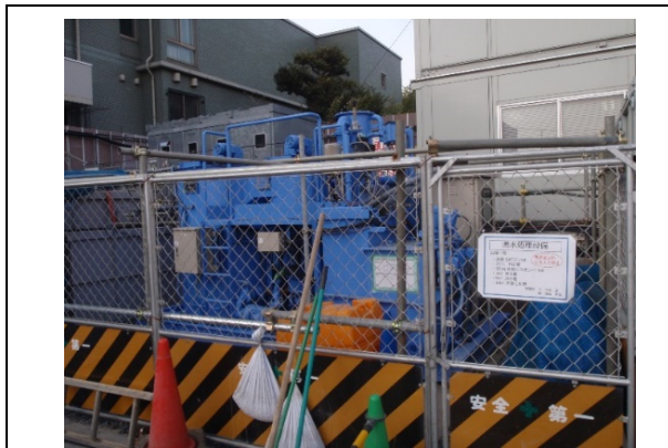
写真-1-1 工事排水の処理状況 (地点 02)
