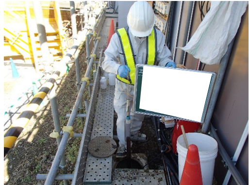
写真-1-2 地下水の監視状況（地点 02）
