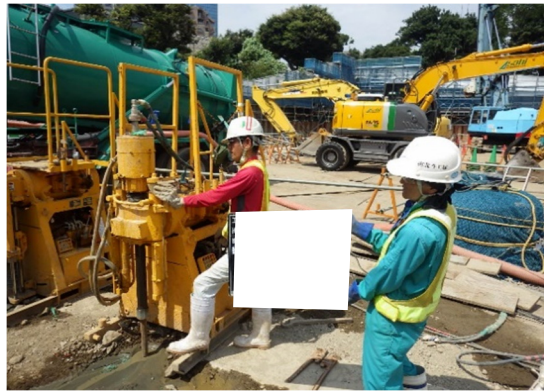
写真-2-2 薬液注入工の状況（地点 02）
