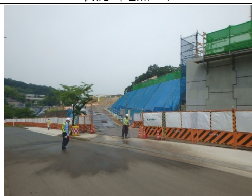
写真-5-2 車両の出入り口、周辺道路の清掃の状況（地点 05）
