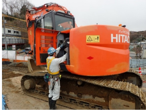
写真-2-2 建設機械の点検及び整備の状況 (地点 05)
