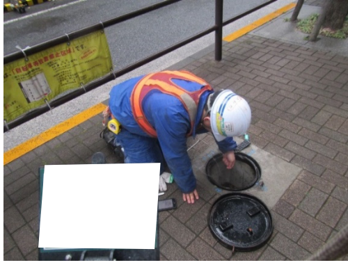
写真-1-1 地下水の監視状況（地点 01）
