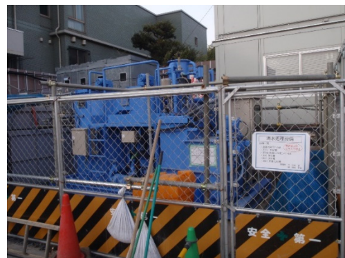
写真-6-2 工事排水の処理状況（地点 02）
