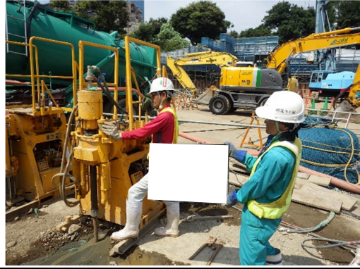
写真-8-2 薬液注入工の状況（地点 02）
