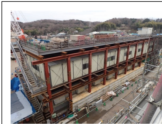
写真-11 諸設備の重層化 (地点 05)
