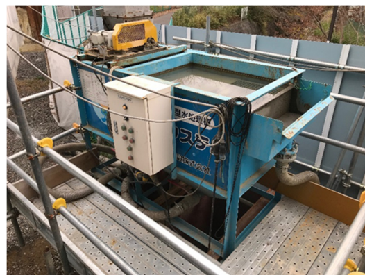
写真-1-2 工事排水の処理状況 (地点 05)
