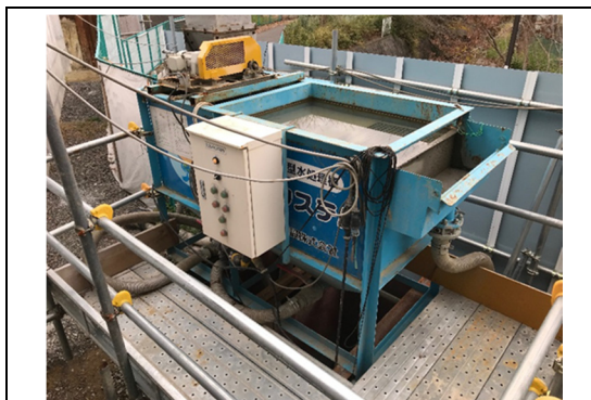
写真-1 工事排水の処理状況 (地点 05)
