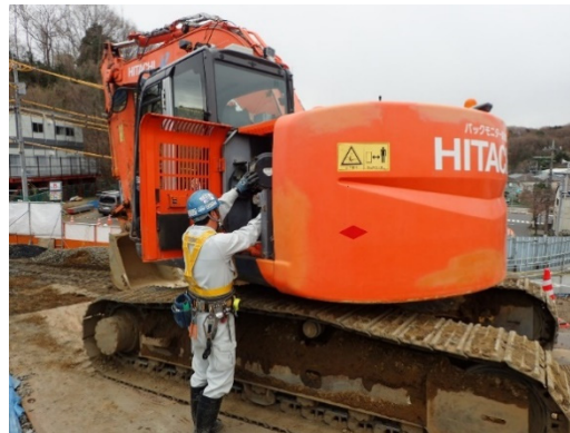
写真-3-2 建設機械の点検及び整備による 性能維持状況 (地点 05)
