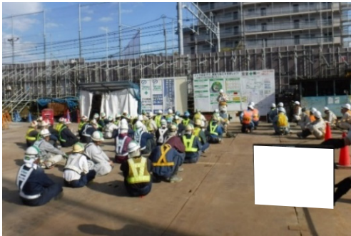
写真-4-1 工事従事者への講習・指導の状況 (地点 02)
