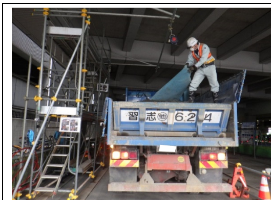
写真-4-1 荷台への防じんシート敷設の状況（地点 01）
