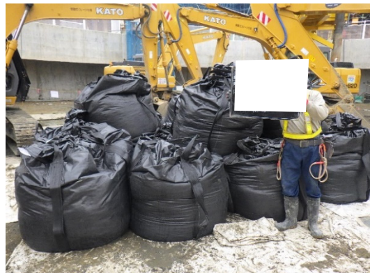
写真-3-2 発生土の仮置き状況（地点 02）
