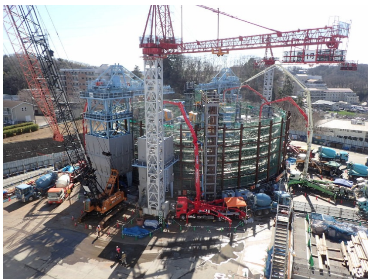
写真 3-4-5 施工状況 (平成 31 年 3 月時点当社HP公開)
