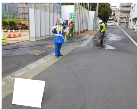
写真-5-1 車両の出入り口、周辺道路の清掃の状況（地点 03）
