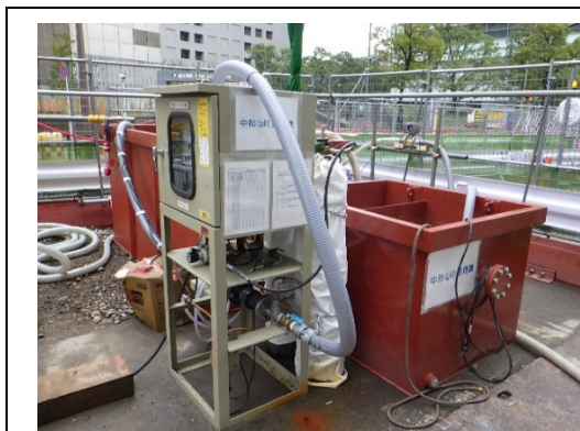
写真-6-1 工事排水の処理状況（地点 01）
