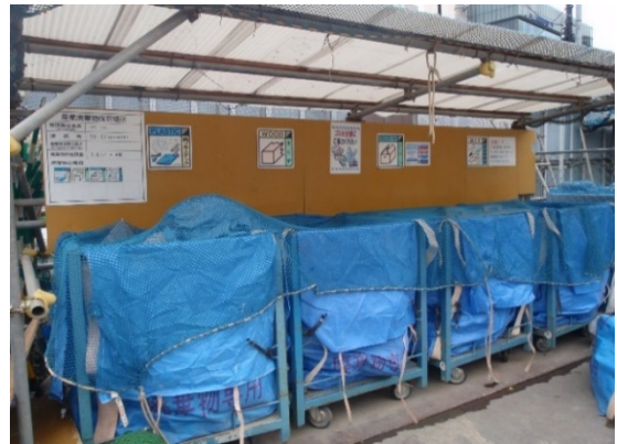
写真-2-1 副産物の分別、再資源化の状況 (地点 02)
