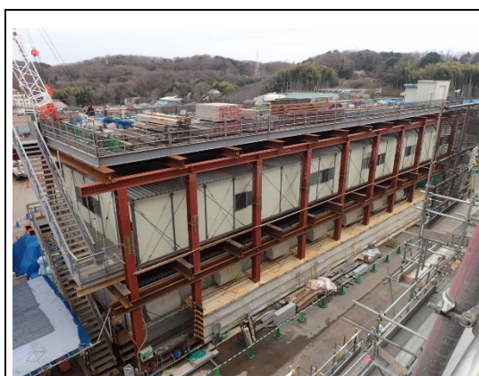
写真-1 諸設備の重層化 (地点 02)
