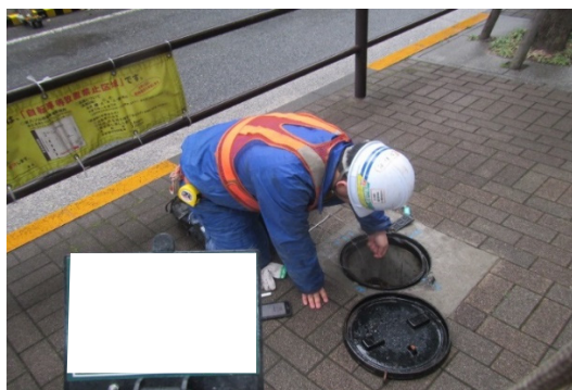
写真-7-1 地下水の監視状況（地点 01）
