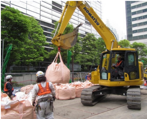
写真-3-1 発生土の仮置き状況（地点 01）
