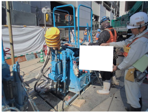
写真-2-1 薬液注入工の状況（地点 01）
