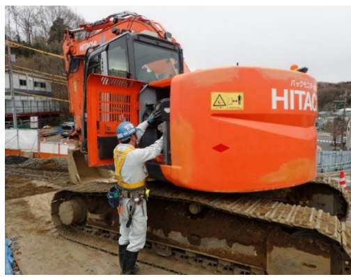
写真-1-2 建設機械の点検及び整備による性能維持状況 (地点 05)
