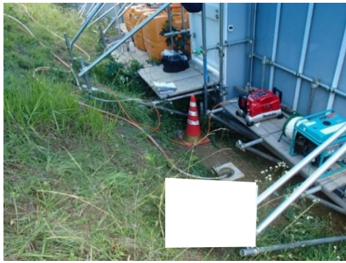
写真-10-2 地下水の監視状況（地点 05）
