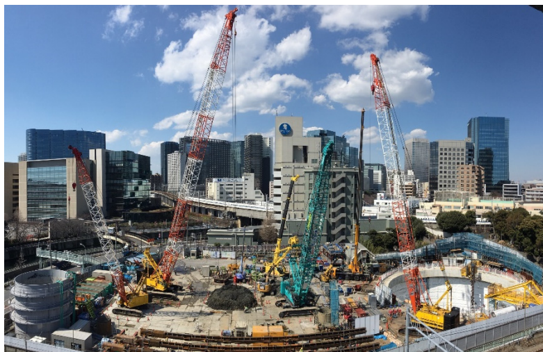
写真 3-4-2 施工状況 (平成 31 年 3 月時点当社HP公開)
