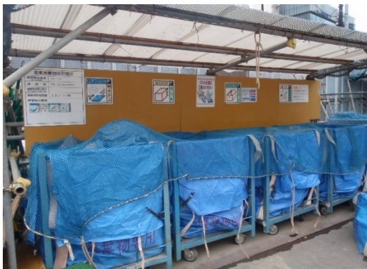
写真-5-1 副産物の分別、再資源化の状況 (地点 02)
