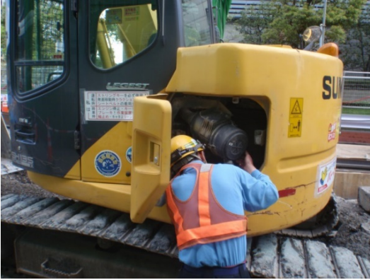
写真-2-1 建設機械の点検及び整備の状況 (地点 01)
