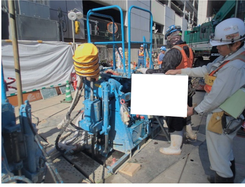
写真-8-1 薬液注入工の状況（地点 01）
