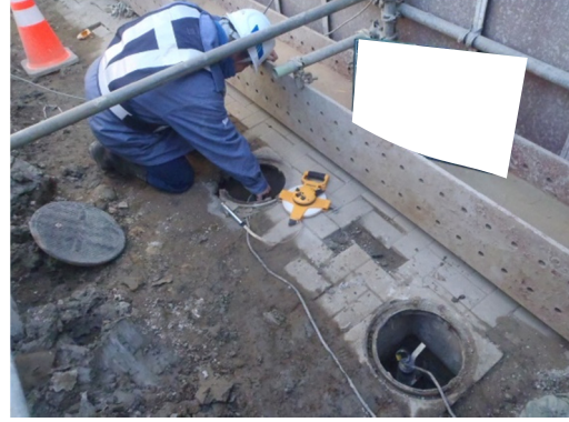
写真-10-1 地下水の監視状況（地点 03）
