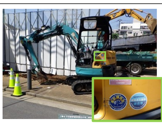
写真-1-2 排出ガス対策型建設機械の採用状況 (地点 03)
