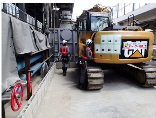
写真-1-1 建設機械の点検及び整備の状況 (地点 01)
