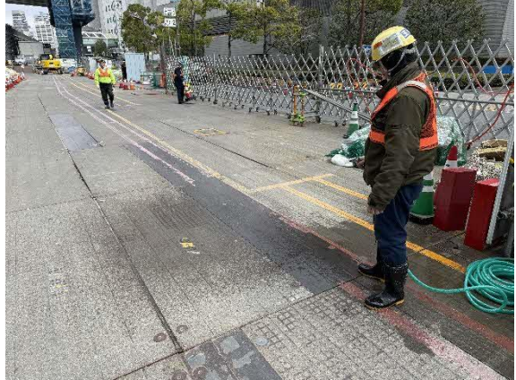
写真 4-1-1-4 工事現場の清掃、散水
