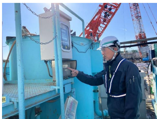
写真 4-1-4-9 工事排水の監視、工事排水の適切な処理
