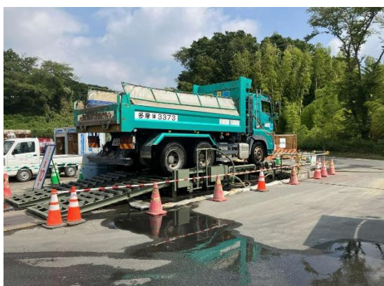
写真 4-1-4-8 資材及び機械の運搬に用いる車両の出入口等の清掃、散水及びタイヤの洗浄、外来種の拡大抑制
