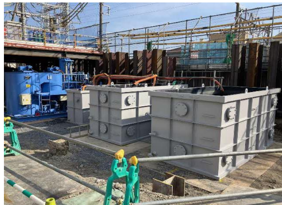
写真 4-1-3-6 工事排水の適切な処理
