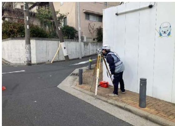
写真 4-1-3-11 山留め材及び周辺地盤の計測管理
