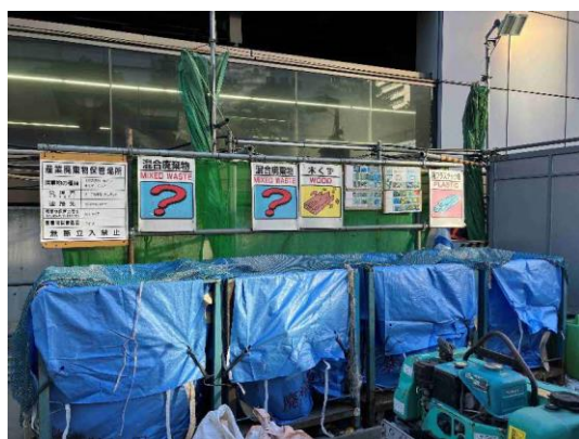
写真 4-1-1-11 副産物の分別、再資源化
