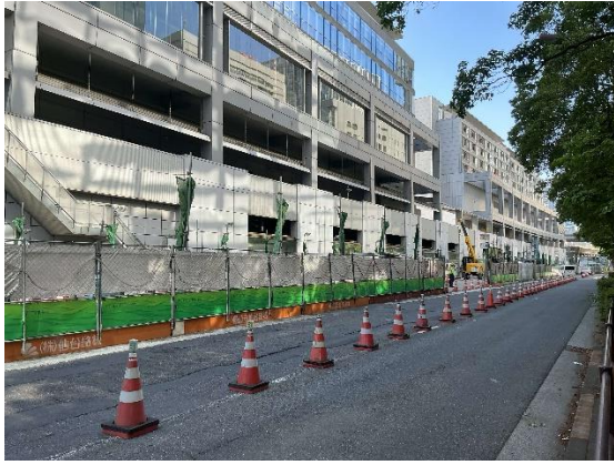
写真 4-1-1-1 仮囲い・防音シート等の設置
