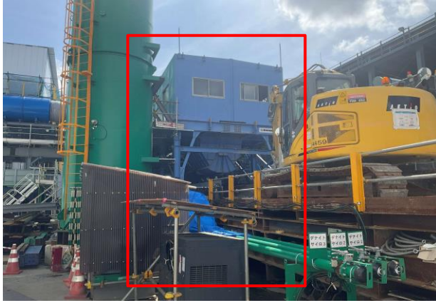
写真 4-1-5-7 工事排水の適切な処理、濁水処理施設及び仮設沈砂池の設置
