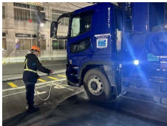
写真 4-1-2-5 工事現場の清掃、散水、資材及び機械の運搬に用いる車両の出入口、周辺道路の清掃及び散水、タイヤの洗浄
