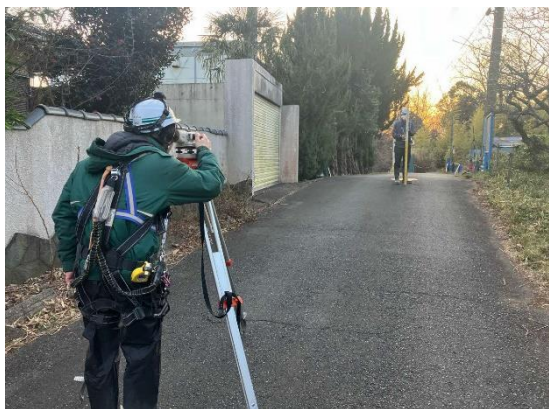
写真 4-1-4-12 山留め材及び周辺地盤の計測管理
