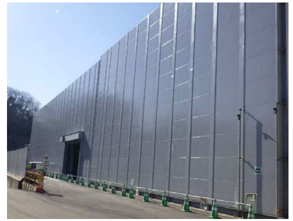
写真 4-1-5-2 仮囲い・防音シート等 (防音ハウス) の設置
