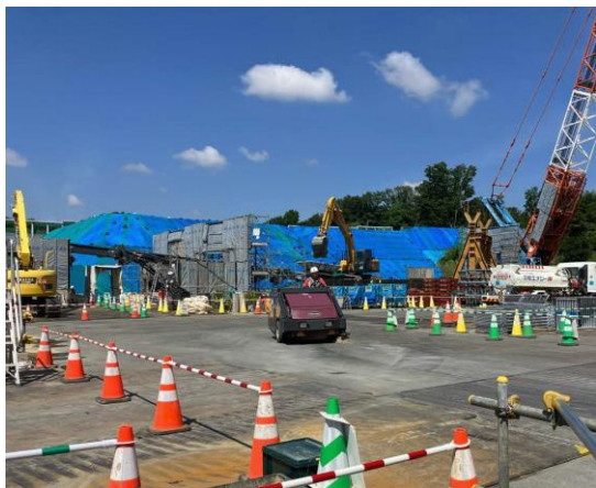
写真 4-1-4-6 工事現場の清掃及び散水
