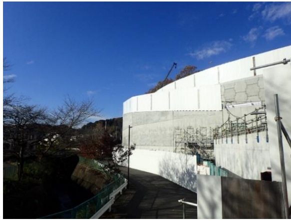
写真 4-1-5-1 仮囲い・防音シート等の設置
