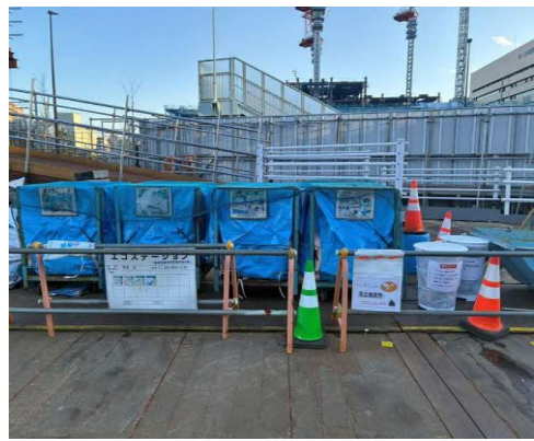
写真 4-1-2-10 副産物の分別、再資源化
