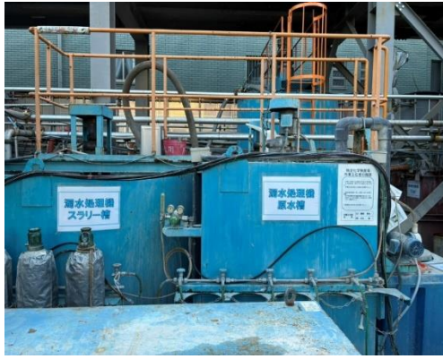
写真 4-1-2-7 工事排水の適切な処理
