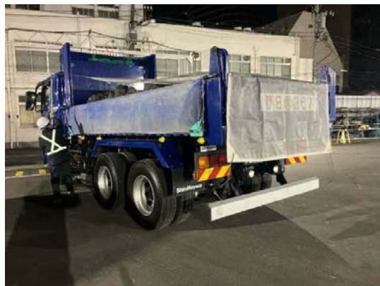
写真 4-1-2-11 荷台への防じんシート敷設及び散水
