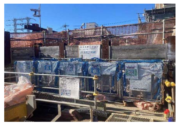
写真 4-1-3-12 副産物の分別、再資源化
