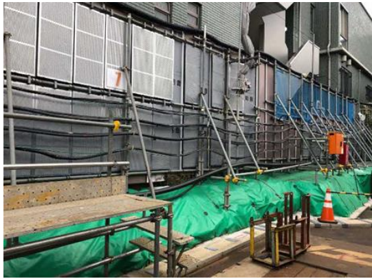
写真 4-1-2-1 仮囲い・防音シート等の設置
