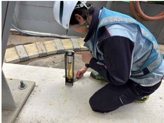
写真 4-1-2-9 工事排水の監視（透視度計による濁りの確認状況）
