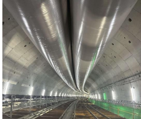
写真 4-1-2-8 適切な構造及び工法の採用 (密閉性の高いシールド工法の採用)
