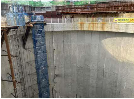
写真 4-1-3-7 止水性の高い山留め工法等の採用
