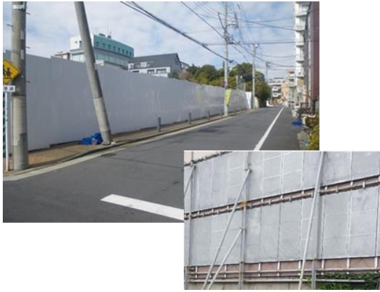
写真 4-1-3-1 仮囲い・防音シート等の設置
