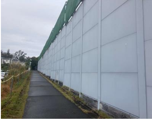
写真 4-1-4-1(1) 仮囲い・防音シート等の設置
