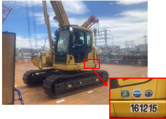
写真 4-1-3-2 排出ガス対策型建設機械の採用、低騒音型建設機械の採用
