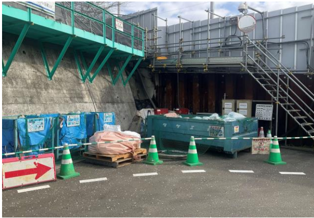
写真 4-1-5-9 副産物の分別、再資源化
