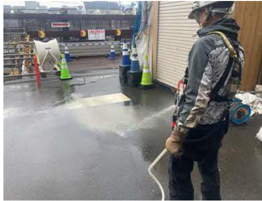
写真 4-1-3-4 工事現場の清掃、散水
