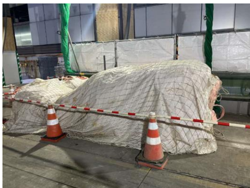
写真 4-1-1-7 資機材置き場における発生土の適切な管理
