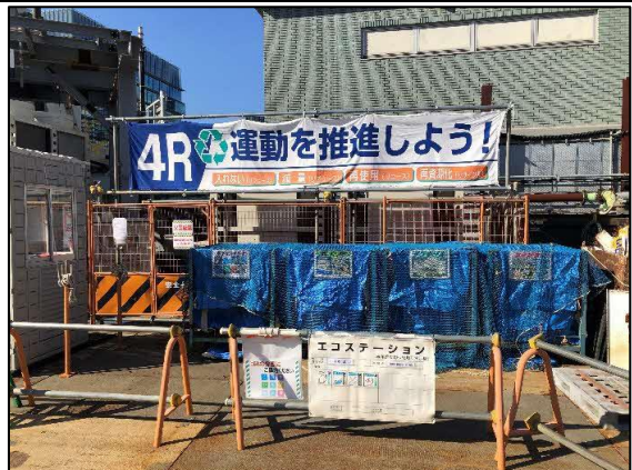
写真 4-1-2-10 副産物の分別、再資源化
