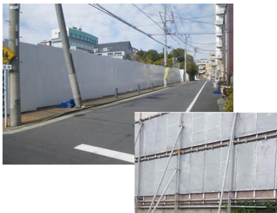
写真 4-1-4-1 仮囲い・防音シート等の設置状況
