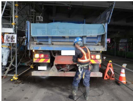
写真 4-1-1-15 資材及び機械の運搬に用いる車両の出入口、周辺道路の清掃及び散水、タイヤの洗浄
