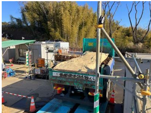
写真 4-1-5-7 荷台への防塵シート敷設
