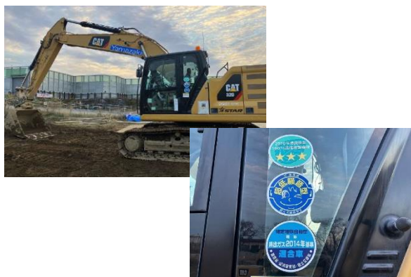
写真 4-1-5-2 排出ガス対策型建設機械の採用、低騒音型建設機械の採用
