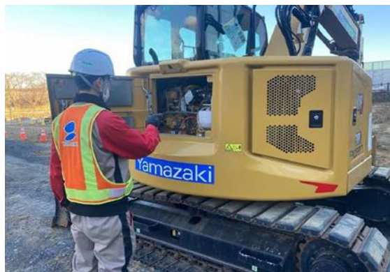
写真 4-1-5-5 建設機械の点検及び整備による性能維持
