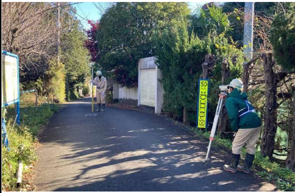
写真 4-1-5-12 山留め材及び周辺地盤の計測管理
