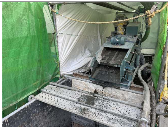
写真 4-1-1-11 建設汚泥の脱水処理
