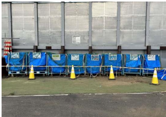
写真 4-1-5-14 副産物の分別、再資源化
