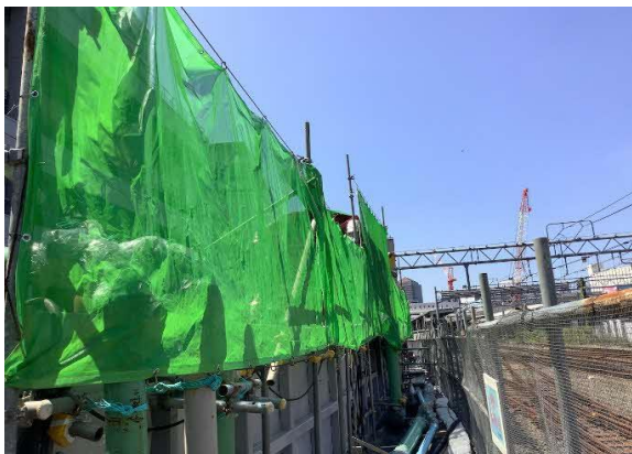
写真 4-1-1-1 仮囲い・防音シート等の設置状況
