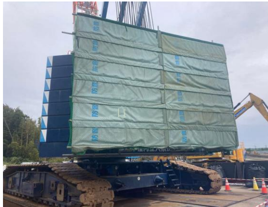
写真 4-1-5-1(2) 仮囲い・防音シート等の設置状況(エンジン周りに防音シートを設置)
