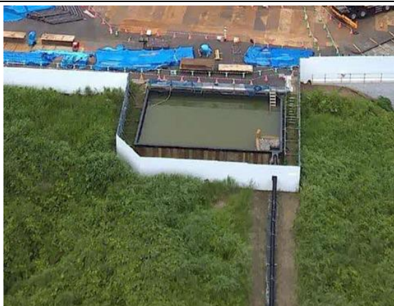
写真 4-1-7-6 工事排水の適切な処理（沈砂池の設置）
