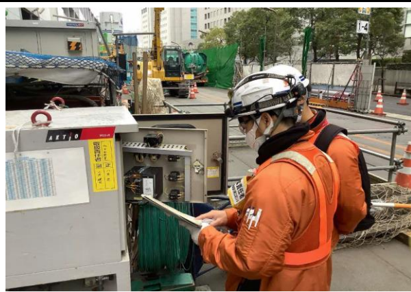
写真 4-1-1-8 処理設備の点検・整備による性能維持
