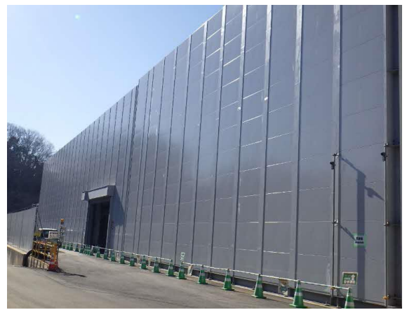
写真 4-1-6-2 仮囲い・防音シート等（防音ハウス）の設置状況
