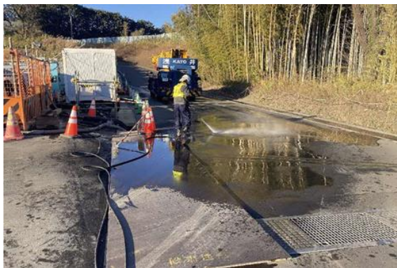
写真 4-1-5-6 工事現場の清掃及び散水
