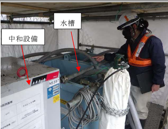
写真 4-1-1-6 工事排水の適切な処理、下水道への排水
