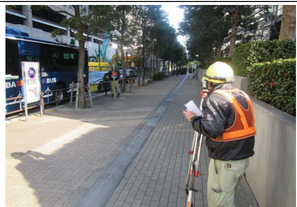
写真 4-1-1-10 山留め材及び周辺地盤の計測管理
