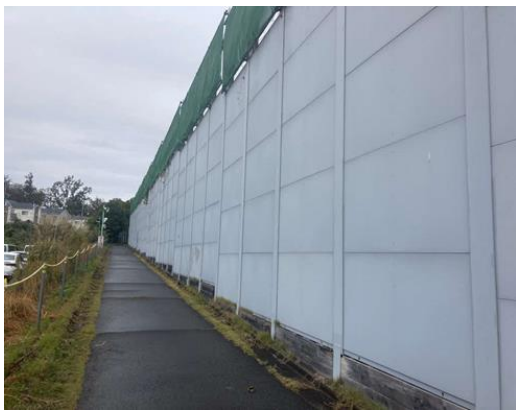
写真 4-1-5-1(1) 仮囲い・防音シート等の設置状況
