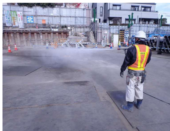
写真 4-1-4-4 工事現場の清掃、散水
