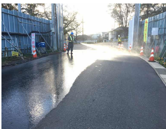
写真 4-1-7-4 工事現場の清掃、散水、資材及び機械の運搬に用いる車両の出入口、周辺道路の清掃及び散水、タイヤ洗浄
