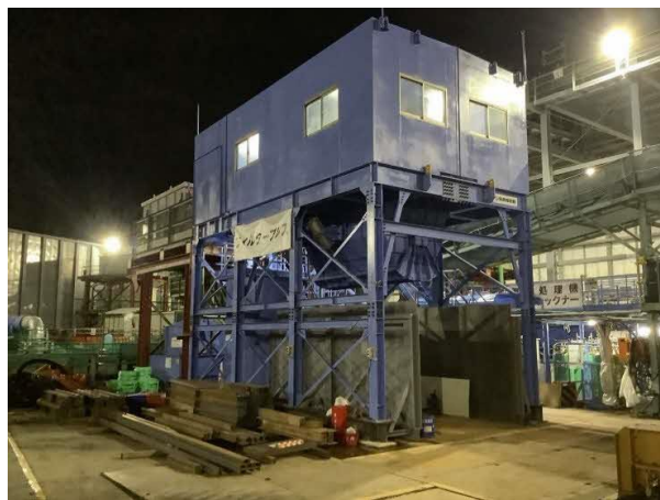
写真 4-1-6-7 工事排水の適切な処理、濁水処理施設及び仮設沈砂池の設置
