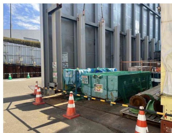
写真 4-1-6-9 副産物の分別、再資源化
