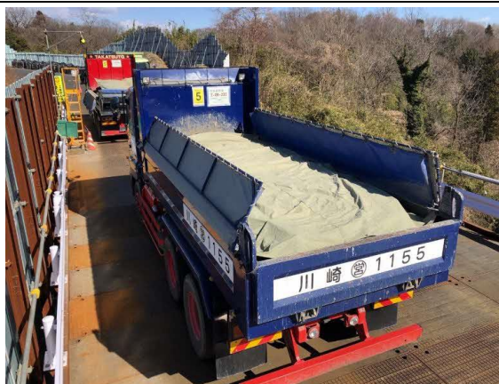
写真 4-1-7-9 荷台への防じんシート敷設及び散水
