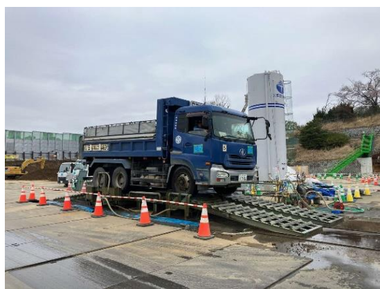
写真 4-1-5-8 散水及びタイヤの洗浄
