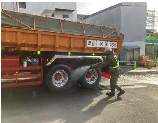
写真 4-1-4-11 資材及び機械の運搬に用いる車両の出入口、周辺道路の清掃及び散水、タイヤの洗浄
