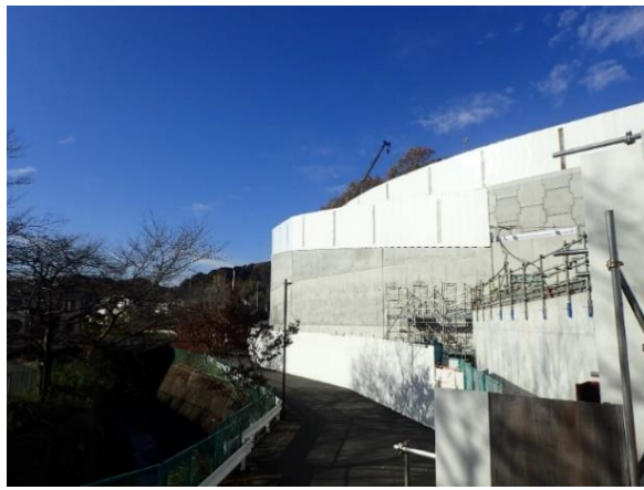
写真 4-1-6-1 仮囲い・防音シート等の設置状況
