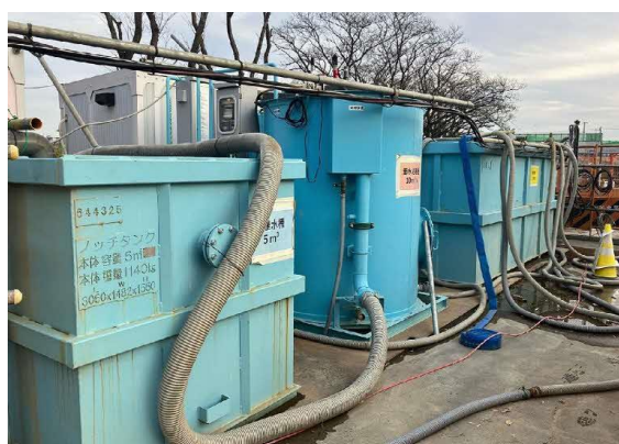
写真 4-1-5-9 下水道への排水、工事排水の監視、工事排水の適切な処理
