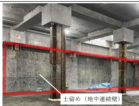
写真 4-1-3-6 止水性の高い土留め工法等の採用
