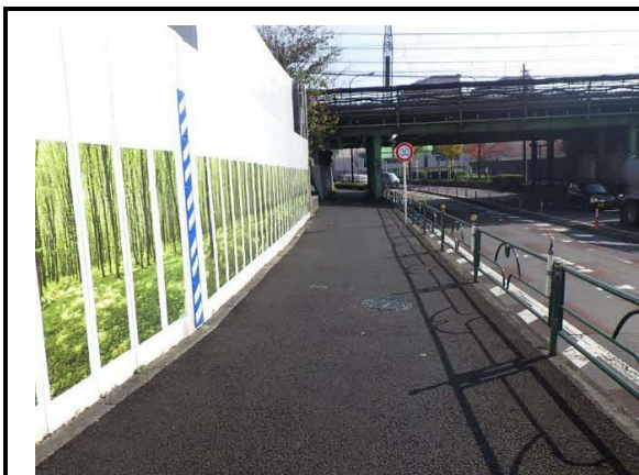
写真 4-1-3-1 仮囲い・防音シート等の設置状況
