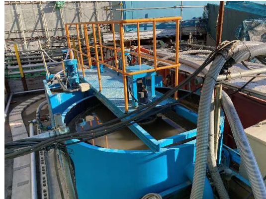
写真 4-1-2-6 工事排水の適切な処理、下水道への排水
