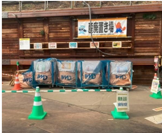
写真 4-1-7-8 副産物の分別、再資源化
