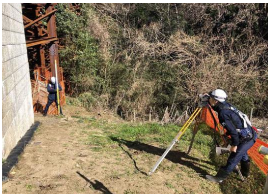
写真 4-1-7-11 周辺地盤の計測管理
