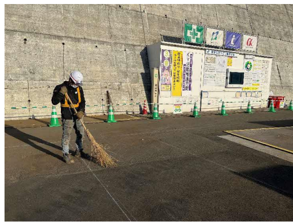
写真 4-1-6-5 工事現場の清掃、散水
