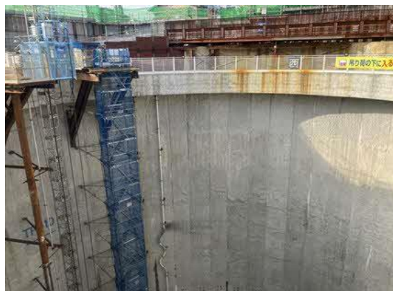
写真 4-1-4-6 止水性の高い山留め工法等の採用
