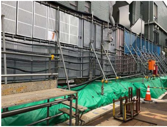
写真 4-1-2-1 仮囲い・防音シート等の設置状況
