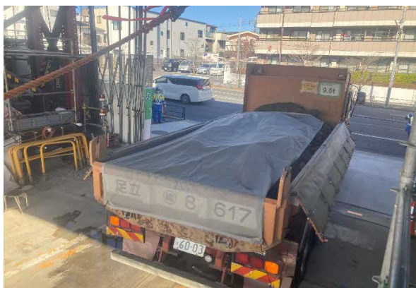
写真 4-1-4-13 荷台への防じんシート敷設
