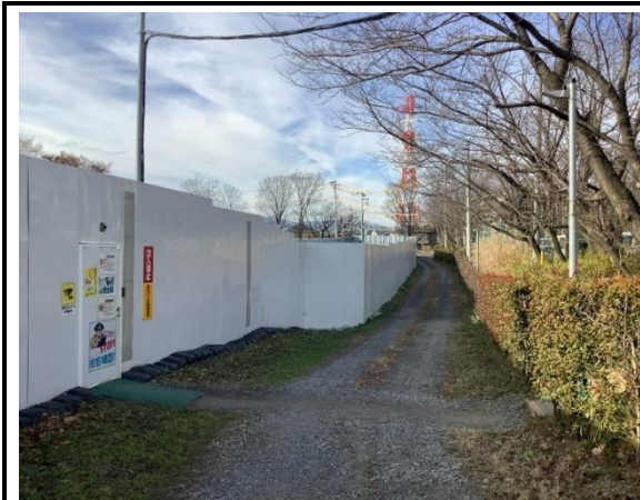
写真 4-1-7-1 仮囲い・防音シート等の設置状況
