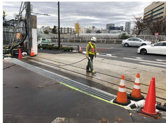
写真 4-1-2-4 工事現場の清掃、散水、資材及び機械の運搬に用いる車両の出入口、周辺道路の清掃及び散水、タイヤの洗浄
