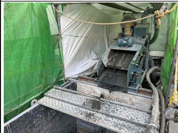
写真4-1-1-11 建設汚泥の脱水処理
