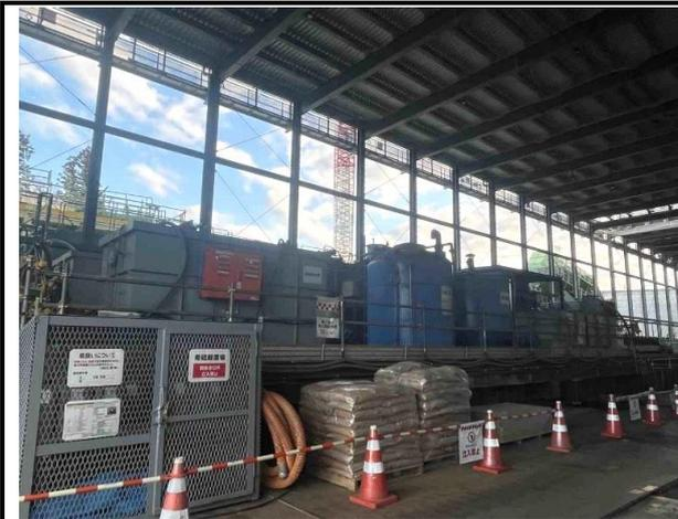
写真4-1-6-7 工事排水の適切な処理、濁水処理施設及び仮設沈砂池の設置
