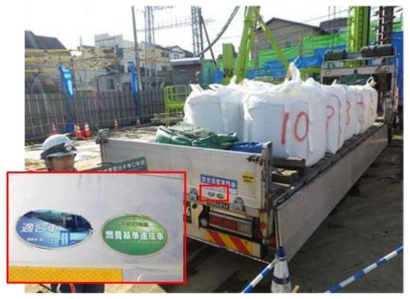
写真4-1-4-10 低燃費車種の選定、積載の効率化、運搬計画の合理化による運搬距離の最適化、低公害型の工事用車両の選定
