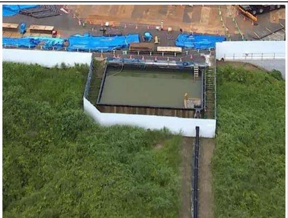
写真4-1-7-6 工事排水の適切な処理（沈砂池の設置）
