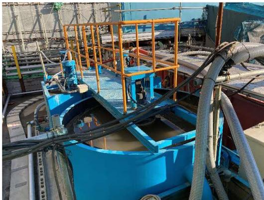
写真4-1-2-5 工事排水の適切な処理
