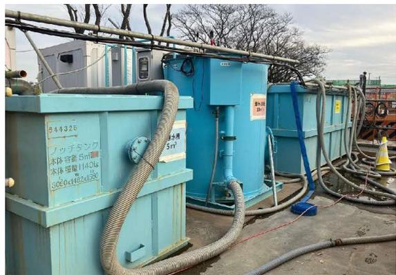
写真4-1-5-6 下水道への排水、工事排水の監視、工事排水の適切な処理
