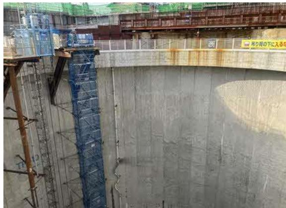
写真4-1-4-6 止水性の高い山留め工法等の採用
