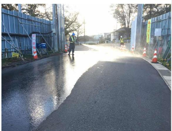
写真4-1-7-4 工事現場の清掃、散水、資材及び機械の運搬に用いる車両の出入口、周辺道路の清掃及び散水、タイヤ洗浄
