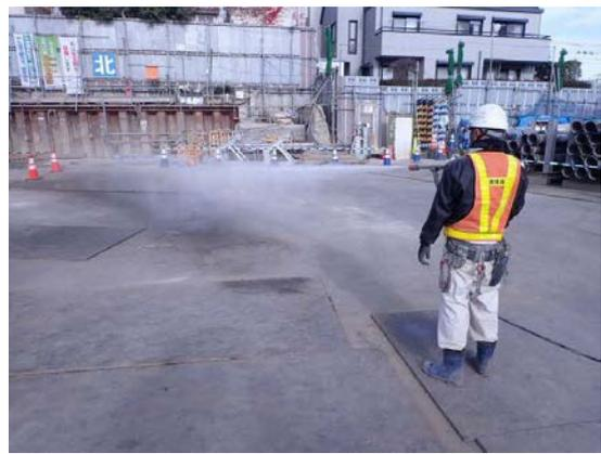
写真4-1-4-4 工事現場の清掃、散水
