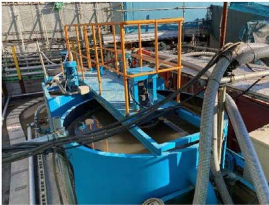
写真4-1-2-5 工事排水の適切な処理
