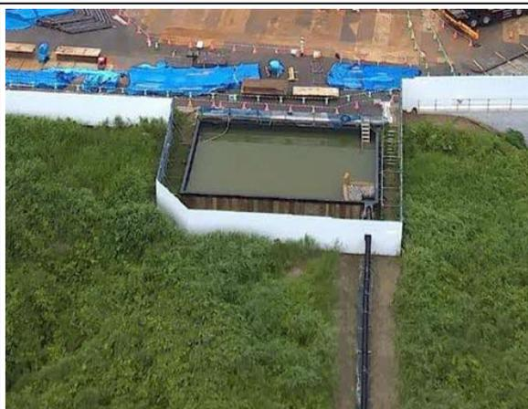
写真4-1-7-6 沈砂池の設置状況
