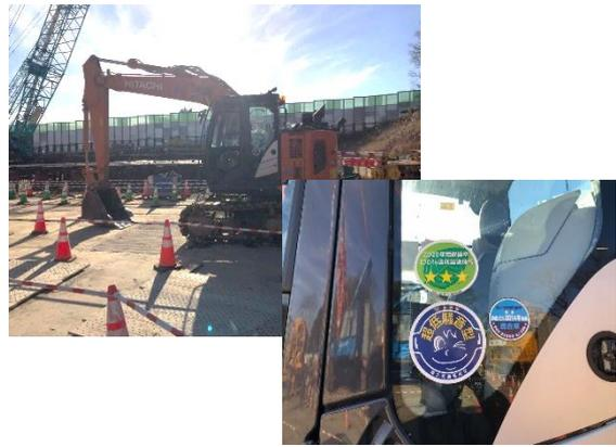
写真4-1-5-4 低騒音型建設機械の採用
