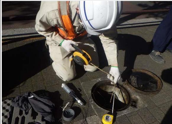
写真4-1-1-9 地下水の継続的な監視
