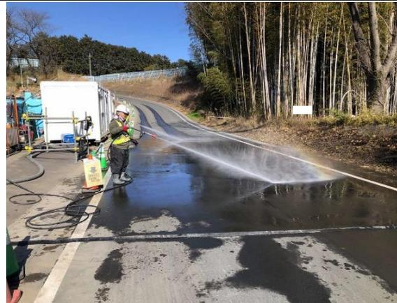
写真4-1-5-6 工事現場の清掃及び散水
