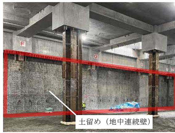
写真4-1-3-6 止水性の高い土留め工法等の採用
