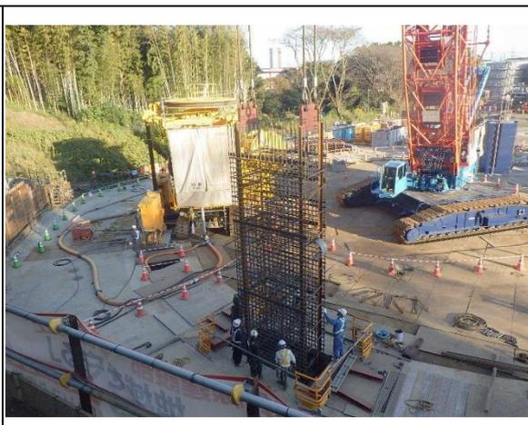
写真4-1-5-8 止水性の高い山留め工法等の採用、地質の状況等に応じた山留め工法等の採用
