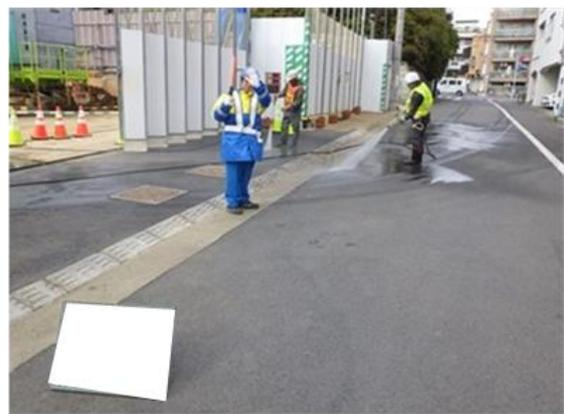
写真4-1-4-11 資材及び機械の運搬に用いる車両の出入口、周辺道路の清掃及び散水、タイヤの洗浄
