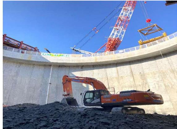
写真4-1-4-6 止水性の高い山留工法の採用
