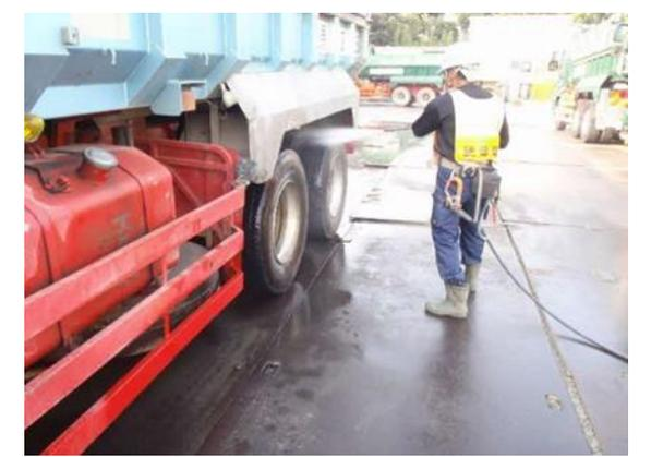
写真4-1-3-12 資材及び機械の運搬に用いる車両の出入口、周辺道路の清掃及び散水、タイヤの洗浄
