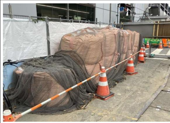
写真4-1-1-7 仮置場における発生土の適切な管理
