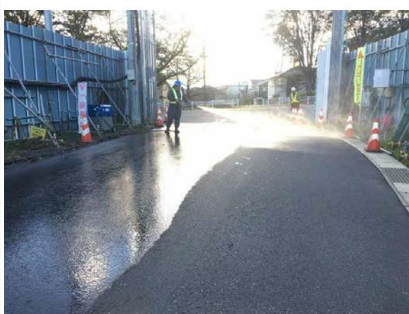
写真4-1-7-4 工事現場の清掃、散水、資材及び機械の運搬に用いる車両の出入り口、周辺道路の清掃及び散水、タイヤ洗浄
