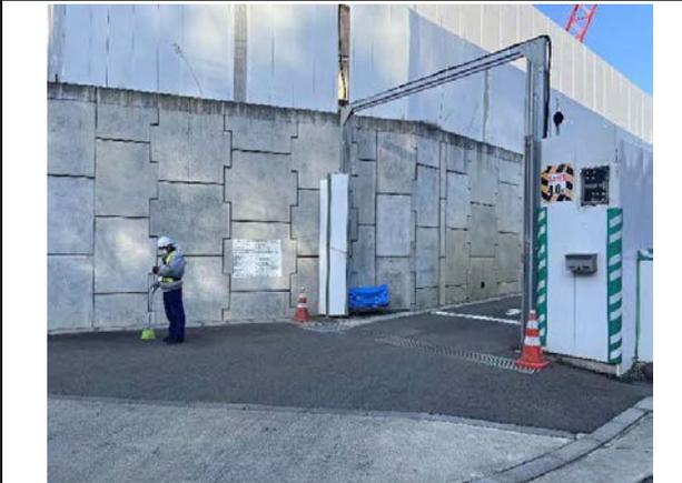
写真4-1-6-11 資材及び機械の運搬に用いる車両の出入り口、周辺道路の清掃及び散水、タイヤの洗浄
