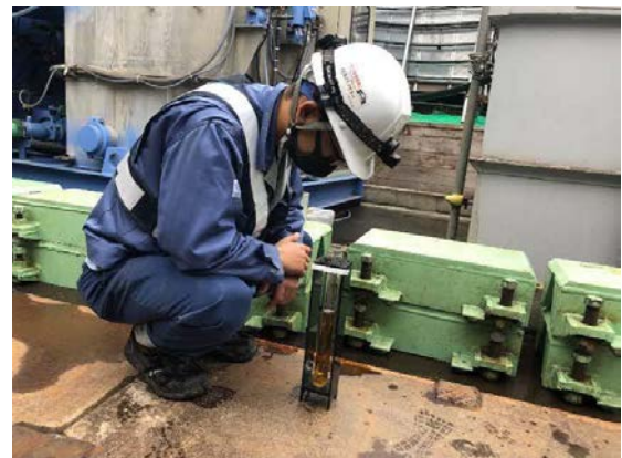
写真4-1-2-6 工事排水の監視
