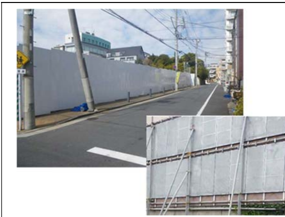
写真4-1-4-1 仮囲い・防音シート等の設置状況
