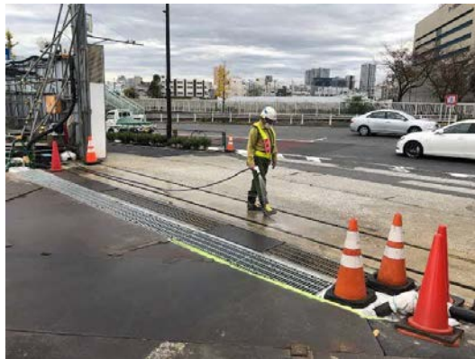
写真4-1-2-3 工事現場の清掃、散水、資材及び機械の運搬に用いる車両の出入口、周辺道路の清掃及び散水、タイヤの洗浄
