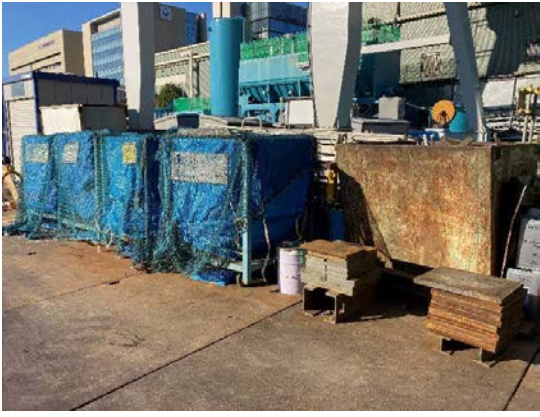
写真4-1-2-7 副産物の分別、再資源化
