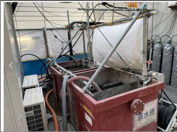
写真4-1-1-7 工事排水の適切な処理
