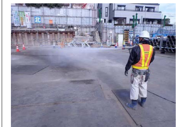
写真4-1-4-4 工事現場の清掃、散水
