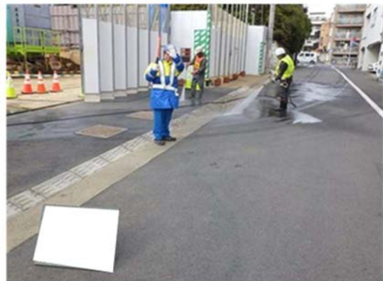
写真4-1-4-12 資材及び機械の運搬に用いる車両の出入口、周辺道路の清掃及び散水、タイヤの洗浄
