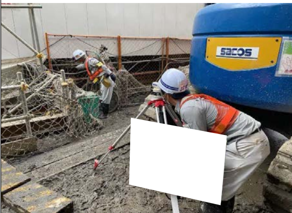
写真4-1-1-9 山留め材及び周辺地盤の計測管理
