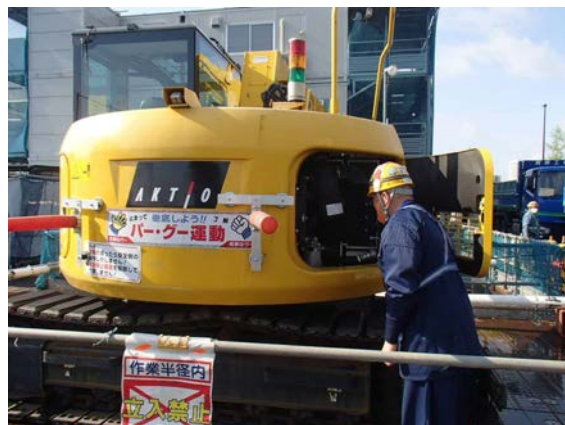
写真4-1-3-3 建設機械の点検及び整備による性能維持
