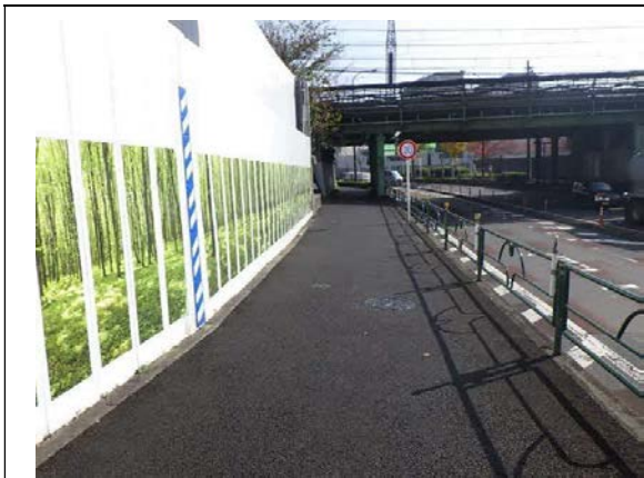
写真4-1-3-1 仮囲い・防音シート等の設置状況
