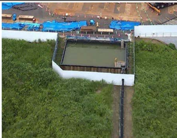
写真4-1-6-6 沈砂池の設置状況
