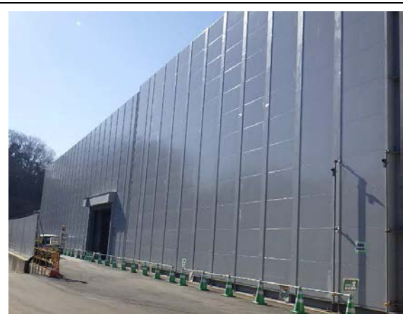
写真4-1-5-2 仮囲い・防音シート等(防音ハウス)の設置状況
