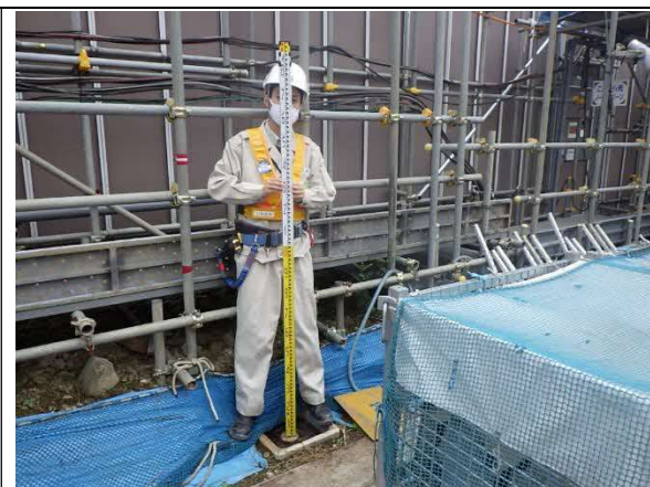
写真4-1-3-7 山留め材及び周辺地盤の計測管理
