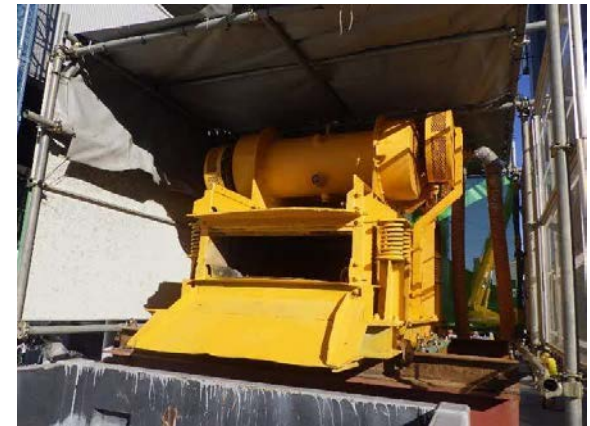
写真4-1-1-10 建設汚泥の脱水処理
