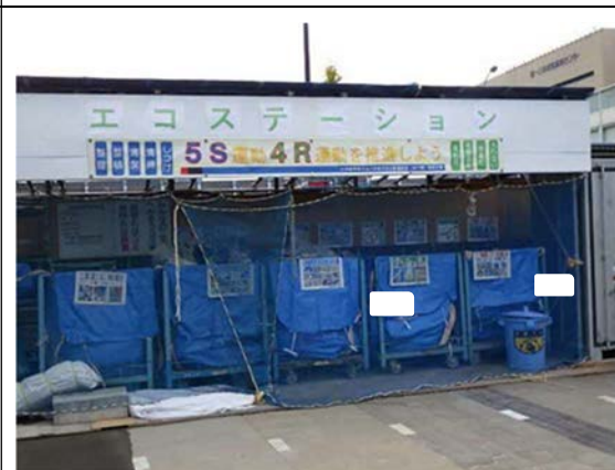
写真4-1-3-9 副産物の分別、再資源化
