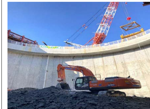
写真4-1-4-6 止水性の高いコンクリート製の土留め壁を採用
