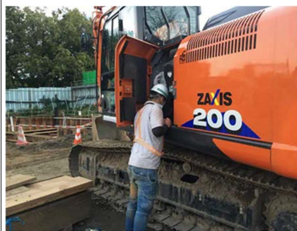
写真4-1-6-3 建設機械の点検及び整備による性能維持
