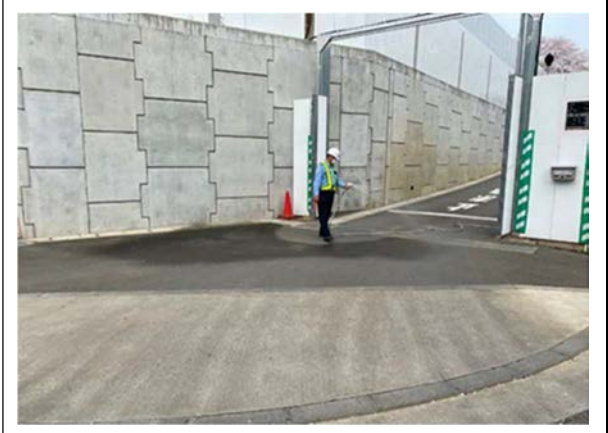
写真4-1-5-12 資材及び機械の運搬に用いる車両の出入り口、周辺道路の清掃及び散水、タイヤの洗浄
