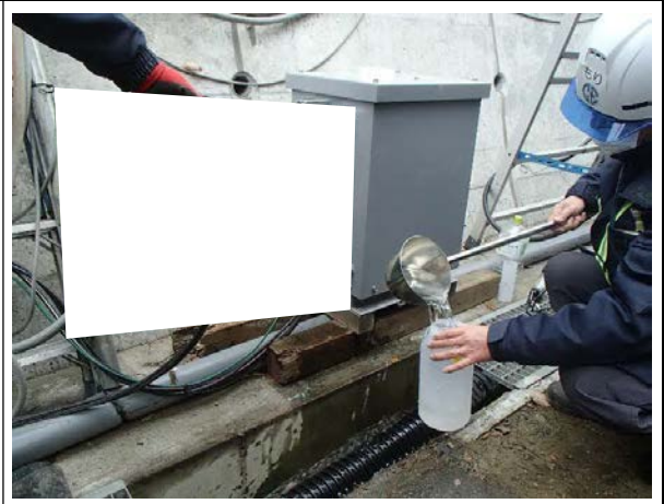
写真4-1-5-8 工事排水の監視
