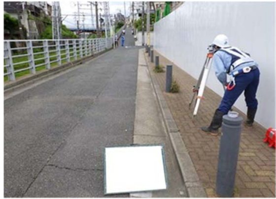
写真4-1-4-8 山留め材及び周辺地盤の計測管理
