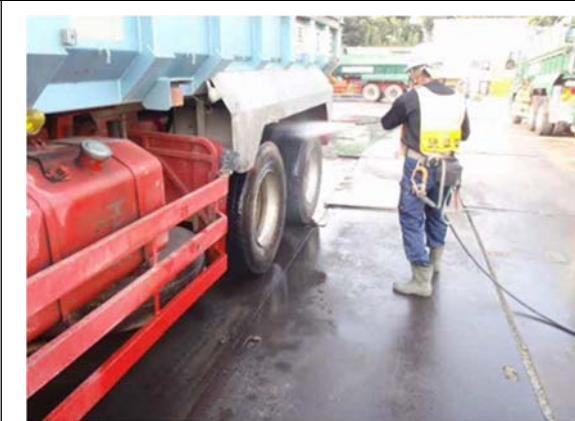
写真4-1-3-11 資材及び機械の運搬に用いる車両の出入口、周辺道路の清掃及び散水、タイヤの洗浄
