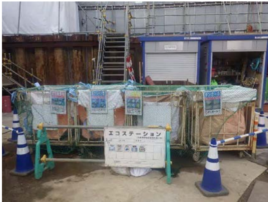
写真4-1-4-9 副産物の分別、再資源化
