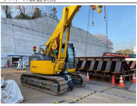
写真4-1-5-4 建設機械の点検及び整備による性能維持
