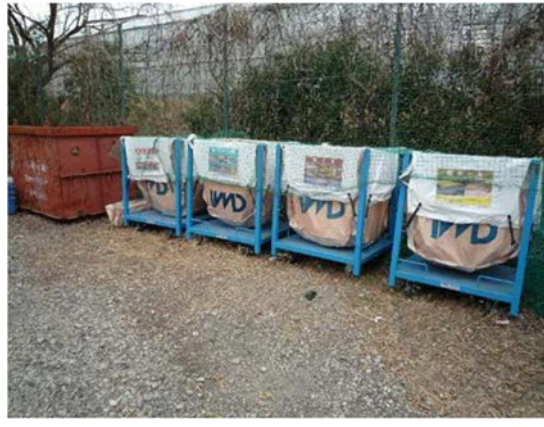
写真4-1-6-8 副産物の分別、再資源化
