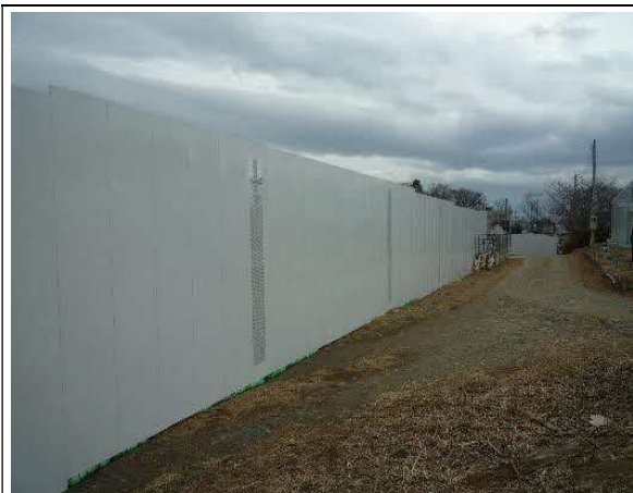
写真4-1-6-1 仮囲い・防音シート等の設置状況
