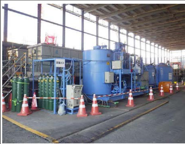
写真4-1-5-7 工事排水の適切な処理、濁水処理施設及び仮設沈砂池の設置
