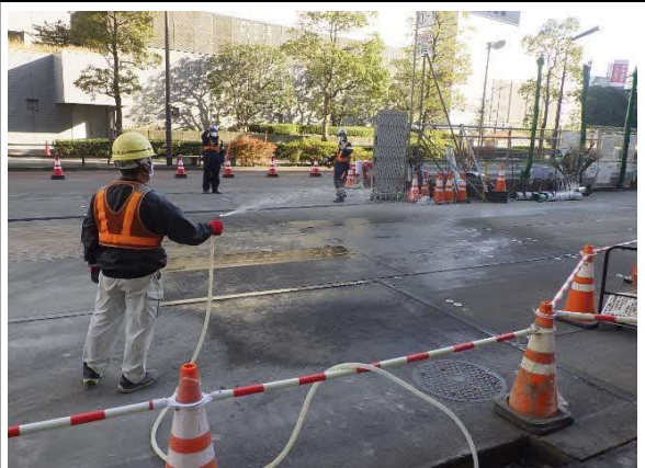
写真4-1-1-5 工事現場の清掃、散水
