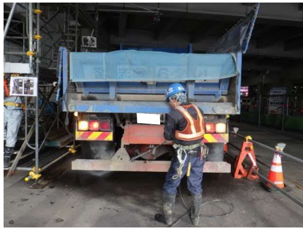
写真4-1-1-14 資材及び機械の運搬に用いる車両の出入口、周辺道路の清掃及び散水、タイヤの洗浄
