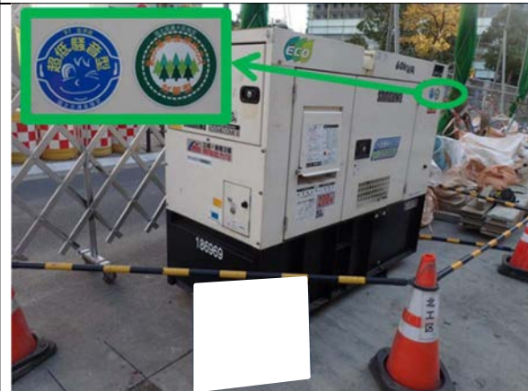
写真4-1-1-3 低騒音型建設機械の採用
