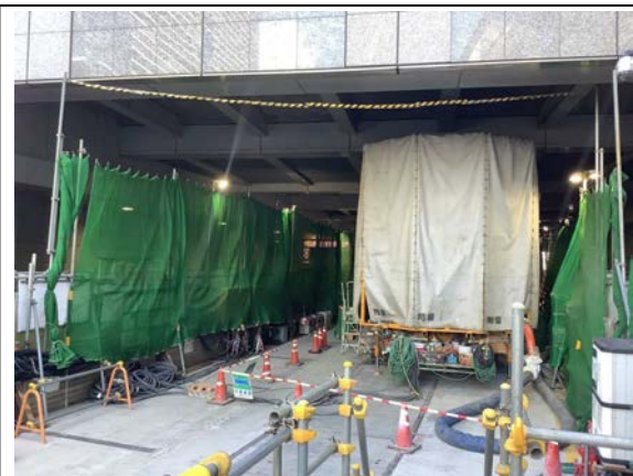
写真4-1-1-1 仮囲い・防音シート等の設置状況
