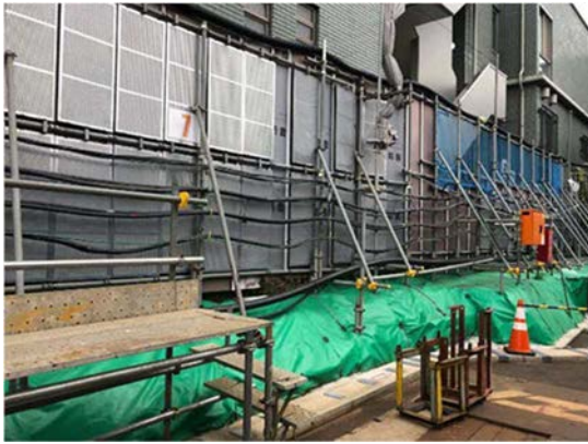
写真4-1-2-1 仮囲い・防音シート等の設置状況
