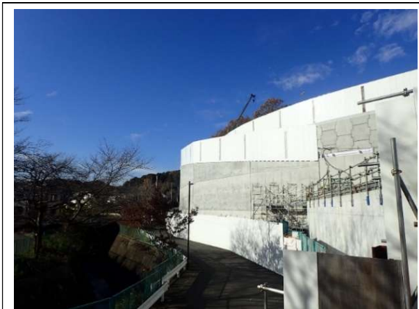
写真4-1-5-1 仮囲い・防音シート等の設置状況
