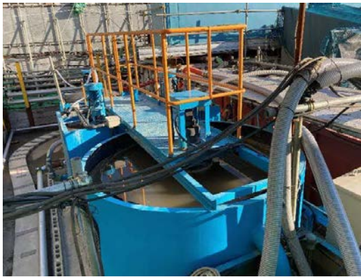
写真4-1-2-5 工事排水の適切な処理
