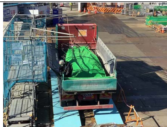
写真4-1-3-10 荷台への防じんシート敷設及び散水
