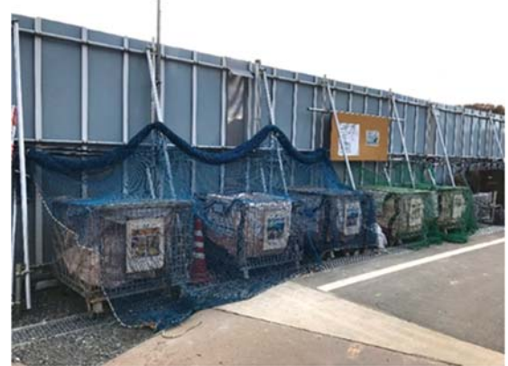
写真4-1-5-10 副産物の分別、再資源化
