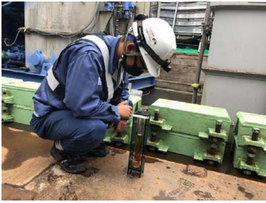
写真4-1-2-7 工事排水の監視
