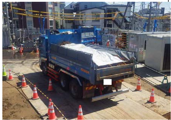
写真4-1-4-12 荷台への防じんシート敷設及び散水
