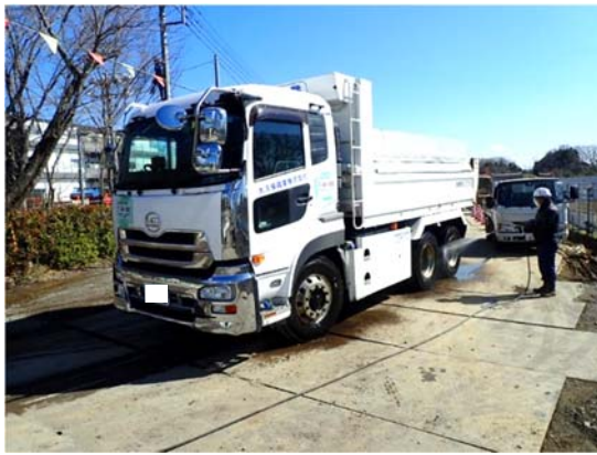
写真4-1-7-7 外来種の拡大抑制、資材及び機械の運搬に用いる車両の出入口、周辺道路の清掃及び散水、タイヤの洗浄
