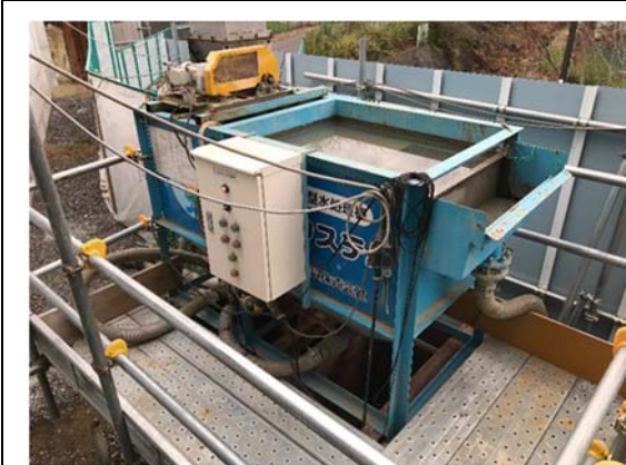
写真4-1-6-7 工事排水の適切な処理
