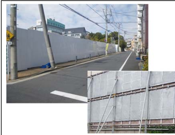
写真4-1-4-1 仮囲い・防音シート等の設置
