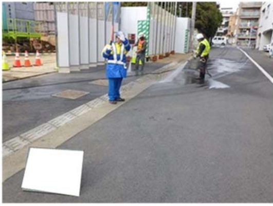
写真4-1-4-13 資材及び機械の運搬に用いる車両の出入口、周辺道路の清掃及び散水、タイヤの洗浄
