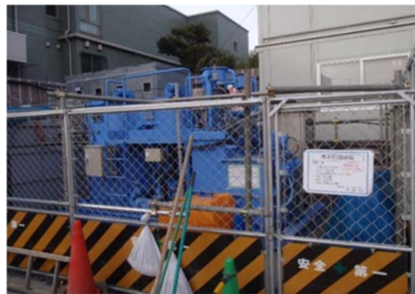
写真4-1-3-6 工事排水の適切な処理
