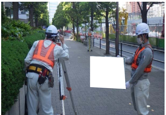
写真4-1-1-11 山留め材及び周辺地盤の計測管理
