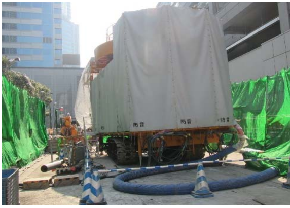
写真4-1-1-1 仮囲い・防音シート等の設置
