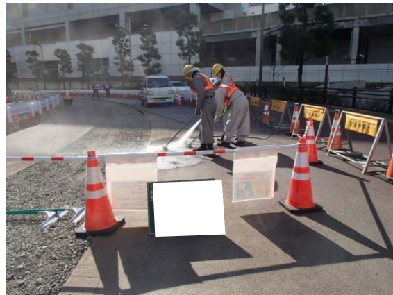
写真4-1-1-5 工事現場の清掃、散水
