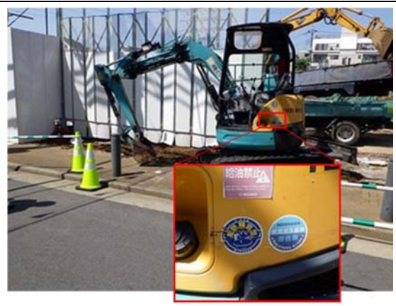
写真4-1-4-2 排出ガス対策型建設機械の採用、低騒音型建設機械の採用
