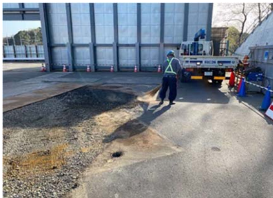
写真4-1-6-5 工事現場の清掃、散水
