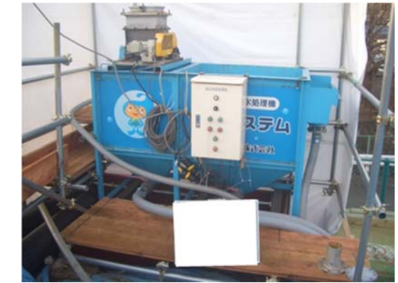
写真4-1-5-6 工事排水の適切な処理
