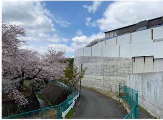
写真4-1-6-1 仮囲い・防音シート等の設置
