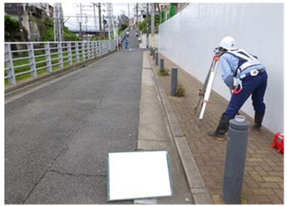
写真4-1-4-8 山留め材及び周辺地盤の計測管理
