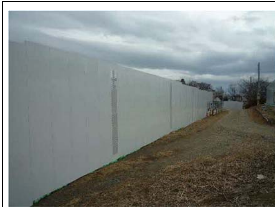
写真4-1-7-1 仮囲い・防音シート等の設置
