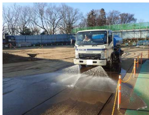
写真4-1-7-4 工事現場の清掃、散水
