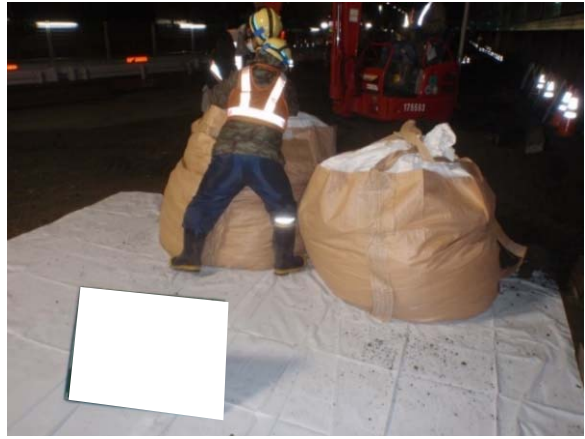
写真4-1-1-8 仮置場における発生土の適切な管理
