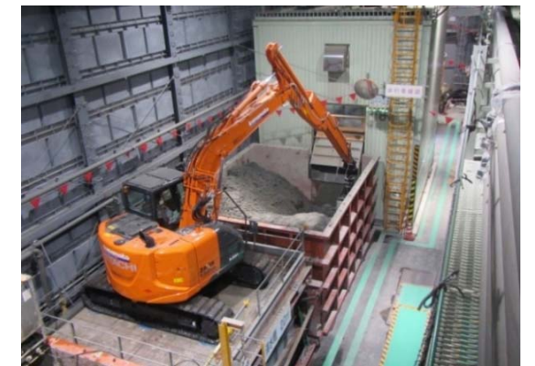
写真4-1-1-12 建設汚泥の脱水処理
