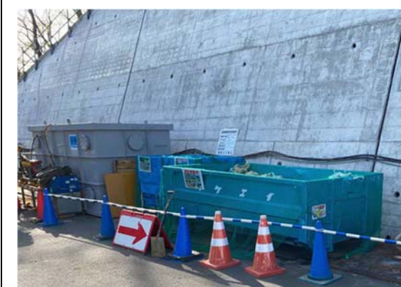
写真4-1-6-9 副産物の分別、再資源化
