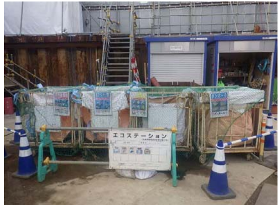
写真4-1-4-10 副産物の分別、再資源化
