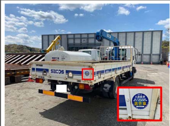
写真4-1-6-11 低公害型の工事用車両の選定
