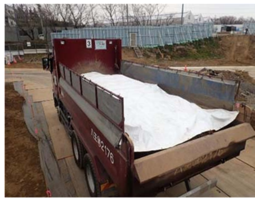
写真4-1-7-10 荷台への防じんシート敷設及び散水
