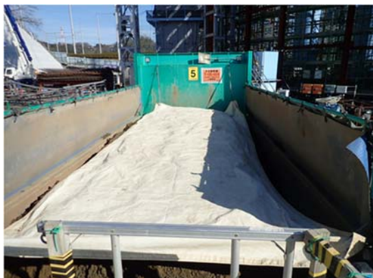
写真4-1-5-11 荷台への防じんシート敷設及び散水
