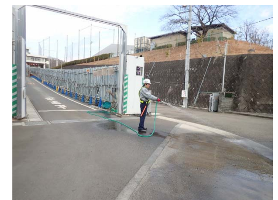
写真4-1-5-12 資材及び機械の運搬に用いる車両の出入口、周辺道路の清掃及び散水、タイヤの洗浄
