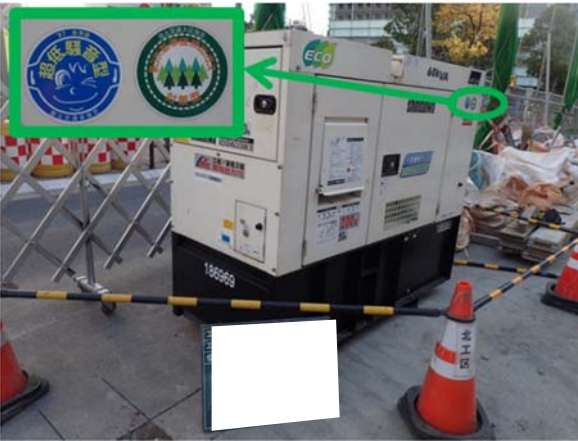
写真4-1-1-3 低騒音型建設機械の採用
