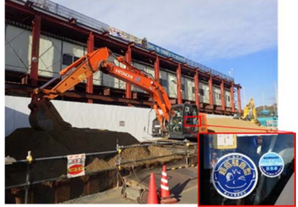
写真4-1-5-2 排出ガス対策型建設機械の採用、低騒音型建設機械の採用
