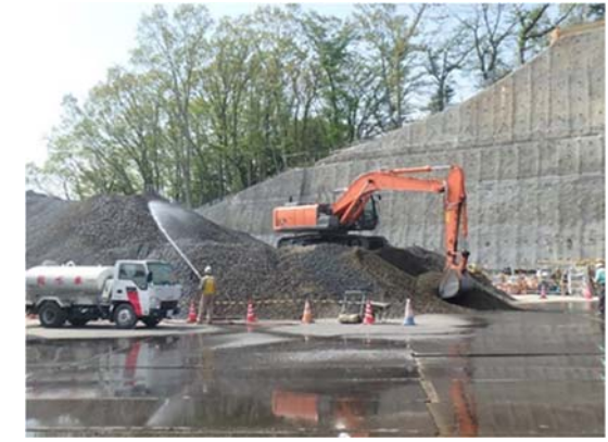
写真4-1-5-4 工事現場の清掃、散水
