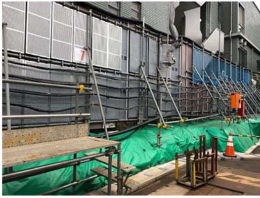
写真4-1-2-1 仮囲い・防音シート等の設置
