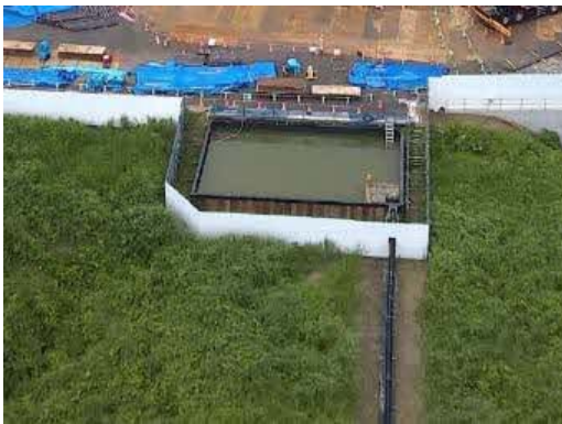
写真4-1-7-11 沈砂池の設置
