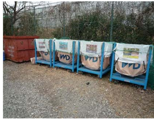
写真4-1-7-8 副産物の分別、再資源化
