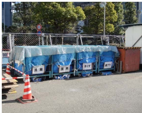
写真4-1-1-14 副産物の分別、再資源化
