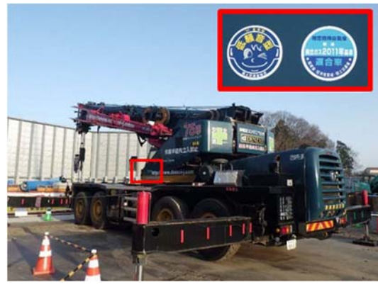
写真4-1-6-2 排出ガス対策型建設機械の採用、 低騒音型建設機械の採用
