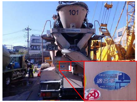
写真4-1-4-14 低公害型の工事用車両の選定
