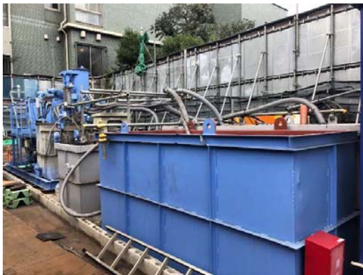
写真4-1-2-5 工事排水の適切な処理
