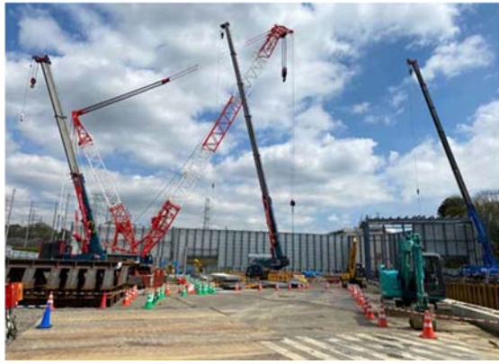
写真4-1-6-3 工事規模に合わせた建設機械の 設定
