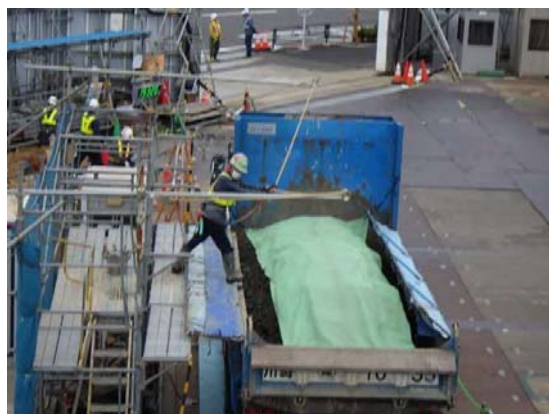
写真4-1-3-11 荷台への防じんシート敷設及び散水
