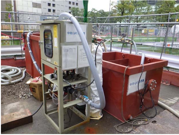
写真4-1-1-7 工事排水の適切な処理
