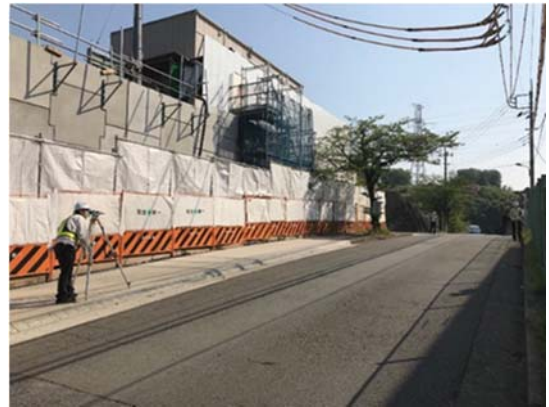
写真4-1-5-8 山留め材及び周辺地盤の計測管理
