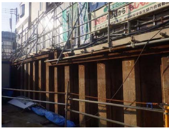
写真4-1-4-7 地質の状況等に応じた山留め工法等の採用
