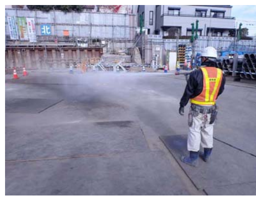
写真4-1-4-4 工事現場の清掃、散水
