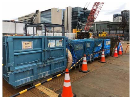
写真4-1-2-8 副産物の分別、再資源化
