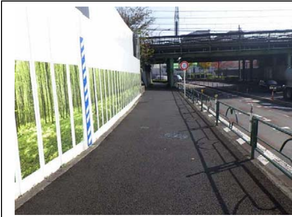
写真4-1-3-1 仮囲い・防音シート等の設置
