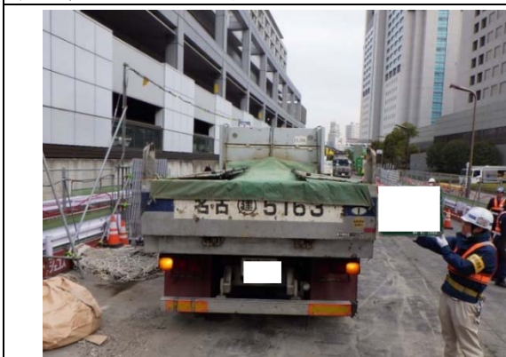
写真4-1-1-15 荷台への防じんシート敷設及び散水
