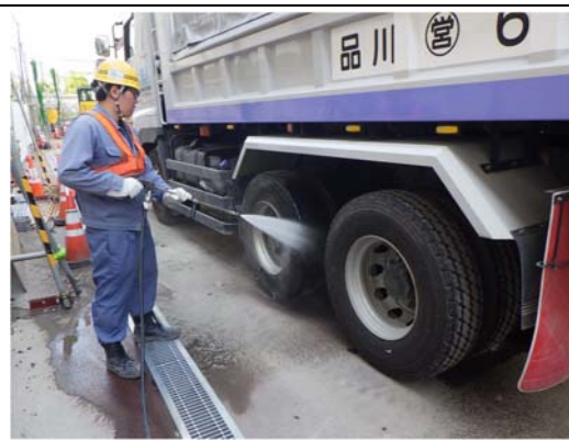
写真4-1-1-16 資材及び機械の運搬に用いる車両の出入口、周辺道路の清掃及び散水、タイヤの洗浄
