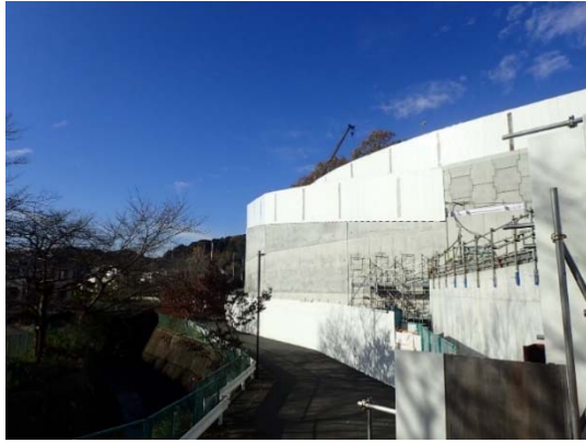
写真4-1-5-1 仮囲い・防音シート等の設置
