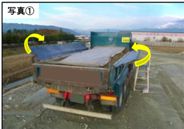
荷台への防じんシートの敷設
