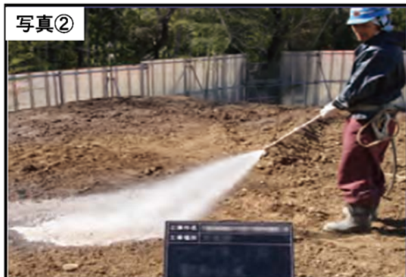
工事施工ヤード等の清掃、散水
