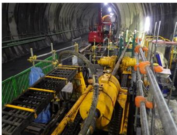
施工写真（山梨工区）
