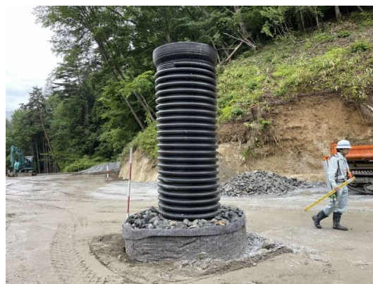
写真 1 水平排水工及び縦排水工の例
