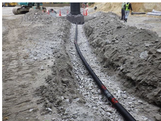
写真 1 水平排水工及び縦排水工の例
