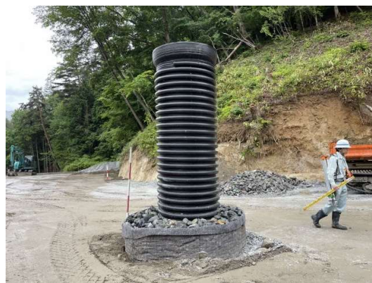
写真 3 水平排水工及び縦排水工の例
