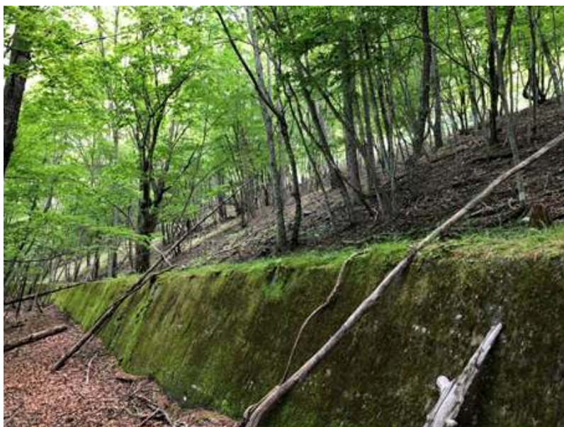
写真 5 藤島発生土置き場現地状況
