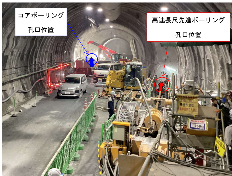
図 1 高速長尺先進ボーリングとコアボーリングの実施状況
