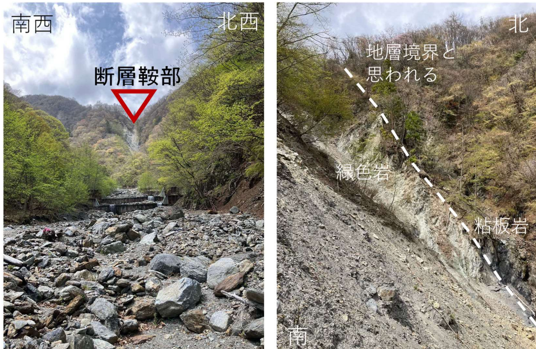
写真 3 調査 2 地点断層鞍部遠望と露頭状況
