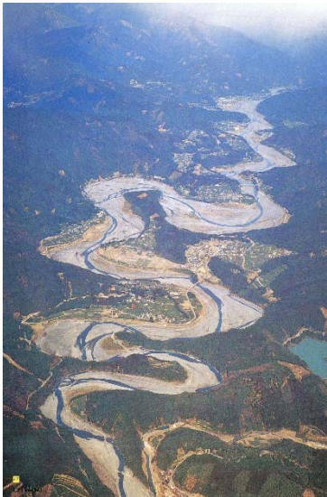
写真 2.2 中下流域の「鶴山の七曲り」
