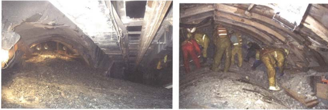
写真 7-4 飛驒トンネル TBM 土砂崩落復旧状況
