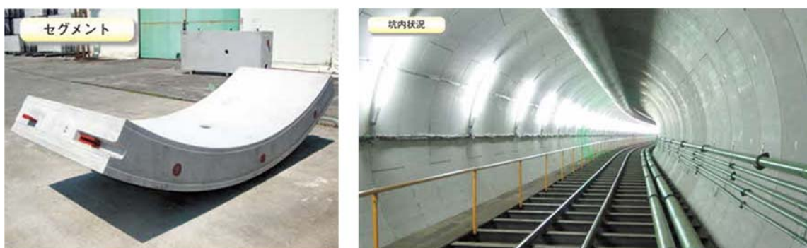
写真 7-5 コンクリートセグメント
