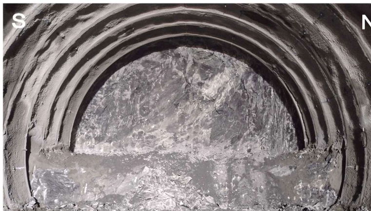
写真 7 先進坑 2 k 7 7 2 mにおける切羽状況
