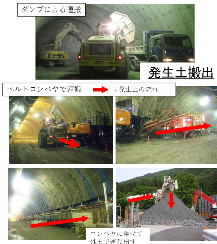
写真 2 発生土の搬出状況
