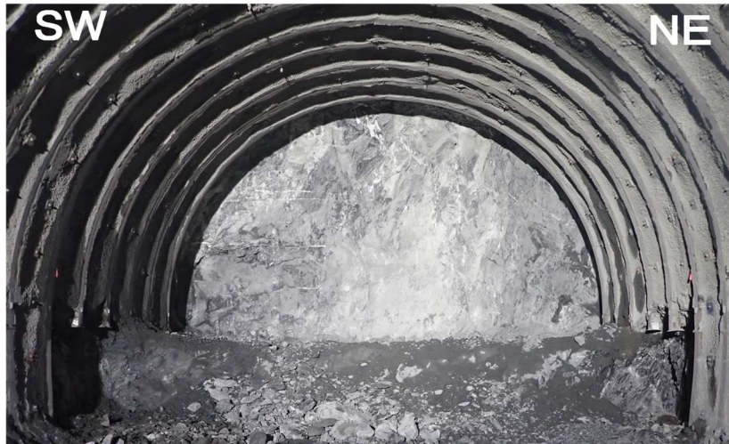
写真 6 広河原斜坑 3 k 6 9 9 mにおける切羽状況
