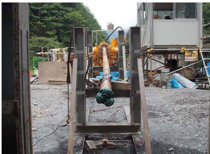
写真 4 高速長尺先進ボーリング（山梨工区）
