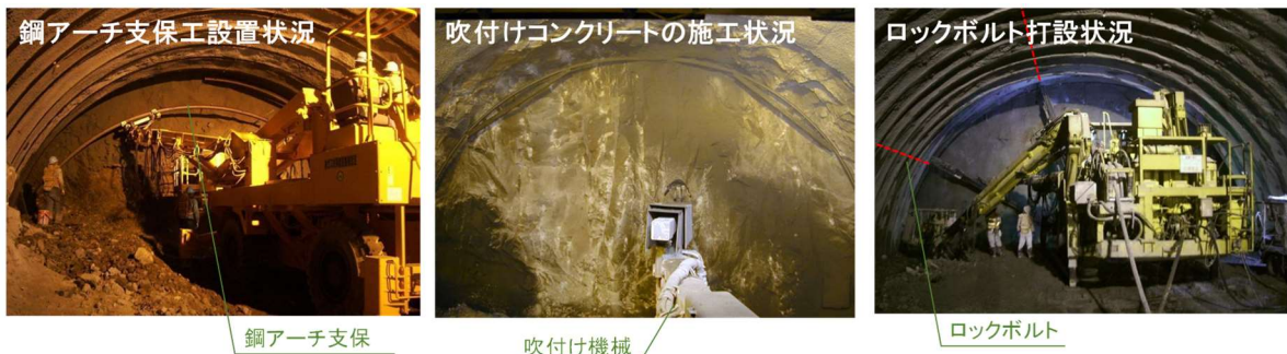
写真 3 支保工の施工状況
