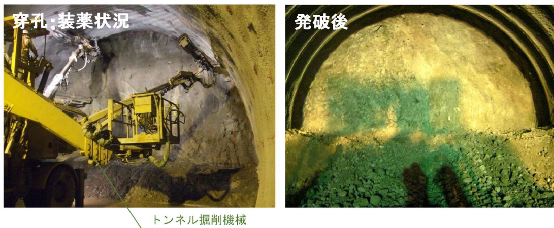
写真 1 トンネル切羽面での装薬状況及び発破後の状況
