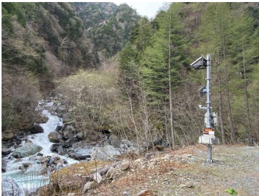
図44.監視カメラによる流況の常時監視状況（悪沢）
