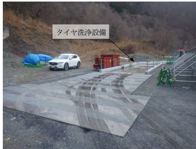
図 3-6 資材及び機械の運搬に用いる車両の運行による影響を低減するための環境保全措置 (林道東俣線 沼平ゲートでのタイヤ洗浄設備の設置状況)
