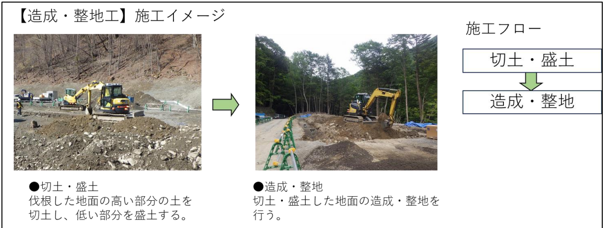
図 1-4(1) 造成・整地（写真は静岡県内の宿舎等工事での事例）
