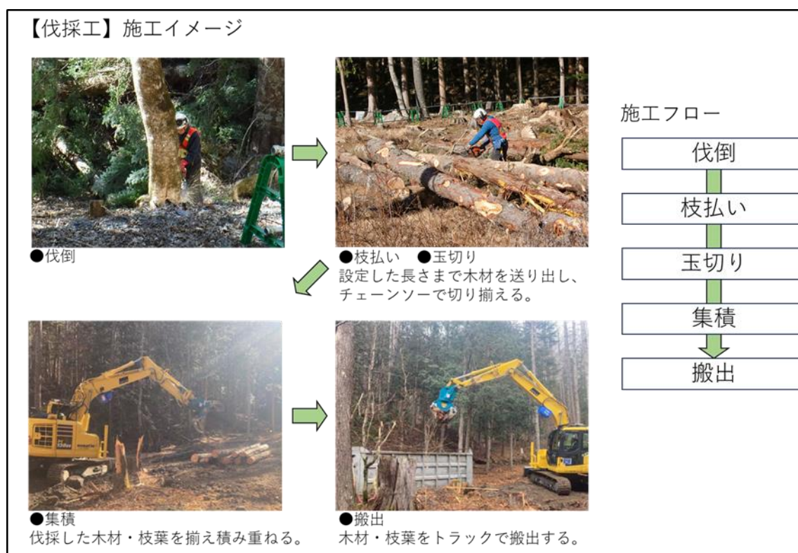
図 1-3 伐採（写真は静岡県内の宿舍等工事での事例）
