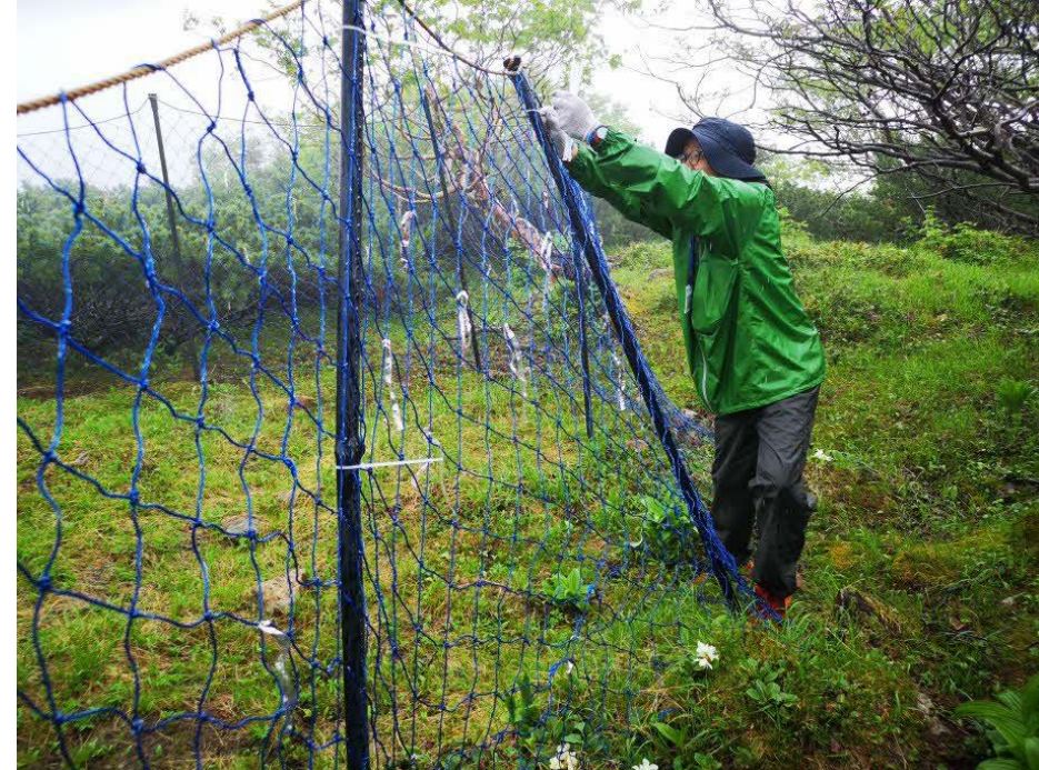
社員ボランティアによる防鹿柵設置の様子
