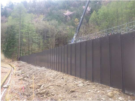
写真 5-1-1(1) 仮囲い（安全鋼板）の設置状況
