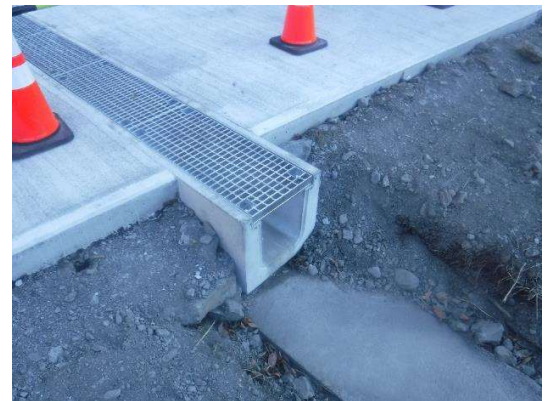
写真 5-1-4(2) 排水溝（横断溝）の設置状況
