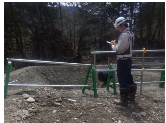
写真 5-1-3 処理設備の点検状況
