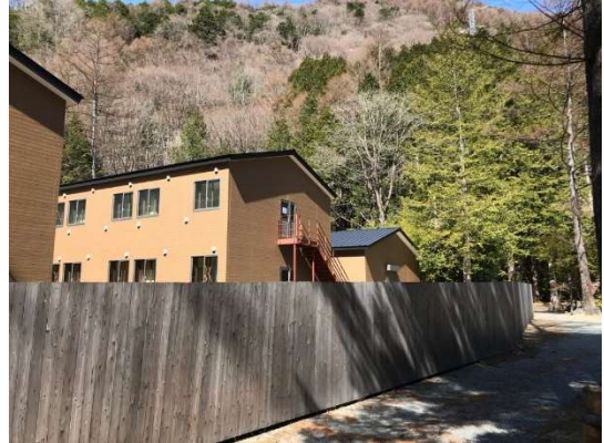
写真 5-1-1(2) 仮囲い（木製）の設置状況
