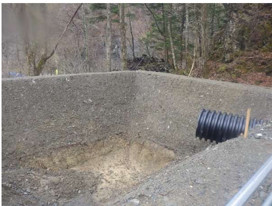
写真 5-1-2 仮設沈砂池の設置状況
