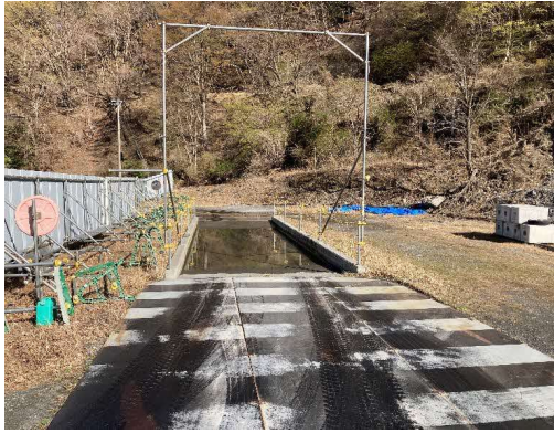
写真 5-1-5 タイヤ洗浄の実施状況
