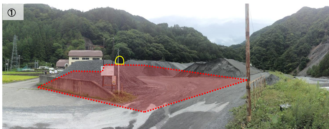
図 2-2 小渋川非常口の工事前の状況
