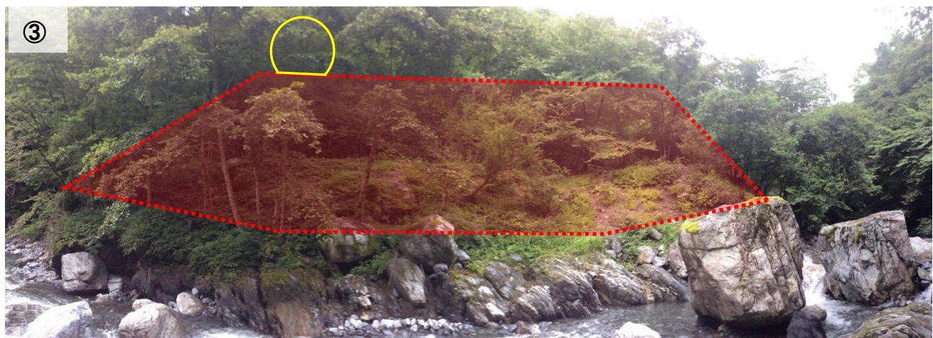
図 2-4 釜沢非常口の工事前の状況
