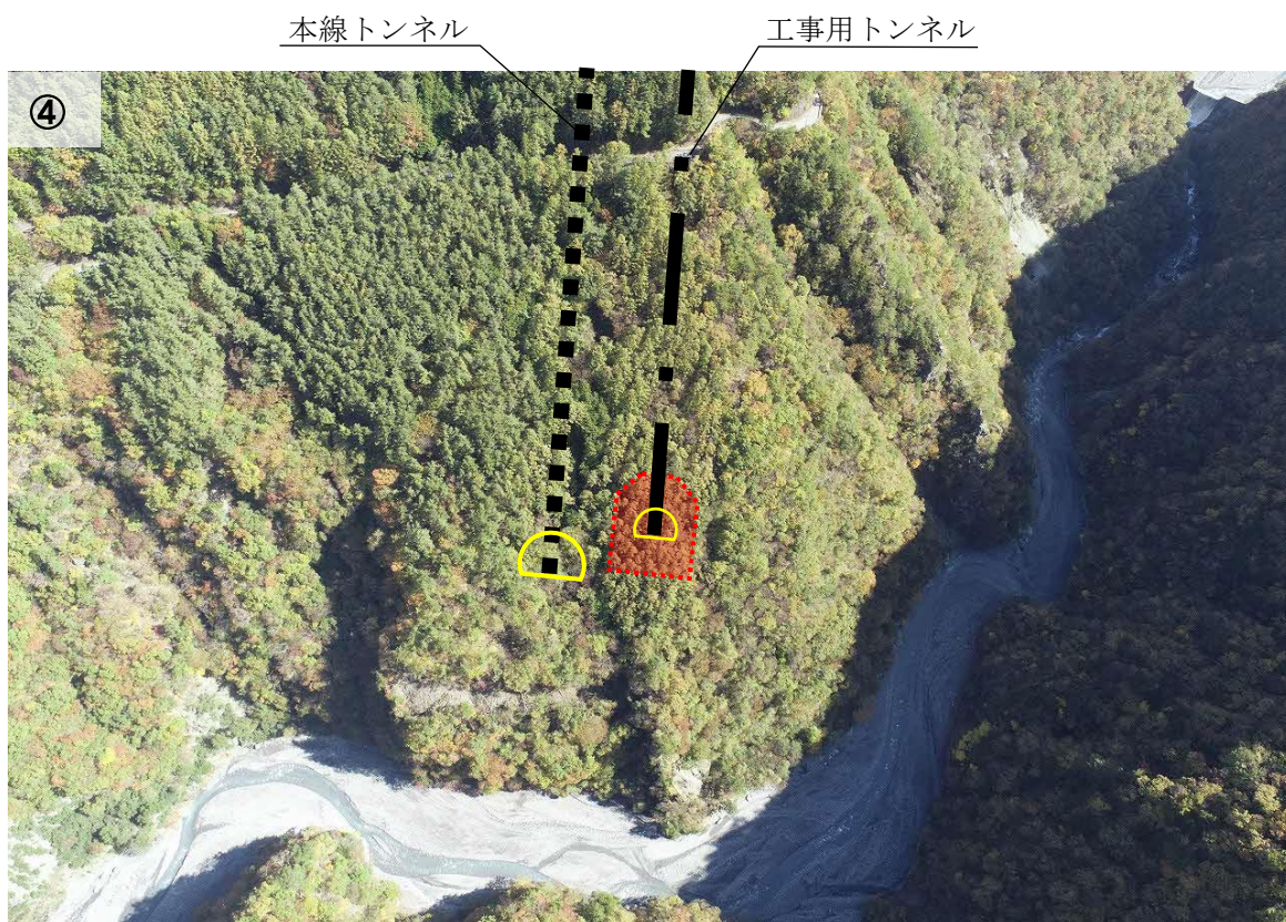
図 2-5 工事用トンネル坑口の工事前の状況
