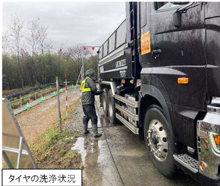
図 3-14 資材及び機械の運搬に用いる車両の運行による影響を低減するための環境保全措置
