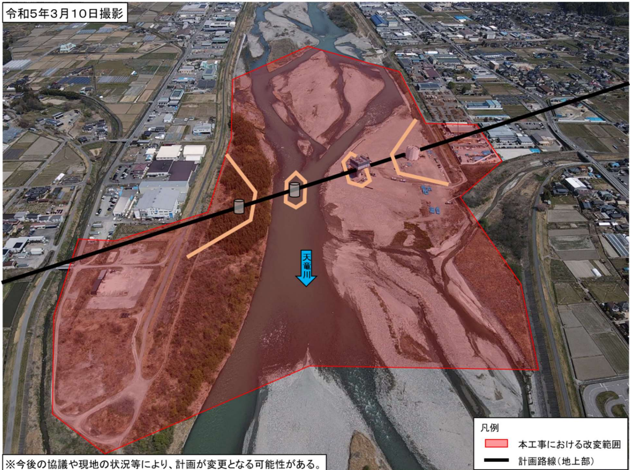
写真 2-1 下流から見る工事位置の現況（上空から俯瞰する）
