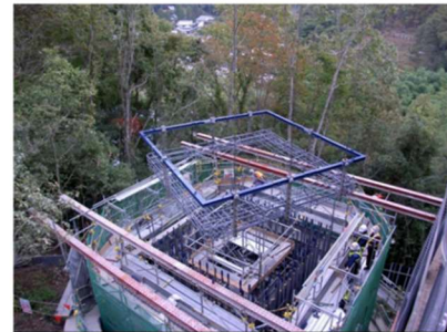
⑤橋脚部鉄筋組立
