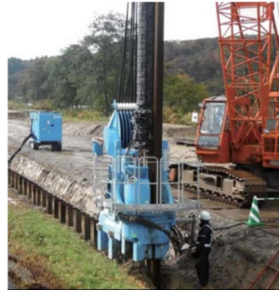
①鋼矢板打込み
