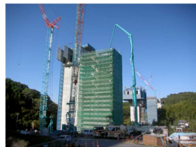
⑥橋脚部コンクリート打設
