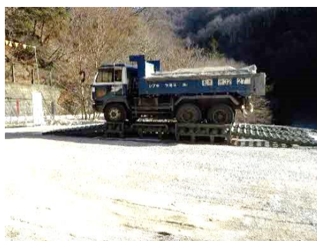
写真② 周辺道路の清掃及び散水、タイヤ洗浄機の設置
