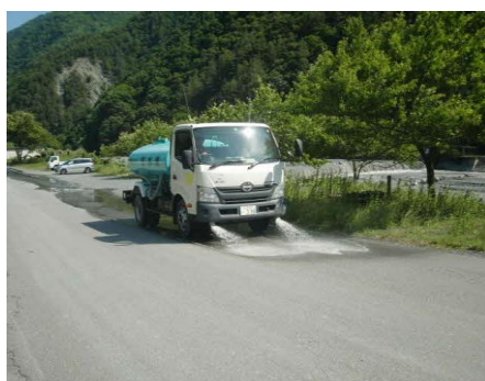
写真② 周辺道路の清掃及び散水、タイヤ洗浄機の設置
