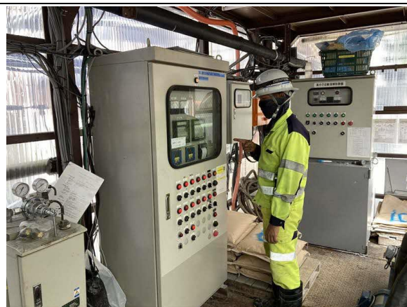
写真4-1-9 工事排水監視状況
