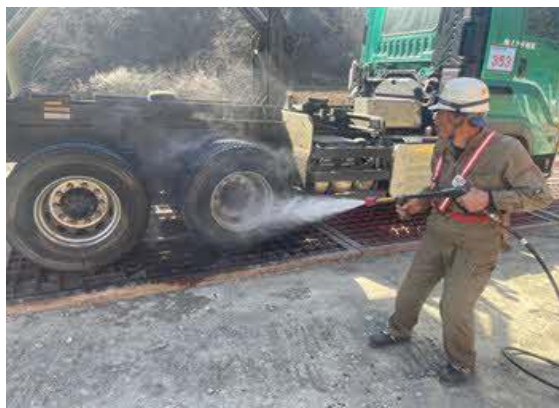
写真4-1-95 タイヤ洗浄の実施状況
