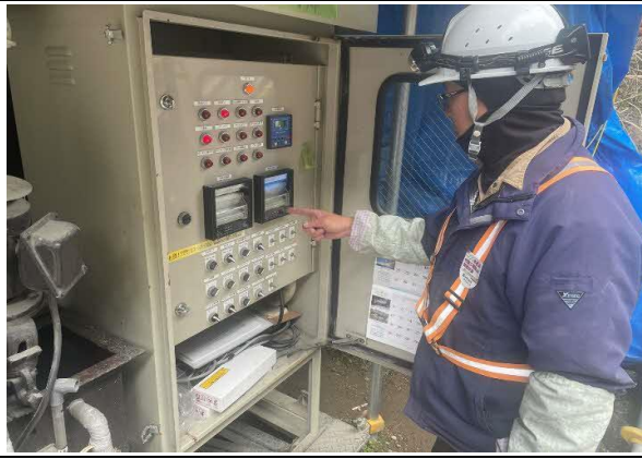
写真4-1-196 工事排水の監視状況
