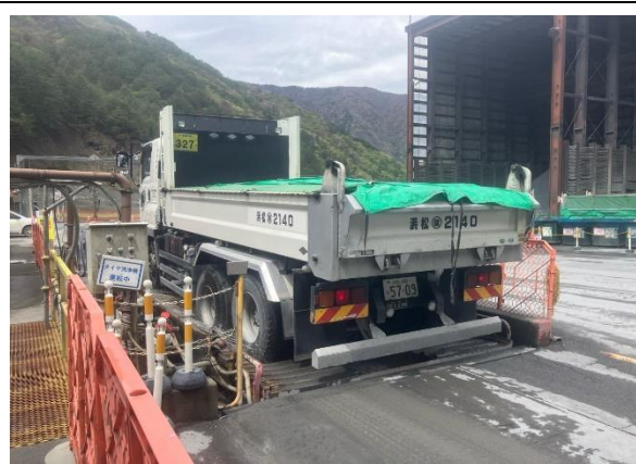
写真4-1-17 タイヤ洗浄機設置の状況
