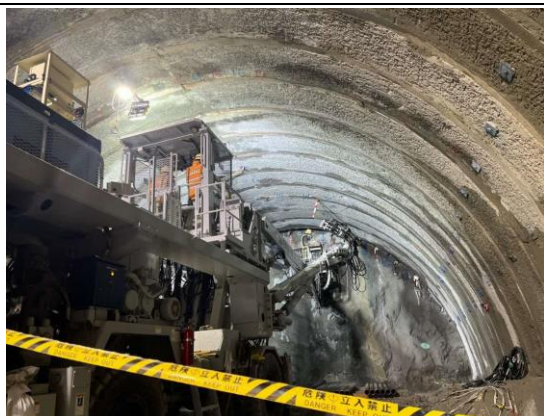
写真4-1-159 補助工法の実施状況
