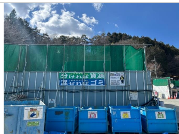
写真4-1-149 建設副産物の分別
