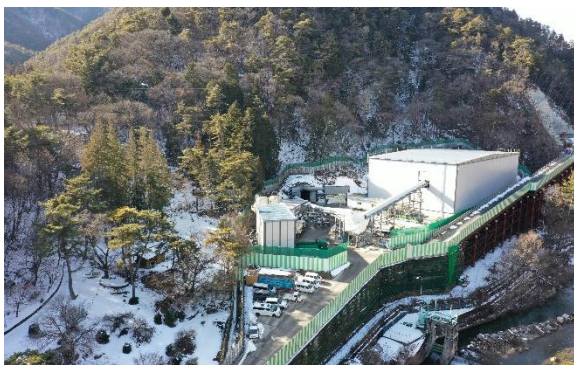
写真4-1-146 仮設物の色合いへの配慮 (周辺の景観に配慮)
