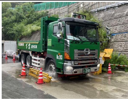
写真4-1-80 タイヤ洗浄機設置の状況
