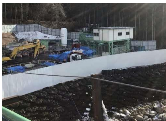
写真4-1-172 仮囲いの設置状況
