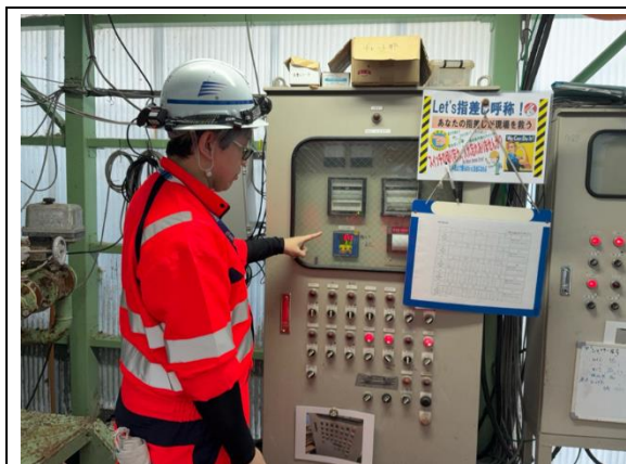
写真4-1-54 濁水処理設備の整備状況
