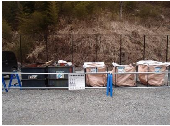
写真4-1-43 建設副産物の分別
