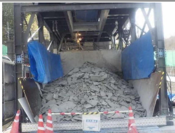
写真4-1-82 建設汚泥の処理状況
