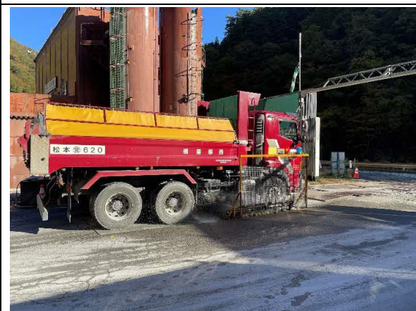
写真4-1-40 タイヤ洗浄機設置の状況
