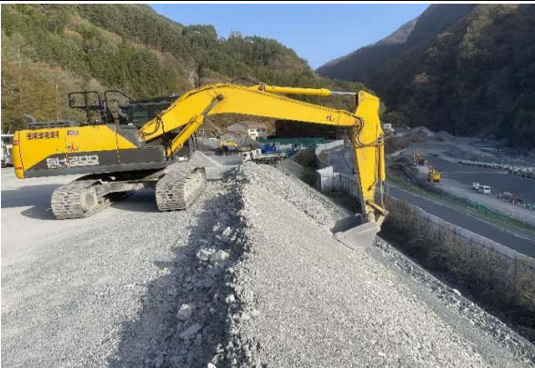
写真4-1-200 法面、斜面の保護
