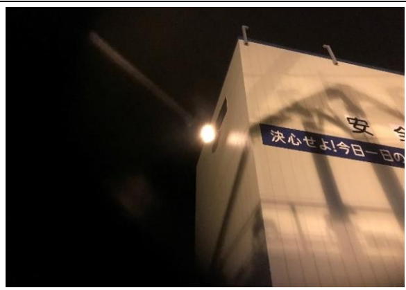
写真4-1-16 昆虫の誘引効果が低い照明 (ナトリウム灯) の設置状況
