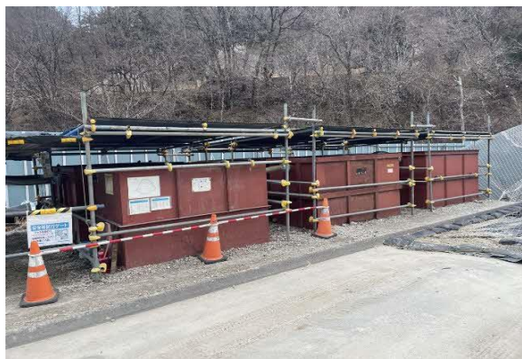
写真4-1-213 集水設備の設置状況
