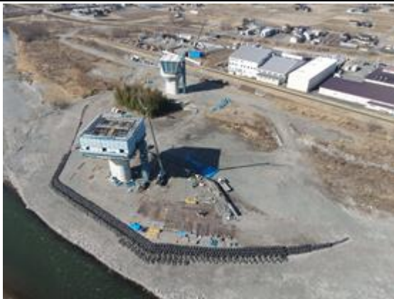
写真4-1-103 仮締切工の実施状況
