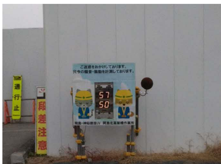
写真 参 2-2 モニター表示例 (07 阿島北高架橋ほか)
