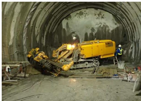
写真4-1-31 水平調査ボーリングの実施状況 (地盤の状況を把握し、適切な支保工 パターン等を選定)
