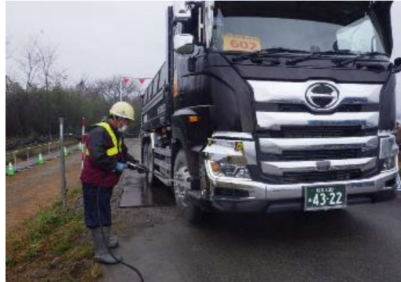
写真4-1-108 タイヤ洗浄の実施状況
