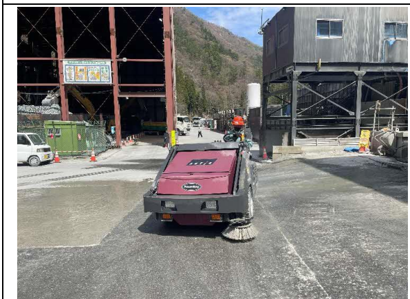
写真4-1-28 工事現場の清掃状況
