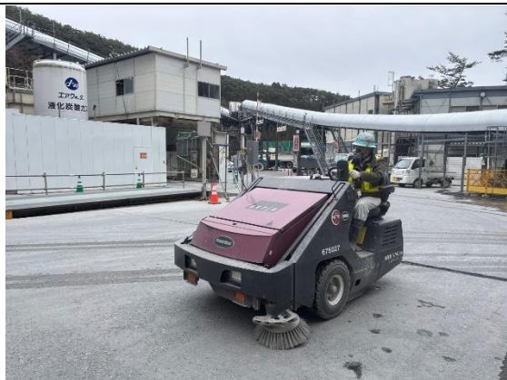
写真4-1-134 工事現場の清掃状況
