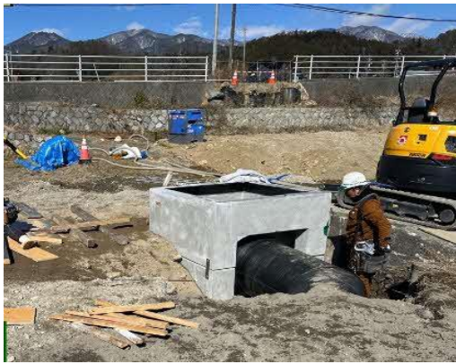
写真4-1-116 水路等の切回し
