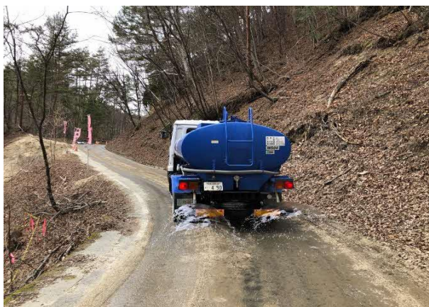
写真4-1-194 工事現場の散水状況 (車両の運行ルート)
