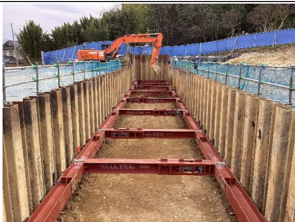
写真4-1-118 止水性の高い土留め工法の採用
