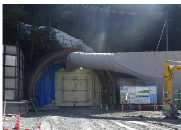
写真4-1-2 防音扉の設置状況
