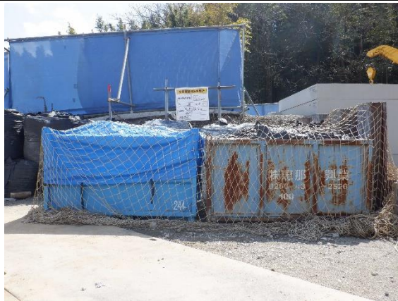
写真4-1-128 建設副産物の分別
