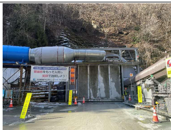
写真4-1-25 防音扉の設置状況
