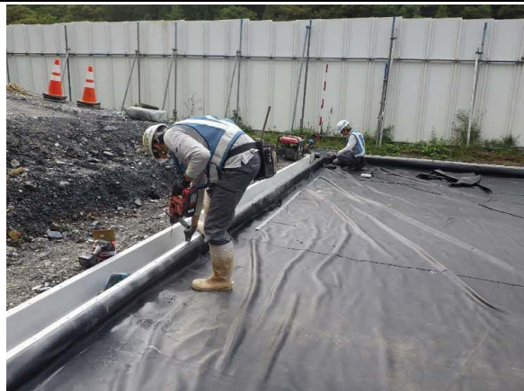
写真4-1-212 排水溝設置状況
