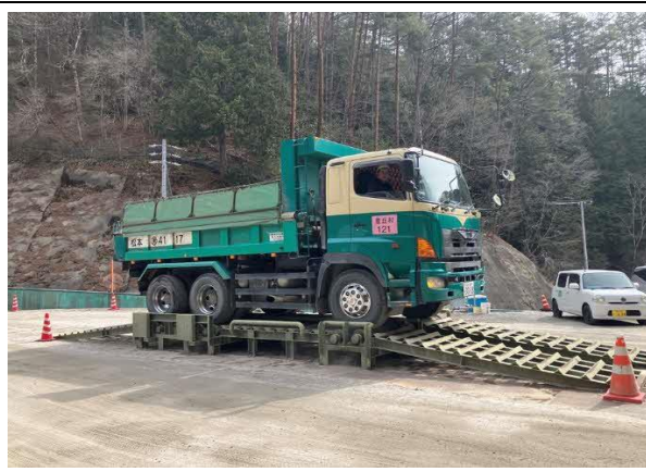
写真4-1-203 タイヤ洗浄装置の設置状況
