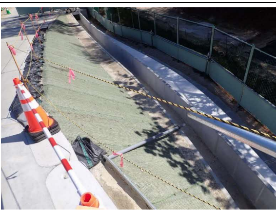
写真4-1-145 切土法面等の緑化による植生復元の状況
