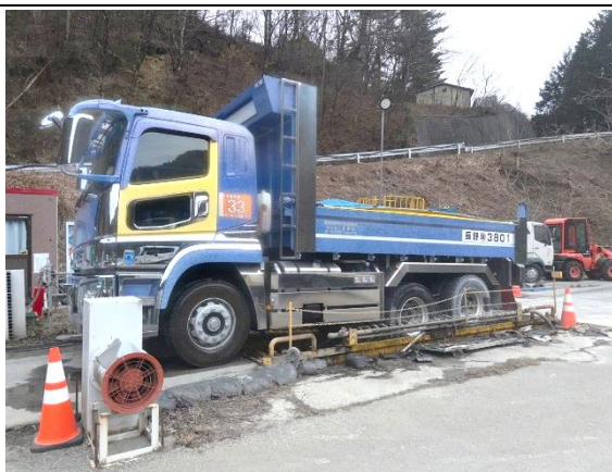
写真4-1-144 タイヤ洗浄の実施状況
