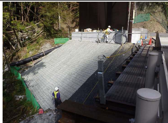
写真4-1-18 切土法面等の緑化
