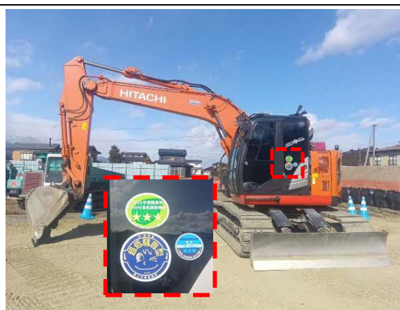
写真4-1-88 排出ガス対策型、低騒音型 建設機械の採用
