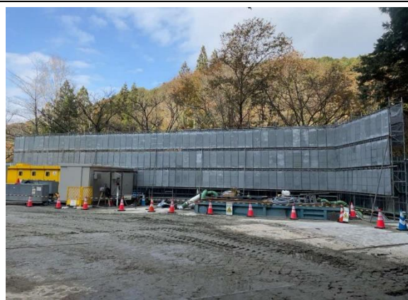
写真4-1-151 吸音パネルの設置状況
