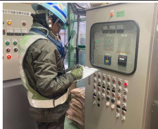
写真4-1-180 工事排水監視状況
