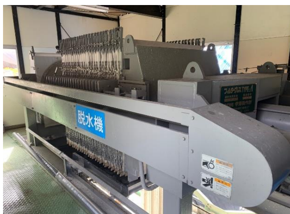
写真4-1-64 建設汚泥の処理状況
