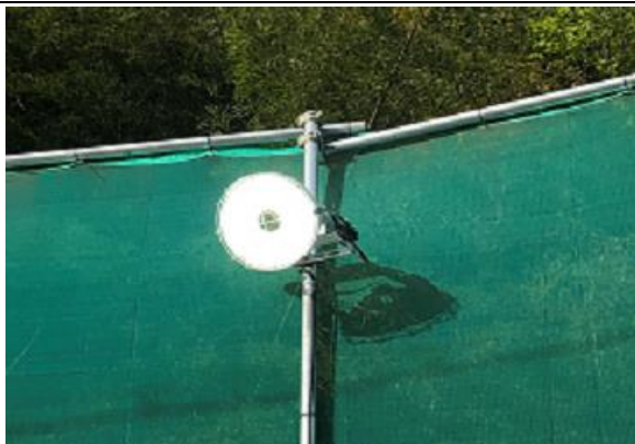
写真4-1-79 昆虫の誘引効果が低い照明 (LED灯) の設置状況
