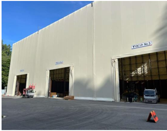
写真4-1-163 重金属等判定用土砂ピットの設置状況
