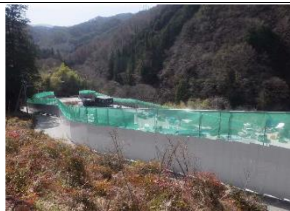
写真4-1-67 仮囲いの設置状況
