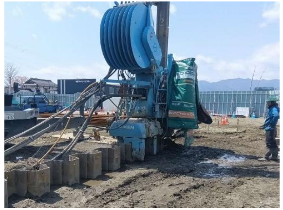
写真4-1-94 止水性の高い土留め工法の採用
