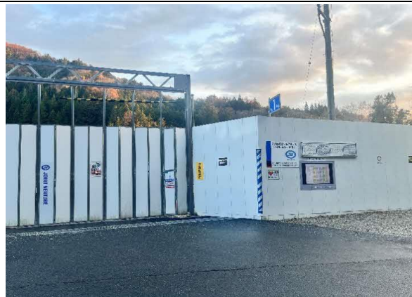
写真4-1-152 仮囲いの設置状況
