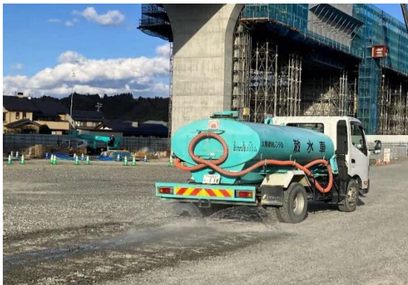
写真4-1-101 工事現場の散水状況
