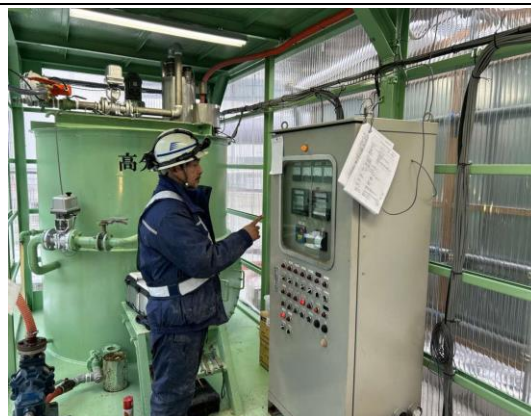
写真4-1-160 工事排水監視状況
