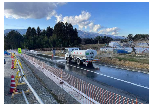
写真4-1-71 工事現場の散水状況 (車両の運行ルート)
