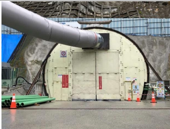
写真4-1-50 防音扉の設置状況
