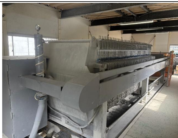
写真4-1-147 建設汚泥の処理状況
