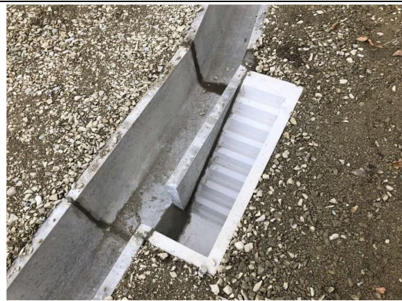
写真4-1-61 小動物等の移動経路の確保 (幅約25cmの階段を設置)
