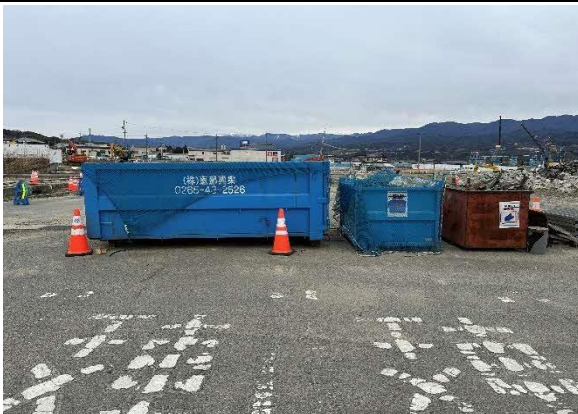
写真4-1-120 建設副産物の分別
