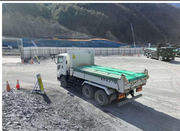
写真4-1-217 荷台への防じんシート敷設
