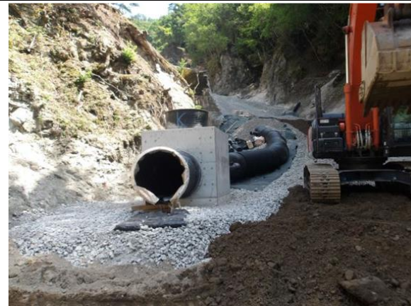
写真4-1-198 暗渠管敷設状況
