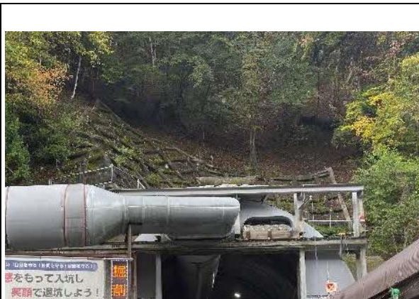
写真4-1-36 法面、斜面の保護状況
