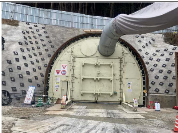
写真4-1-173 防音屏の設置状況
