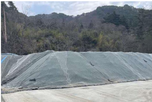
写真 参 1-7 遮水シート等による浸透防止 (発生土仮置き場 (坂島))
