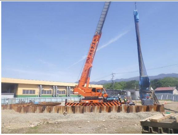
写真4-1-105 止水性の高い土留め工法の採用
