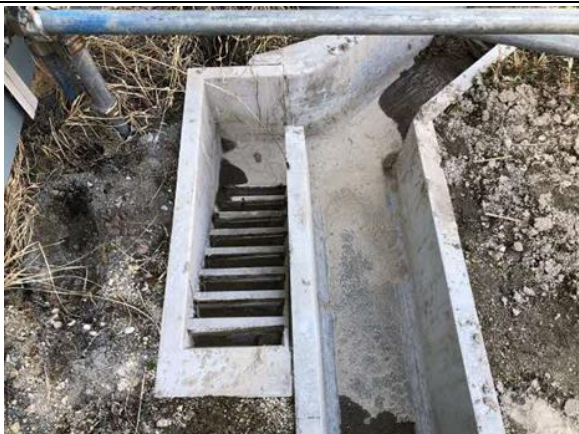
写真4-1-202 小動物等の移動経路の確保 (幅約25cmの階段を設置)
