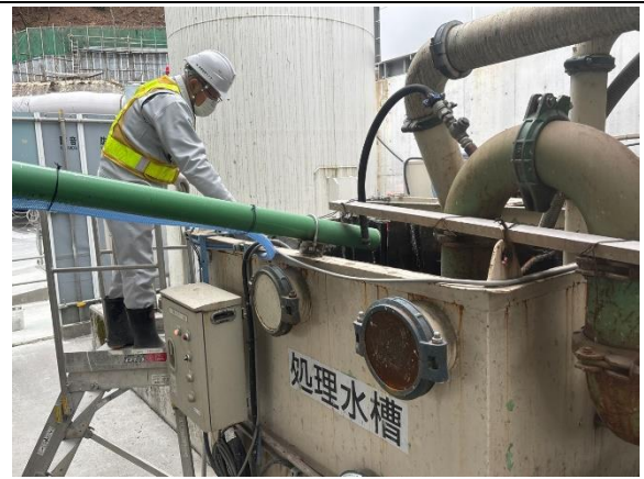
写真4-1-137 工事排水の監視状況
