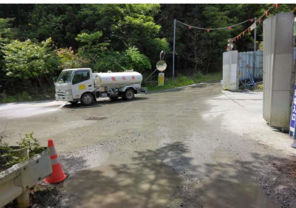
写真4-1-52 工事現場の散水状況 (車両の運行ルート)
