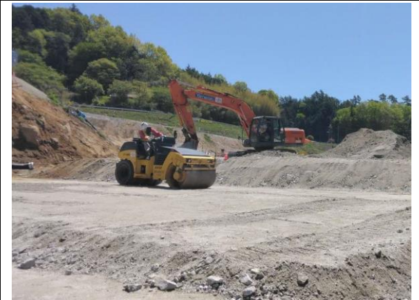
写真4-1-201 盛土材の転圧状況
