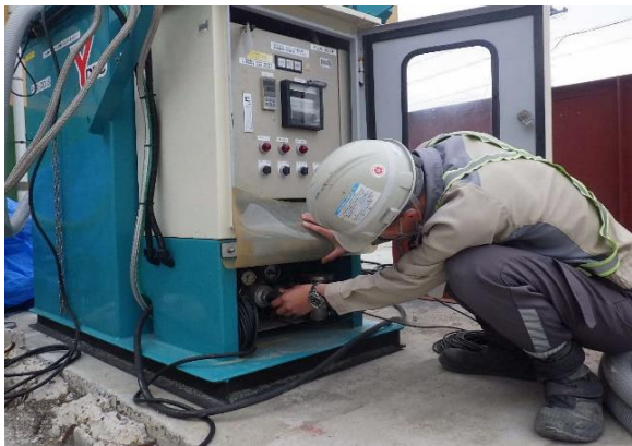
写真4-1-107 中和処理装置の整備状況
