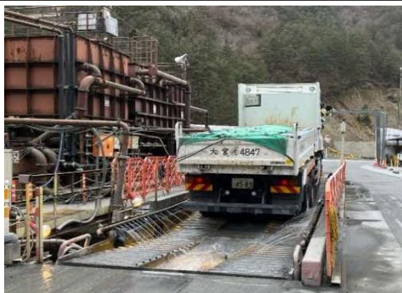
写真4-1-215 タイヤ洗浄の実施状況
