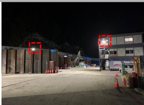
写真4-1-62 昆虫の誘引効果が低い照明 (LED灯) の設置状況
