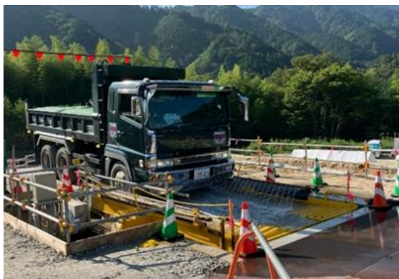
写真4-1-186 タイヤ洗浄の実施状況
