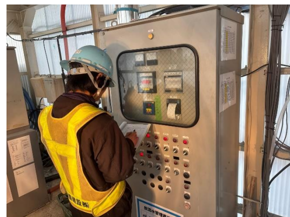
写真4-1-138 濁水処理設備の点検状況
