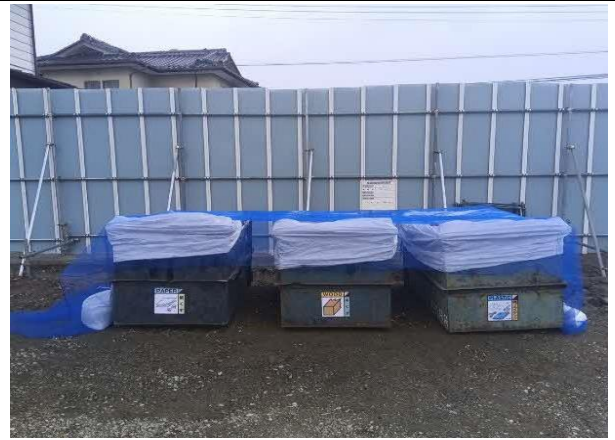
写真4-1-96 建設副産物の分別
