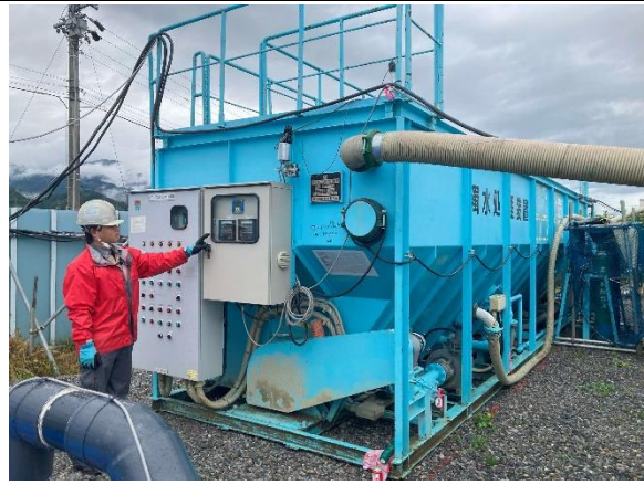
写真4-1-106 工事排水の監視状況
