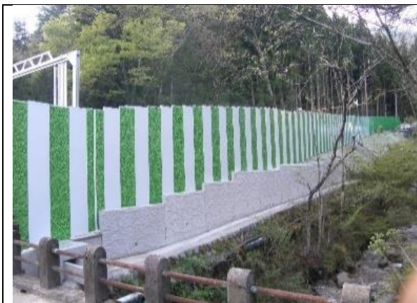
写真4-1-130 仮囲いの設置状況
