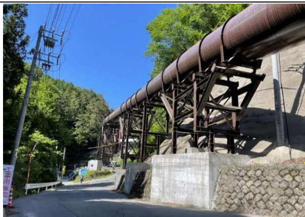
写真4-1-84 ベルトコンベアの設置状況
