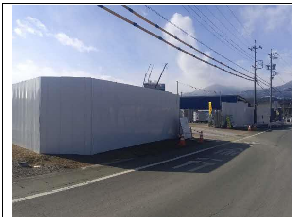
写真4-1-87 仮囲いの設置状況
