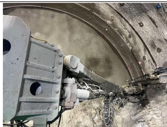
写真4-1-76 前方探査の実施状況 (地質の状況を把握し、適切な支保工 パターン等を選定)
