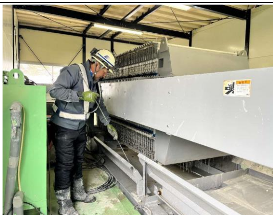
写真4-1-161 濁水処理設備の整備状況
