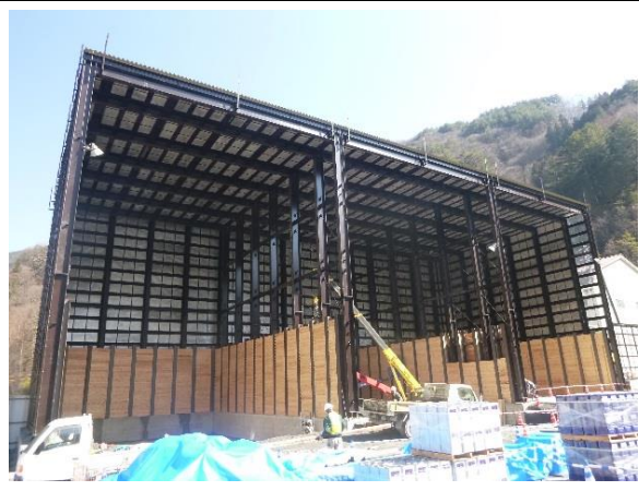
写真4-1-12 重金属等判定用土砂ピットの設置状況
