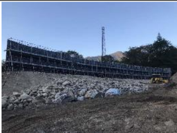
写真4-1-171 防音シート設置状況
