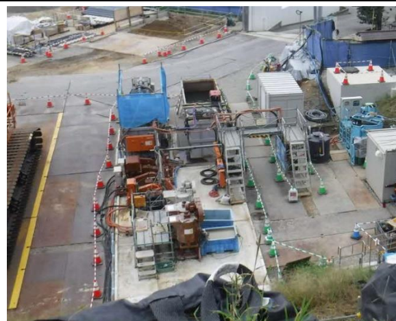
写真4-1-126 処理設備の設置
