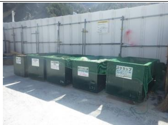
写真4-1-21 建設副産物の分別
