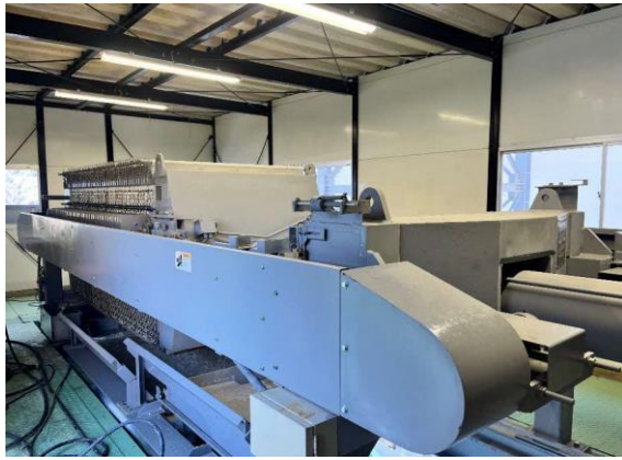
写真4-1-169 建設汚泥の処理状況
