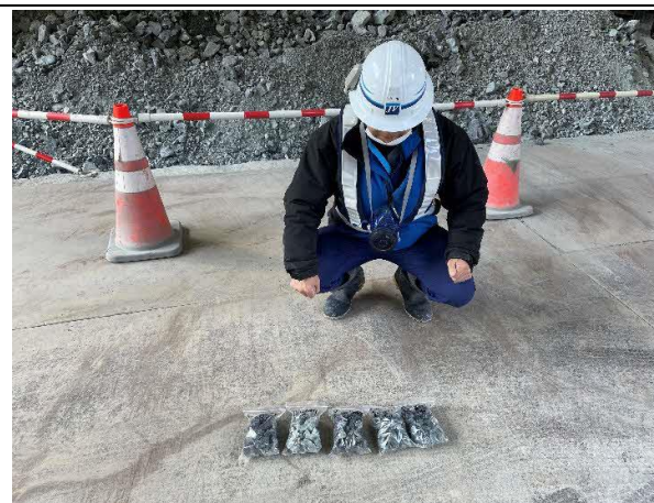
写真4-1-37 重金属等溶出試験試料採取の状況
