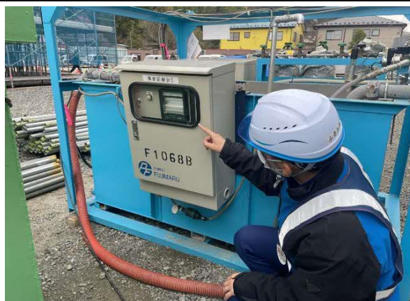
写真4-1-92 工事排水の監視
