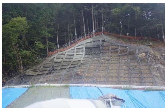
写真4-1-59 法面、斜面の保護の状況
