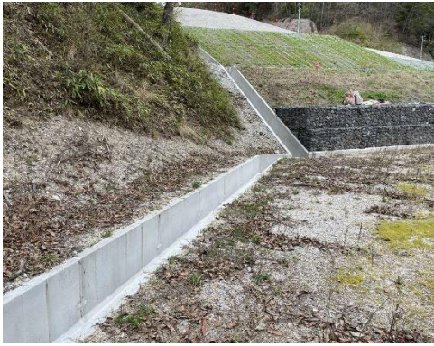
写真 参 1-1 外周の側溝の設置 (発生土置き場 (戸中))
