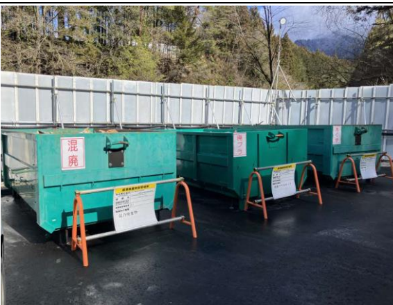
写真4-1-188 建設副産物の分別
