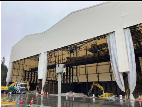
写真4-1-183 重金属等判定用土砂ピットの設置状況
