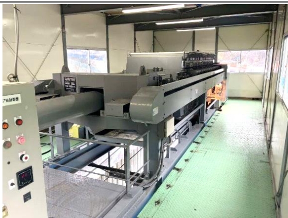
写真4-1-187 建設汚泥の処理状況
