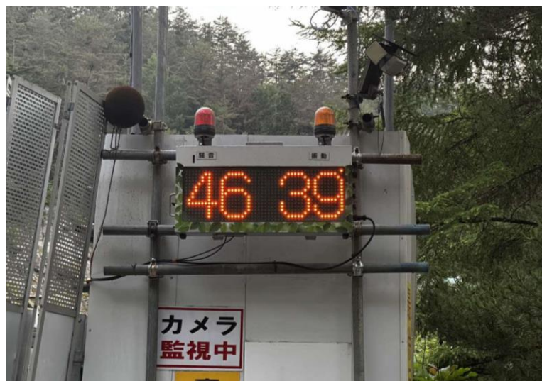
写真 参 2-1 モニター表示例 (04 坂島非常口)
