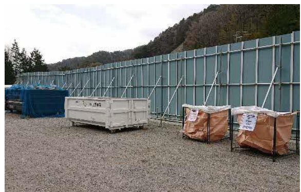
写真4-1-168 建設副産物の分別
