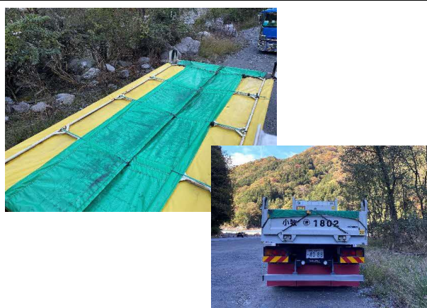
写真4-1-45 荷台への防じんシート敷設
