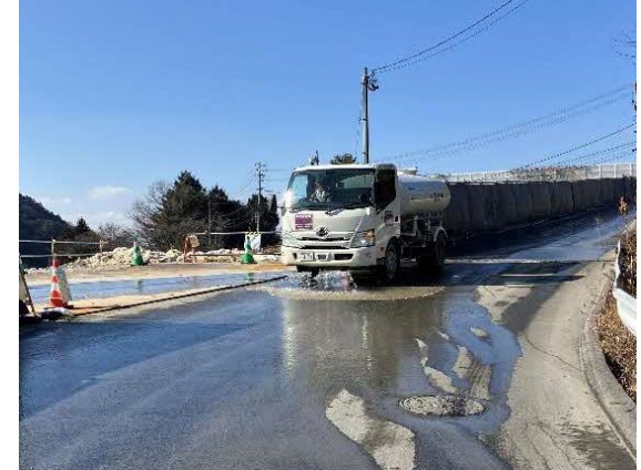
写真4-1-176 工事現場の散水状況 (車両の運行ルート)
