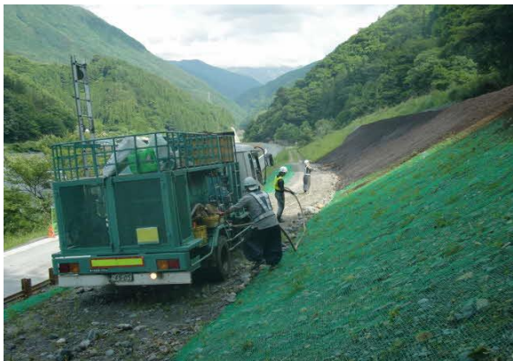
写真4-1-13 法面、斜面の保護の状況
