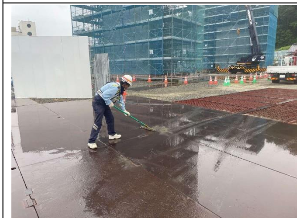
写真4-1-91 工事現場の清掃状況
