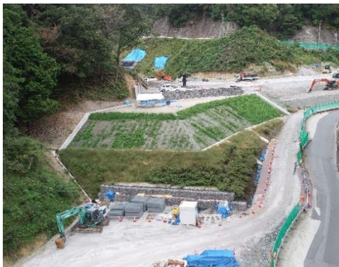
写真 参 1-5 植生工の実施 (発生土置き場 (戸中))
