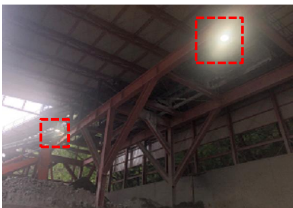
写真4-1-204 昆虫の誘引効果が低い照明 (LED灯) の設置状況
