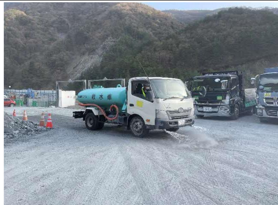
写真4-1-216 工事現場の散水状況
