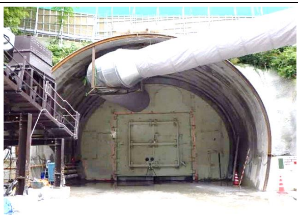
写真4-1-68 防音扉の設置状況
