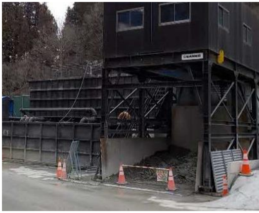
写真4-1-42 建設汚泥の処理状況
