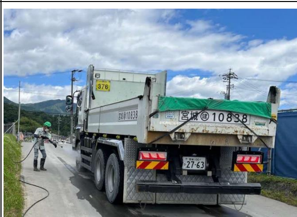
写真4-1-119 タイヤ洗浄の実施状況
