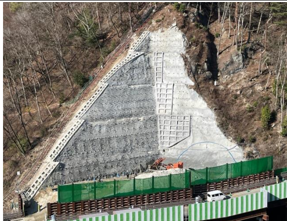
写真4-1-143 法面・斜面保護の状況
