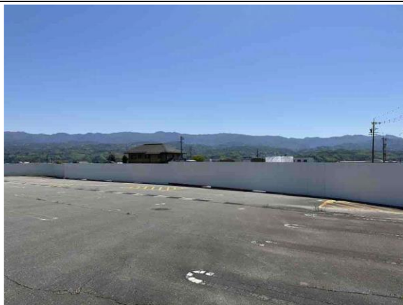
写真4-1-110 仮囲いの設置状況
