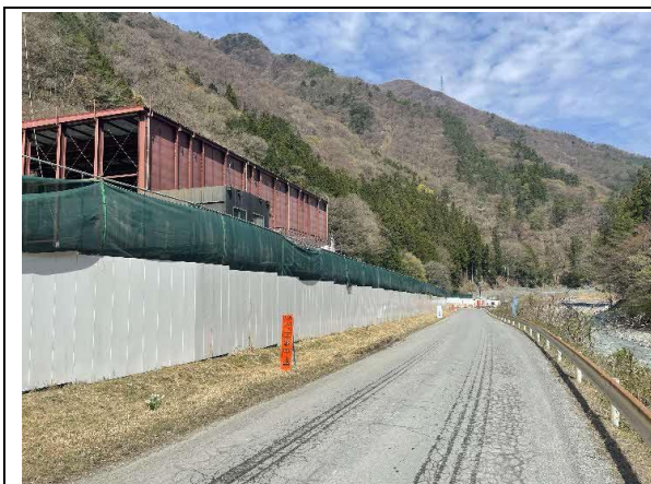
写真4-1-24 仮囲いの設置状況
