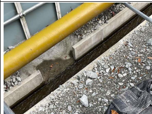
写真4-1-38 小動物等の移動経路の確保 (幅約1mのスロープを設置)
