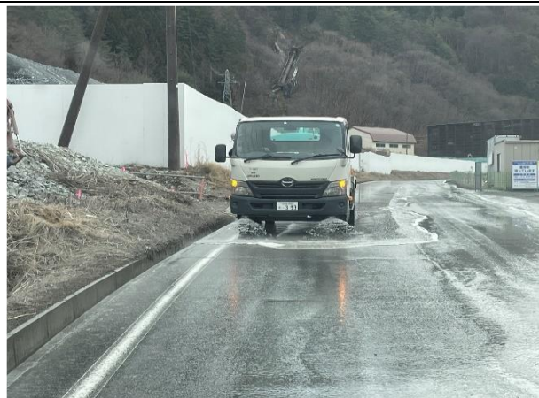
写真4-1-218 周辺道路の散水状況
