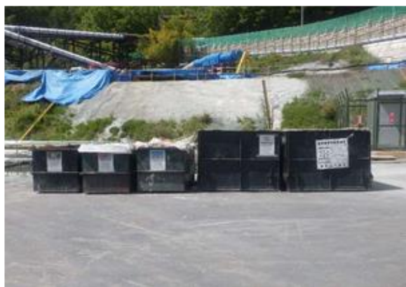
写真4-1-83 建設副産物の分別
