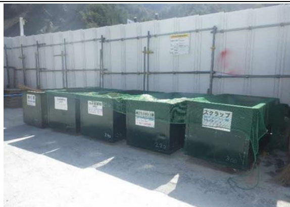
写真4-1-220 建設副産物の分別
