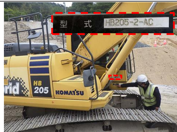
写真4-1-193 低炭素型建設機械の採用
