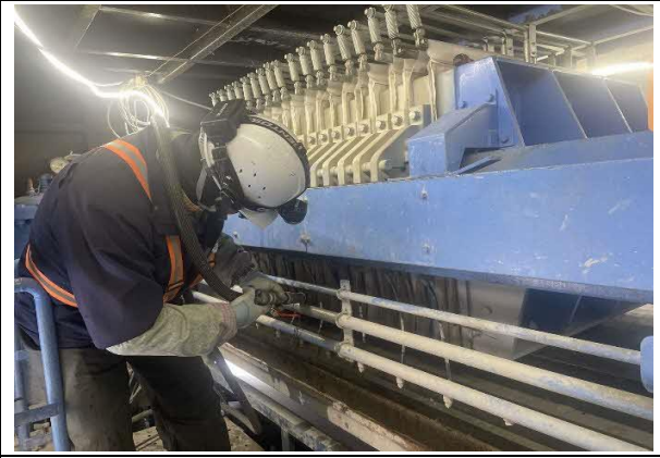
写真4-1-197 濁水処理設備の点検状況
