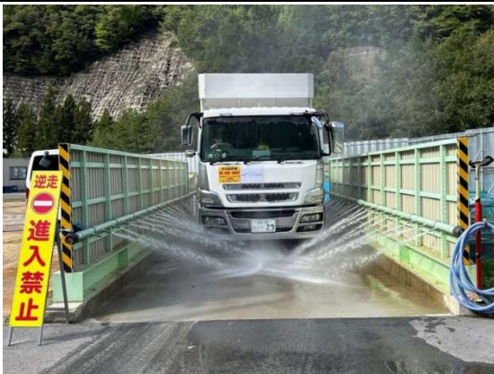
写真4-1-167 タイヤ洗浄の実施状況
