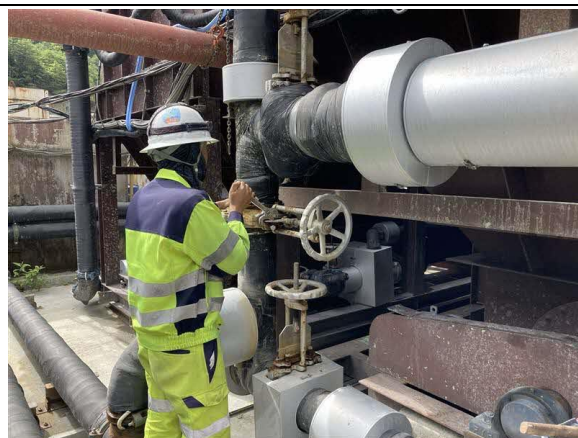
写真4-1-10 濁水処理設備の整備状況
