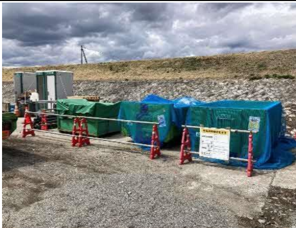
写真4-1-109 建設副産物の分別
