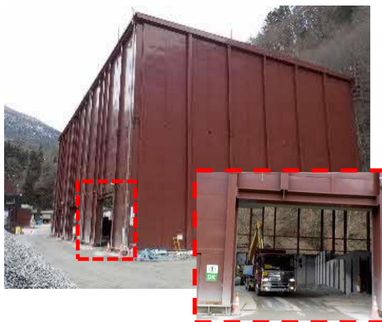
写真4-1-35 重金属等判定用土砂ピットの 設置状況
