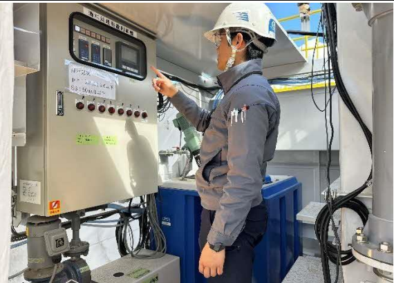
写真4-1-117 工事排水の監視
