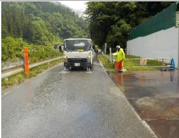
写真4-1-44 周辺道路の散水状況
