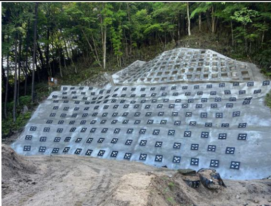
写真4-1-165 法面、斜面の保護の状況
