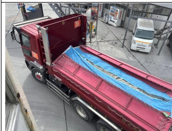
写真4-1-150 荷台への防塵シート敷設
