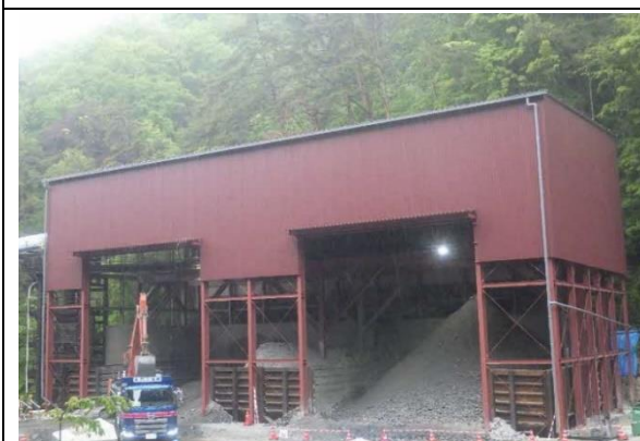
写真4-1-77 重金属等判定用土砂ピットの 設置状況
