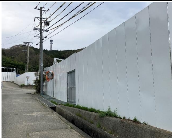
写真4-1-121 仮囲いの設置状況
