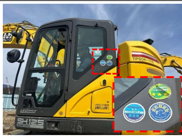
写真4-1-111 排出ガス対策型、低騒音型建設機械の採用
