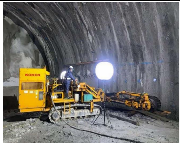
写真4-1-139 先進ボーリングの実施状況 (地盤の状況を把握し、適切な支保工 パターン等を選定)
