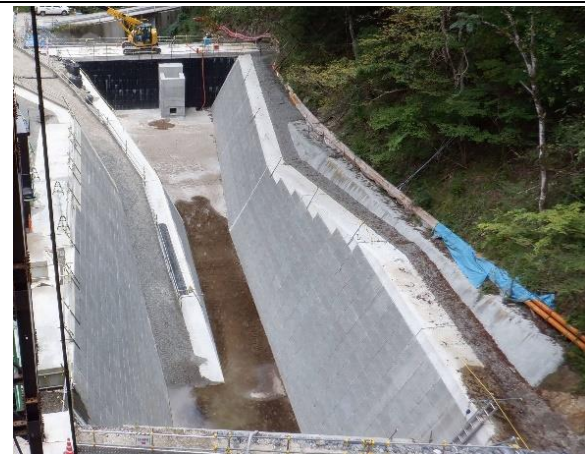
写真4-1-195 排水設備の設置状況
