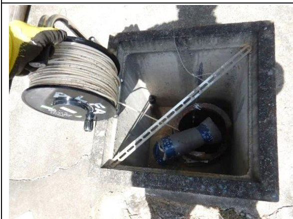
写真4-1-75 地下水等の監視の実施状況
