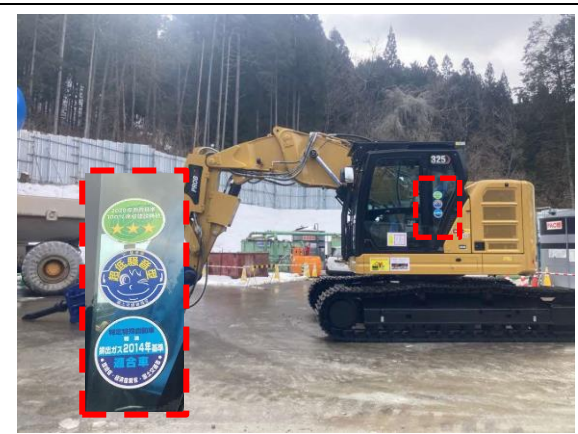
写真4-1-174 排出ガス対策型、低騒音型建設機械の採用
