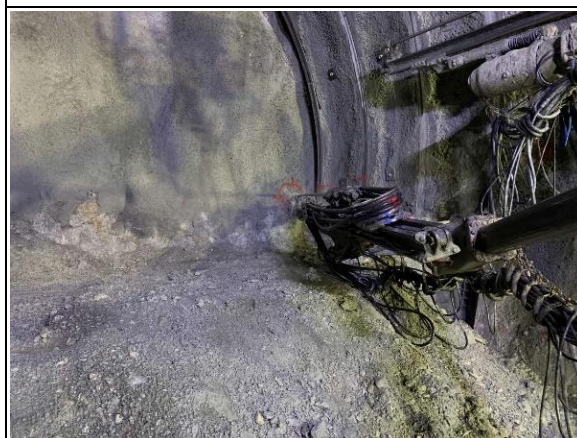
写真4-1-56 削孔検層の実施状況 (地質の状況を把握し、適切な支保工 パターン等を選定)
