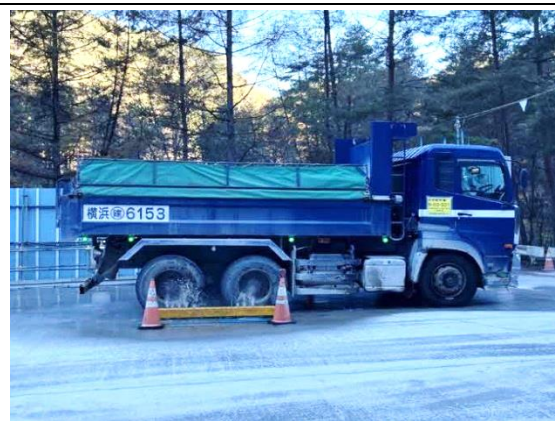
写真4-1-63 タイヤ洗浄の実施状況
