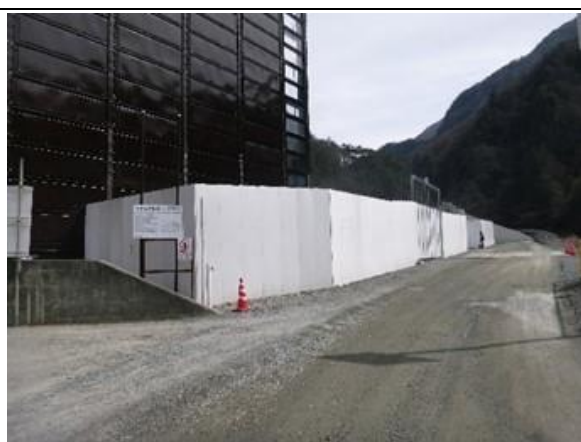
写真4-1-1 仮囲いの設置状況
