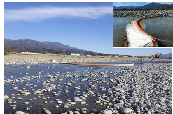
写真4-1-104 汚濁防止膜の設置状況
