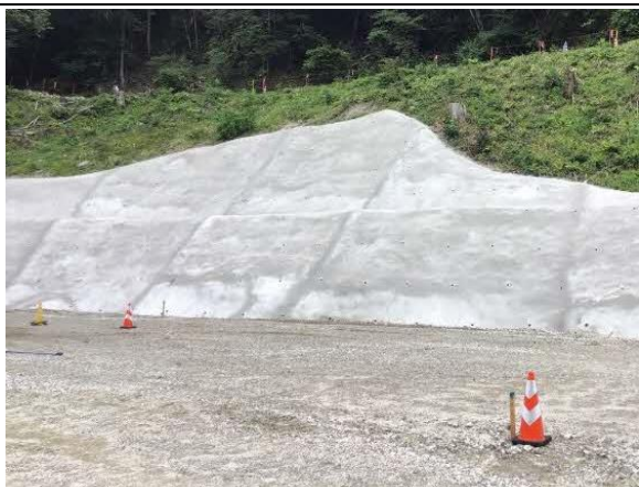
写真4-1-185 法面、斜面の保護の状況
