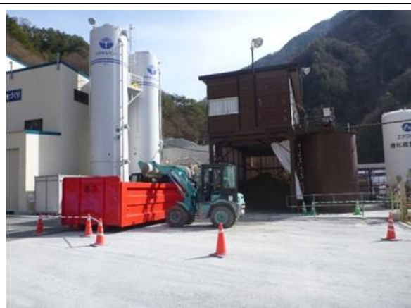
写真4-1-20 建設汚泥の処理状況
