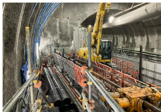
写真4-1-8 先進ボーリングの実施状況 (地盤の状況を把握し、適切な支保工パターン等を選定)
