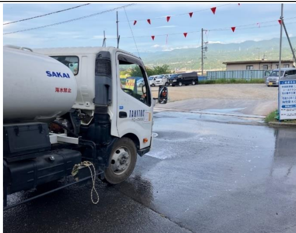
写真4-1-125 工事現場の散水状況
