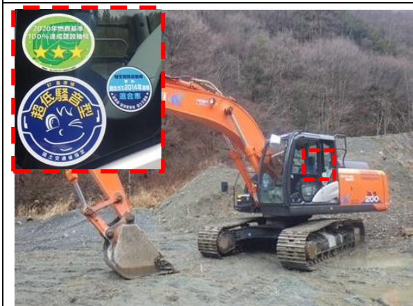
写真4-1-26 排出ガス対策型、低騒音型 建設機械の採用
