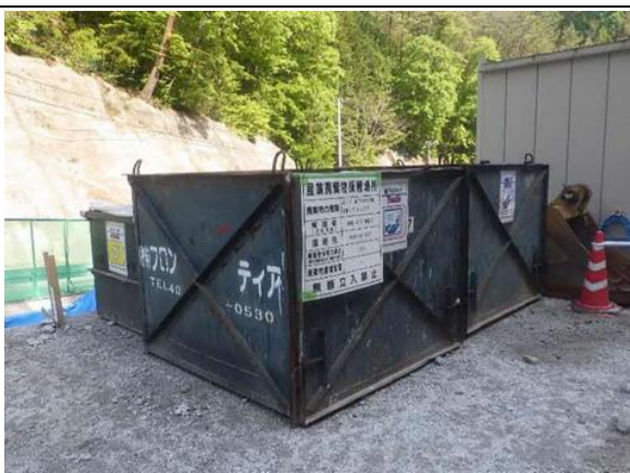
写真4-1-206 建設副産物の分別
