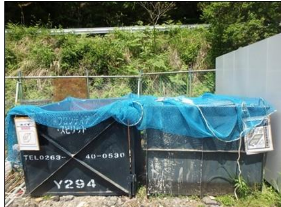
写真4-1-65 建設副産物の分別
