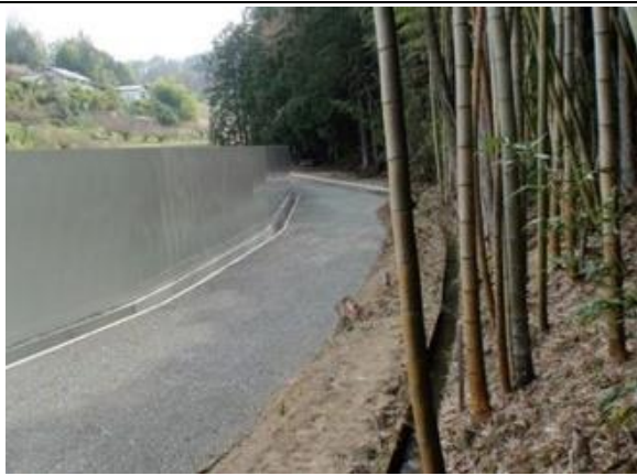
写真4-1-48 仮囲いの設置状況
