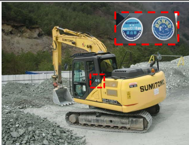
写真4-1-190 排出ガス対策型、低騒音型 建設機械の採用
