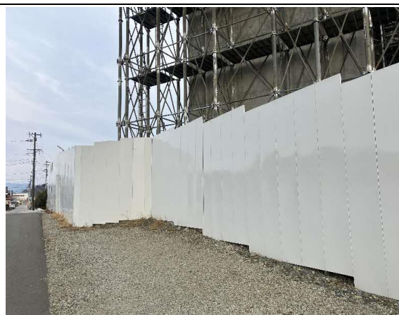
写真4-1-97 仮囲いの設置状況
