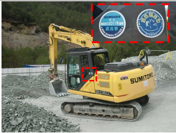
写真4-1-209 排出ガス対策型、低騒音型 建設機械の採用
