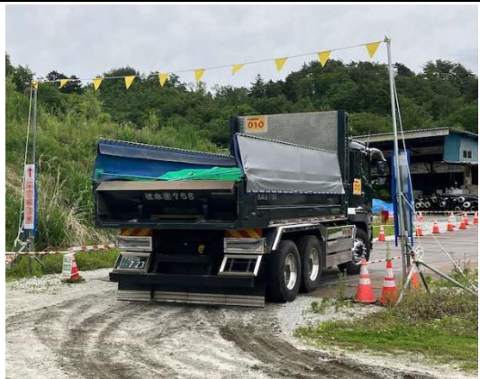
写真4-1-129 荷台への防じんシート敷設
