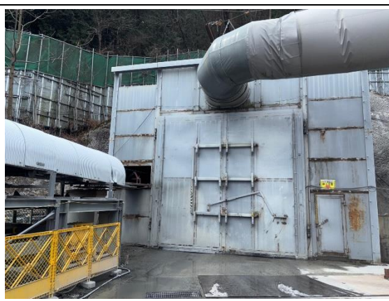
写真4-1-131 防音扉の設置状況
