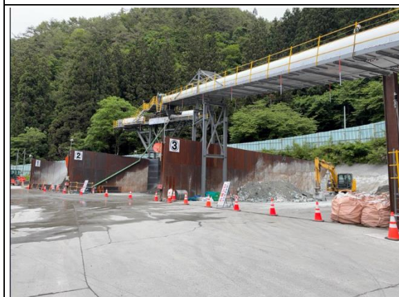
写真4-1-58 重金属等判定用土砂ピットの 設置状況
