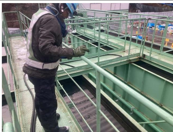
写真4-1-181 濁水処理設備の点検状況
