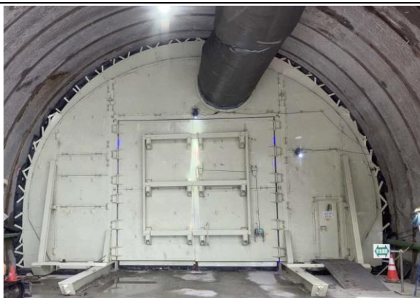
写真4-1-153 防音扉の設置状況
