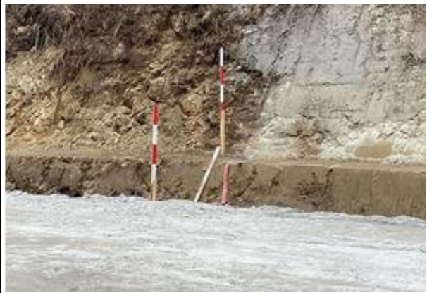
写真4-1-199 段切り施工状況
