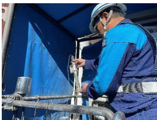
写真4-1-33 濁水処理設備の整備状況
