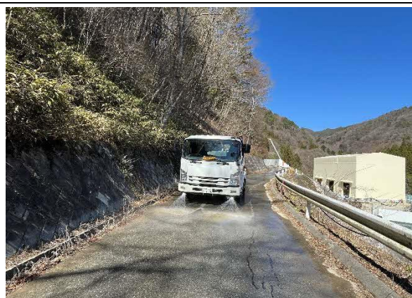
写真4-1-156 工事現場の散水状況 (車両の運行ルート)
