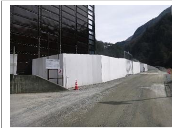
写真4-1-1 仮囲いの設置状況 (一例)
