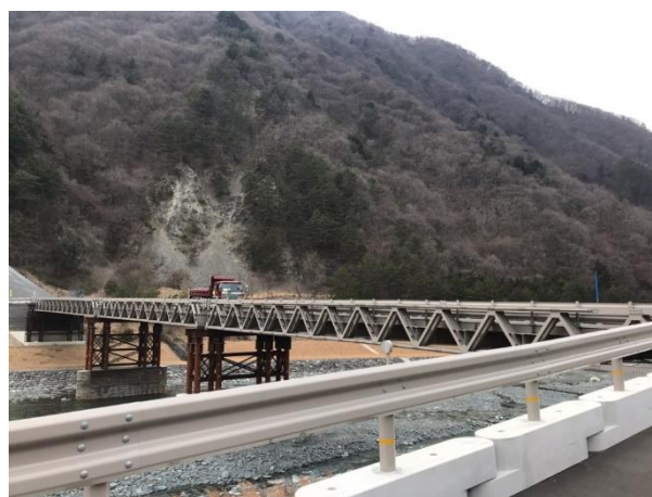
仮栈橋通行状況
