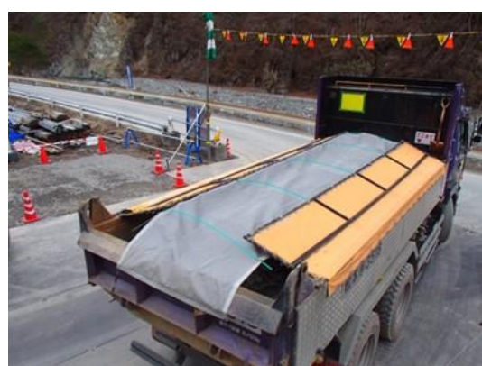
写真4-1-50 荷台への防塵シート敷設 (一例)
