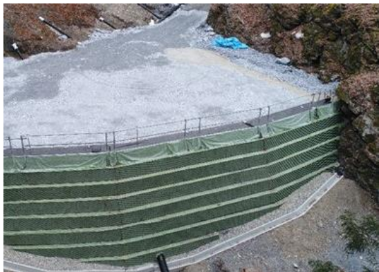
写真4-1-39 盛土補強材、植生シート設置状況（一例）
