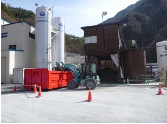
写真4-1-19 脱水ケーキ搬出の状況 (一例)
