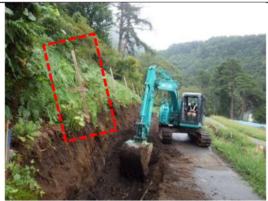
写真4-1-67 丁張設置による勾配管理 (一例)
