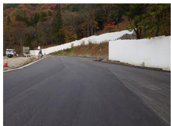
写真4-1-28 アスファルト舗装の状況（一例）
