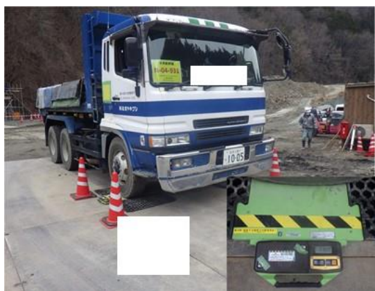
写真4-1-51 積載重量管理状況 (一例)
