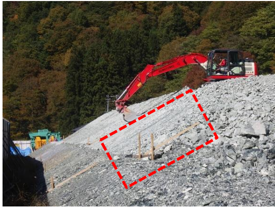
写真4-1-30 丁張設置による勾配管理 (一例)
