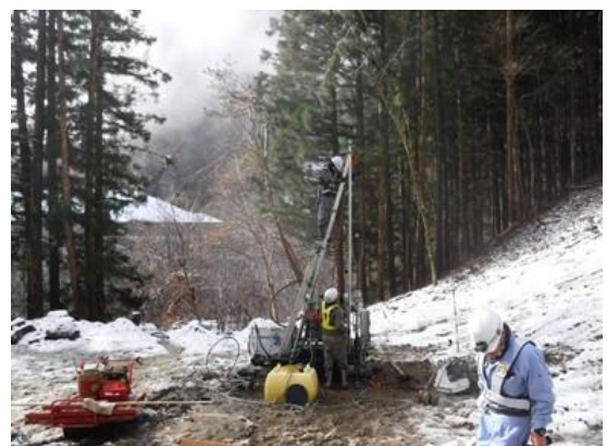
写真4-1-38 調査ボーリング実施状況 (一例)
