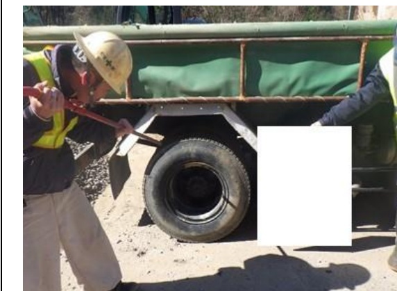
写真4-1-68 タイヤ洗浄状況 (一例)
