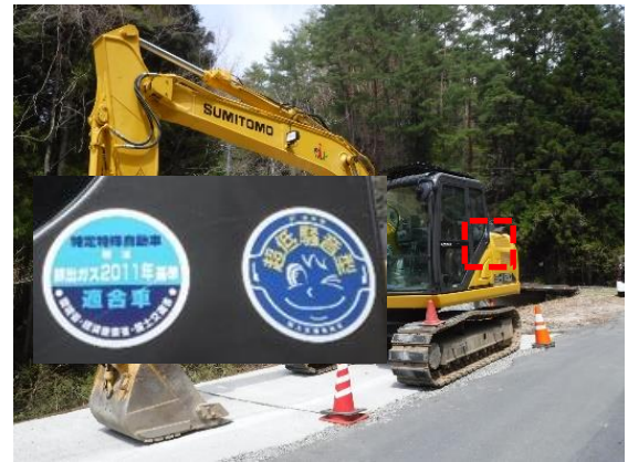
写真4-1-53 排出ガス対策型、低騒音型建設機械の採用 (一例)
