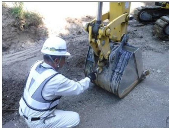
写真4-1-54 建設機械の点検及び整備による性能維持 (一例)
