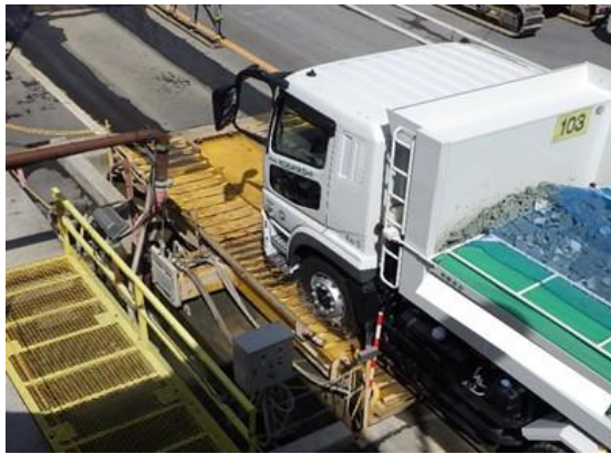
写真4-1-32 タイヤ洗浄機設置の状況 (一例)
