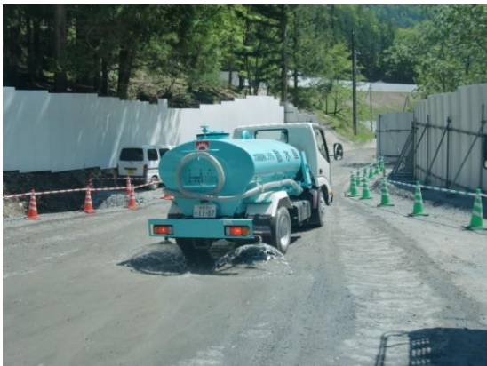
写真4-1-5 工事現場の散水状況 (一例)
