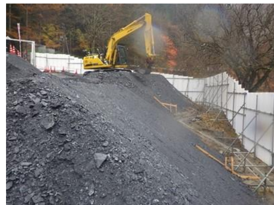
写真4-1-29 適切な構造（斜面安定が確保される勾配）（一例）
