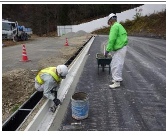
写真4-1-27 側溝設置状況（一例）
