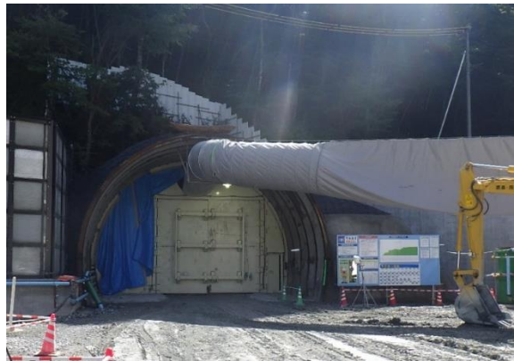
写真4-1-2 防音扉の設置 (一例)
