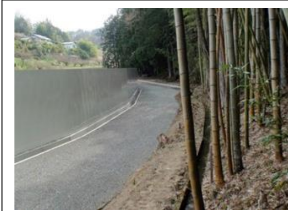
写真4-1-52 仮囲いの設置状況 (一例)
