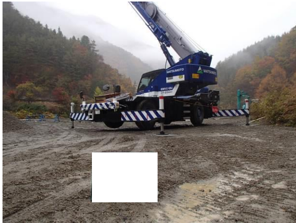
クレーン設置状況
