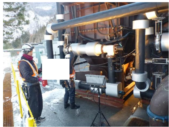
写真4-1-10 濁水処理設備の整備状況 (一例)
