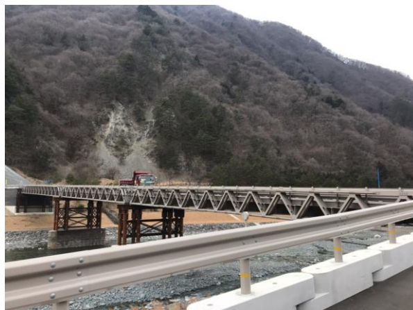
仮栈橋通行状況
