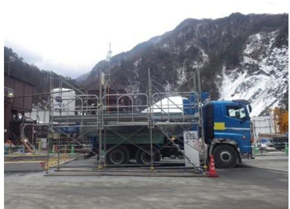
写真4-1-22 荷台への防塵シート敷設 (一例)
