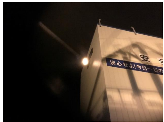
写真4-1-17 ナトリウム灯設置の状況（一例）
