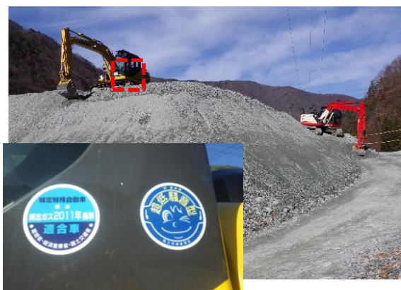
写真4-1-24 排出ガス対策型、低騒音型建設機械の採用（一例）
