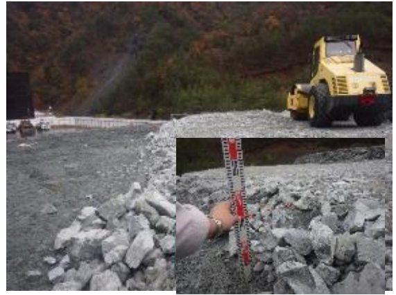
写真4-1-31 適切な施工管理 (一例)
