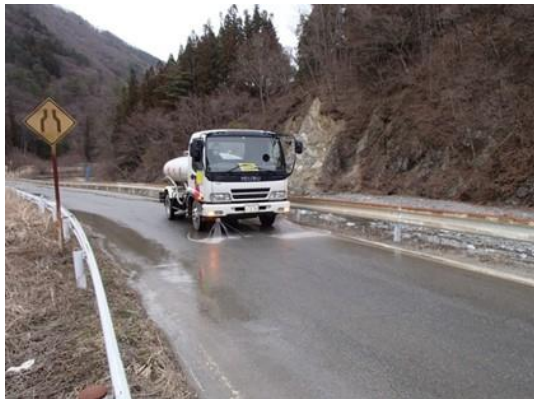
写真4-1-43 工事現場の散水状況（一例）
