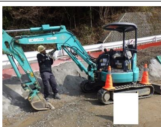
写真4-1-63 建設機械の点検及び整備による性能維持（一例）
