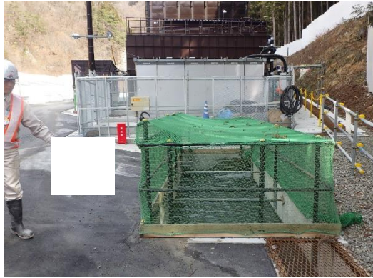
写真4-1-7 濁水処理設備の設置状況 (一例)
