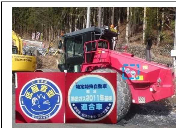
写真4-1-35 排出ガス対策型、低騒音型建設機械の採用 (一例)
