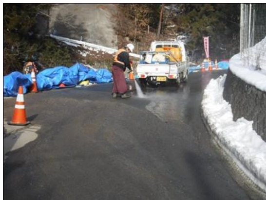
写真4-1-56 工事現場の散水状況 (一例)
