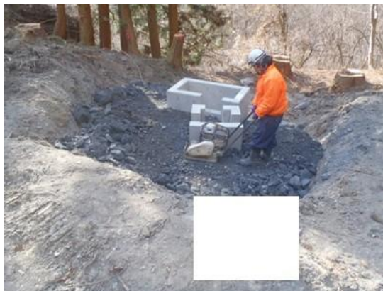
写真4-1-37 沈砂池設置状況 (一例)
