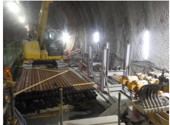
写真4-1-8 先進ボーリングの実施状況 (一例)
