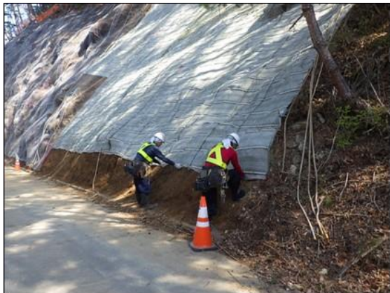
写真4-1-58 法面、斜面の保護、切土法面等の緑化による植生復元の状況（一例）
