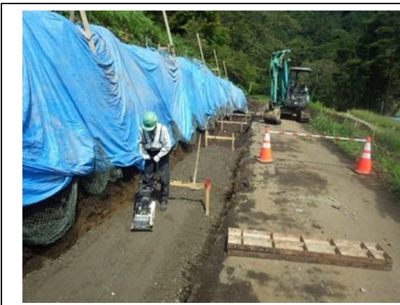
写真4-1-66 シートによる法面保護状況 (一例)
