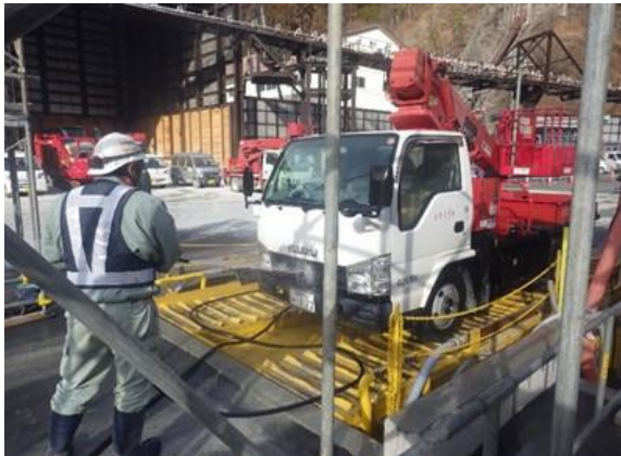
写真4-1-21 タイヤ洗浄の実施状況 (一例)
