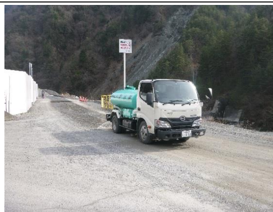
写真4-1-26 工事現場の散水状況（一例）
