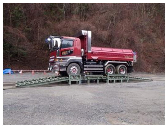
写真4-1-46 タイヤ洗浄機設置の状況（一例）
