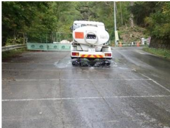
写真4-1-64 工事現場の散水状況（一例）
