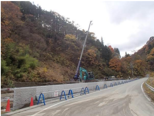
クレーン作業状況
