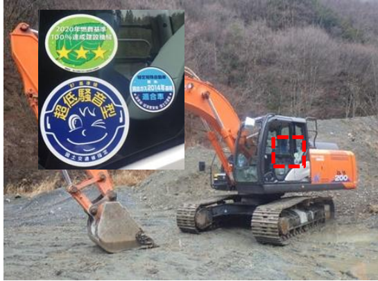
写真4-1-41 排出ガス対策型、低騒音型建設機械の採用（一例）
