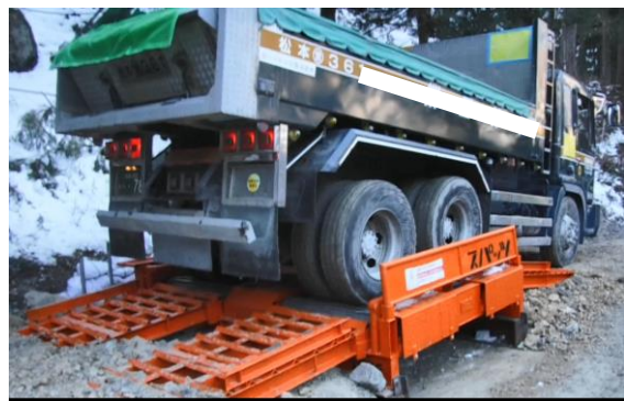
写真4-1-16 タイヤ洗浄機設置の状況（一例）
