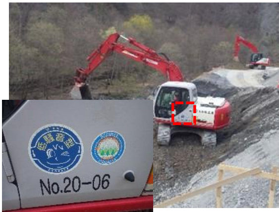
写真4-1-3 排出ガス対策型、低騒音型 建設機械の採用 (一例)
