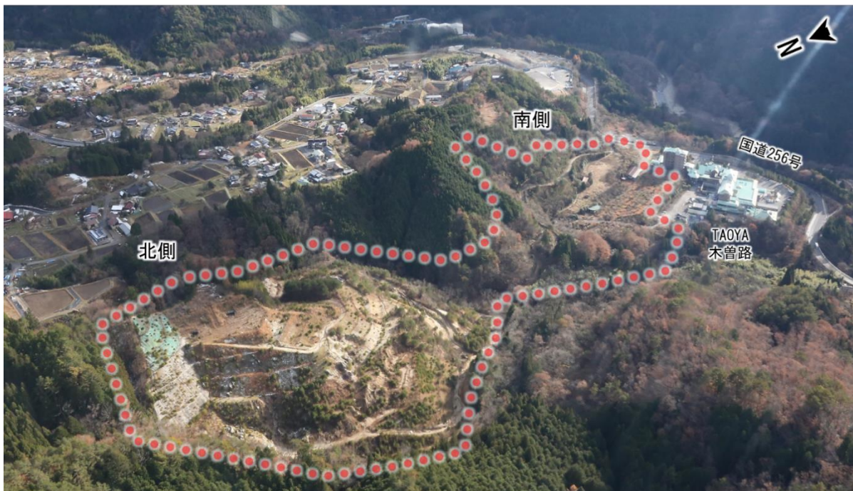
写真 2-1 発生土置き場 (押出北) 計画地の工事前の状況
