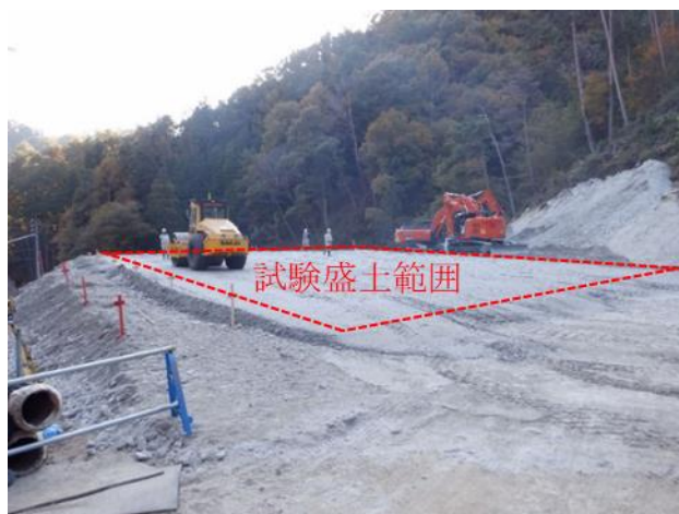
・写真は中央新幹線伊那山地トンネル新設(戸中・壬生沢工区)における類似工事の例を示している
