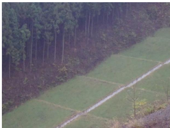
図 5-1 植生による法面保護工のイメージ
