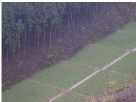
図 5-1 植生による法面保護工のイメージ
