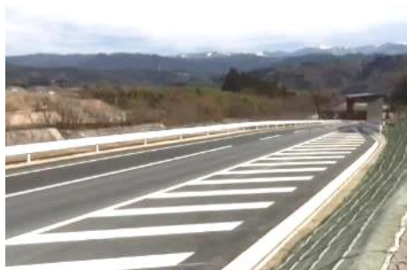
町道洞新線新設・拡幅
