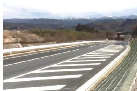
町道洞新線新設・拡幅
