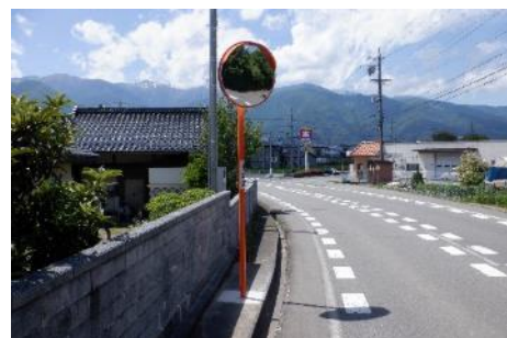
カーブミラー新設
