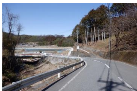
見通し不良区間の立木伐採
