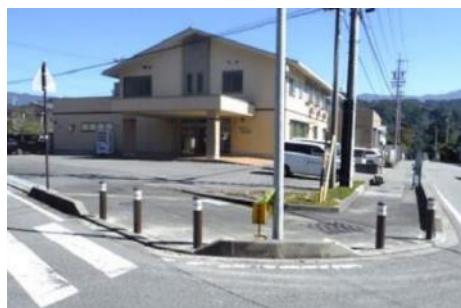
車止めポストの設置
