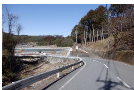
見通し不良区間の立木伐採
