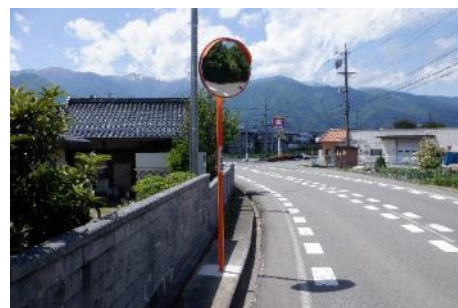
カーブミラー新設
