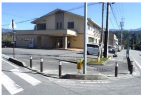
車止めポストの設置
