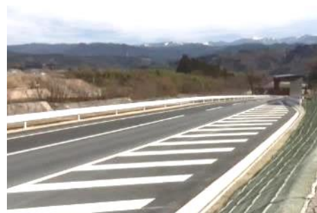
町道洞新線新設・拡幅
