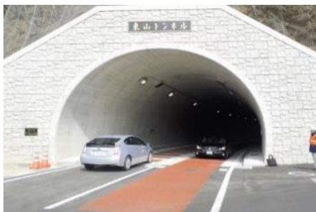
主要地方道松川インター大鹿線 東山トンネル新設
