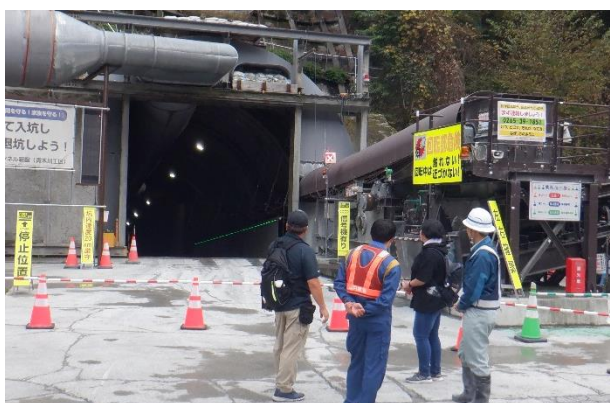
青木川工区の坑口を見学
