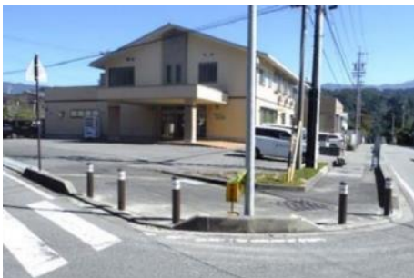
車止めポストの設置
