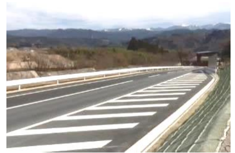
町道洞新線新設・拡幅
