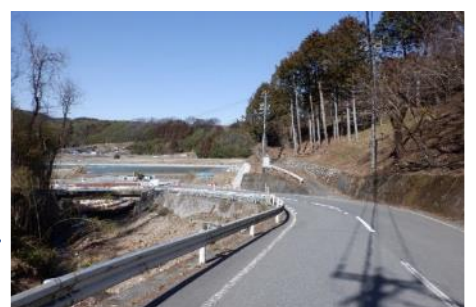
見通し不良区間の立木伐採
