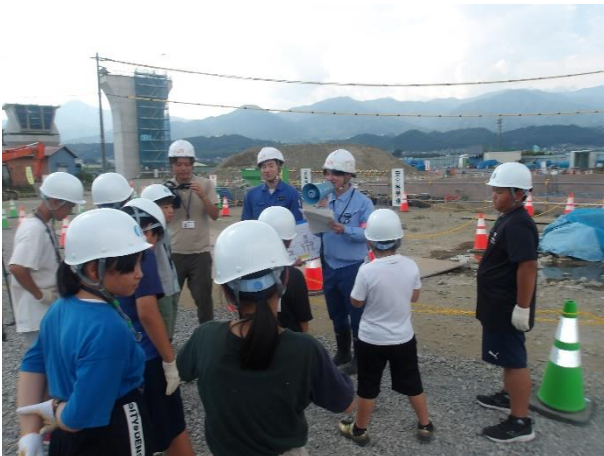
工事現場を見学する子ども達
