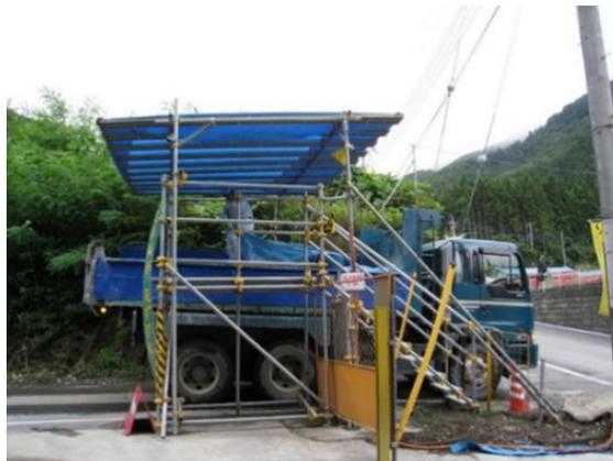
写真④ 防塵シートの設置
