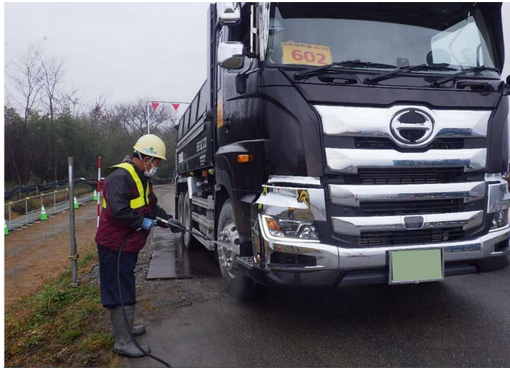
タイヤ洗浄の状況
