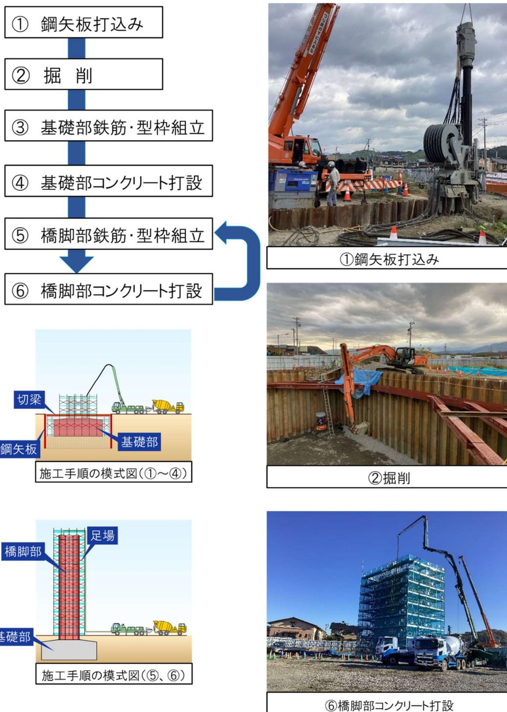
※一部の直接基礎については、①鋼矢板打込みを行わず、安定勾配にて②掘削を行う場合がある。
