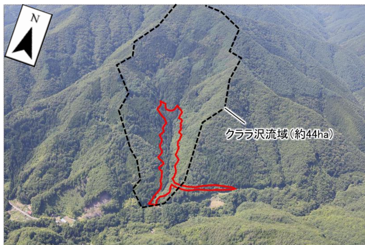
写真 2-1 発生土置き場 (クララ沢) 計画地の工事前の状況
