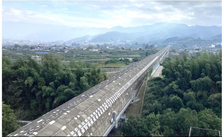
山梨リニア実験線での施工事例(緩衝工)
