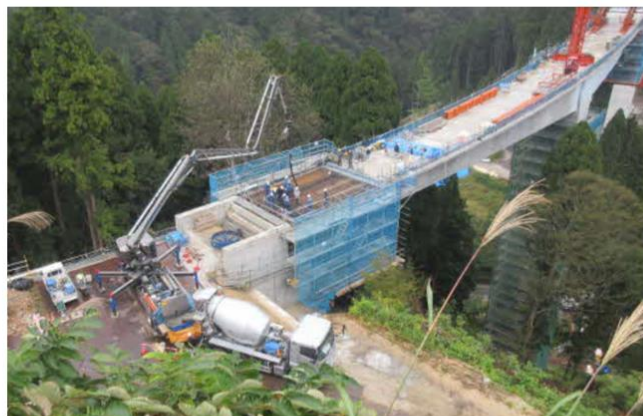
支保工施工部
