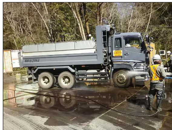
写真② タイヤ洗浄の例
