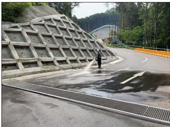
写真① 工事施工ヤード等の清掃、散水の例
