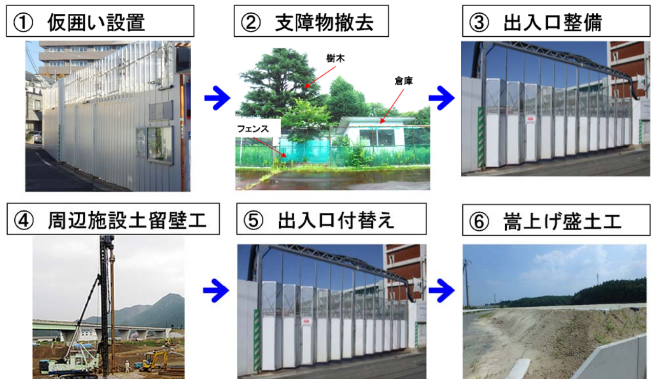
図 2-4 (3) 準備工・周辺施設土留壁工の施工手順③
