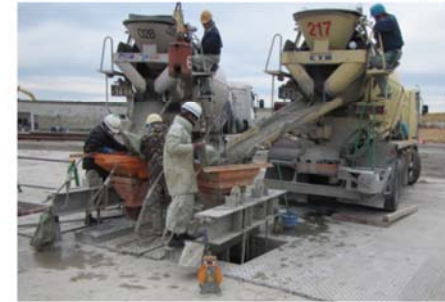
図 2-4 (7) 非常口土留壁工の施工手順③
