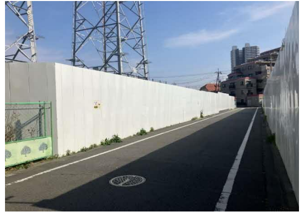
写真4-1-6-2 仮囲い・防音シート等の設置 (仮囲いの設置)
