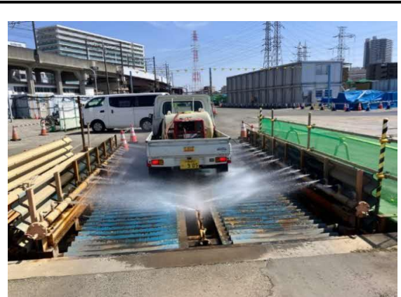
写真4-1-6-20 資材及び機械の運搬に用いる 車両の出入口等の清掃、散水 及びタイヤの洗浄 (タイヤ洗浄)
