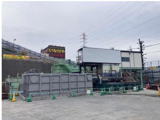
写真 4-1-4-7 工事排水の監視、工事排水の適切な処理 (濁水処理設備の設置)
