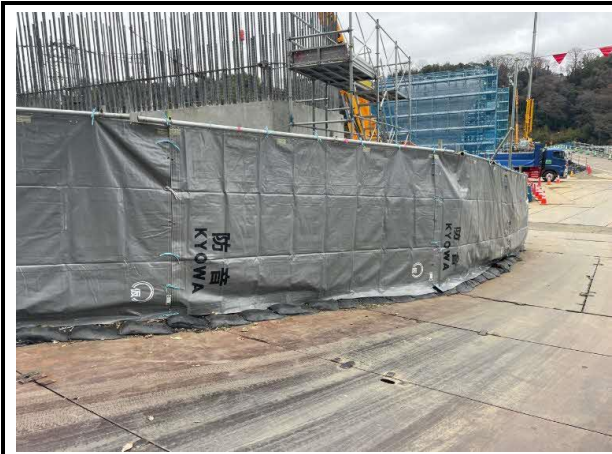
写真4-1-8-1 防音シート等の設置による遮音対策
