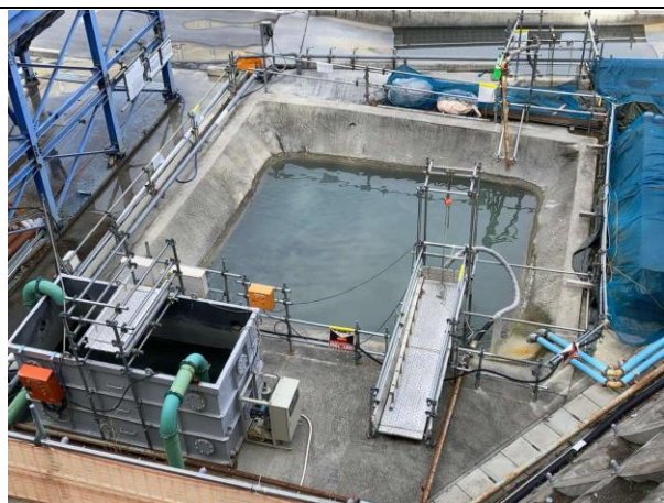
写真4-1-10-15 汚濁処理設備及び仮設沈砂池の設置
