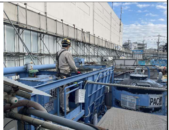
写真4-1-3-6 工事排水の監視 工事排水の適切な処理
