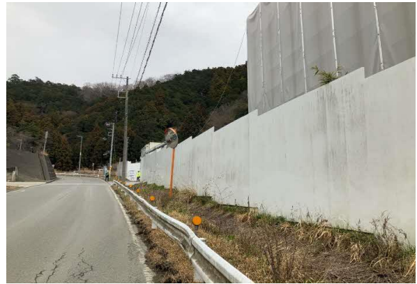
写真4-1-12-2 仮囲い・防音シート等の設置 (仮囲い設置)
