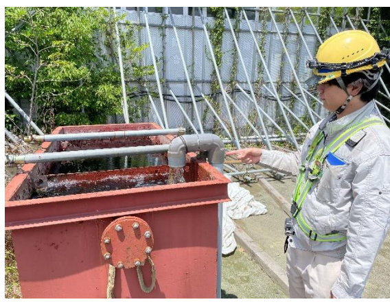
写真4-1-1-2 工事排水の適切な処理
