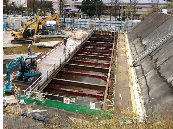
写真 4-1-4-9 仮置き場における発生土の適切な管理 (土砂ピット)
