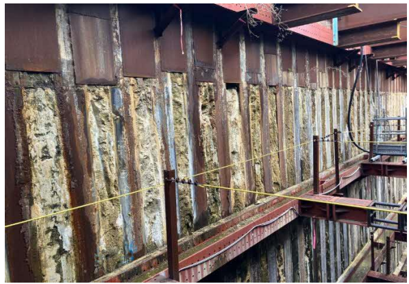
写真4-1-6-8 止水性の高い山留め工法等の採用 地質の状況等に応じた山留め工法等の採用
