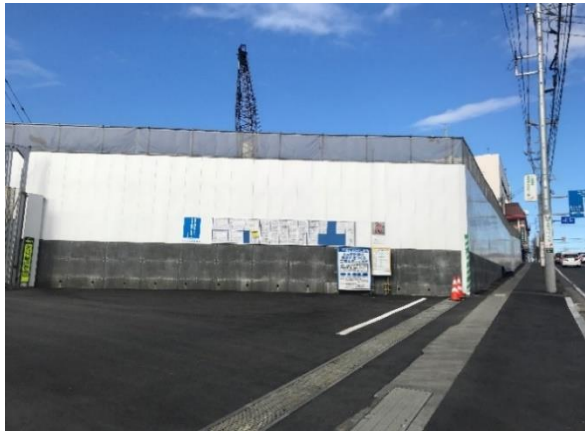
写真4-1-3-1 仮囲い・防音シート等の設置 (仮囲い設置)
