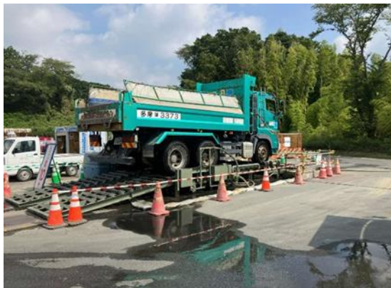
写真4-1-5-8 資材及び機械の運搬に用いる 車両の出入口等の清掃、散水及びタイヤの洗浄 外来種の拡大抑制
