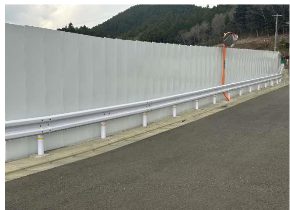
写真 4-1-11-6 仮囲い・防音シート等の設置 (仮囲い設置)
