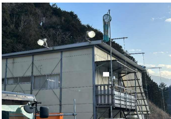
写真4-1-12-11 照明の漏れ出しの抑制等 (遮光設備 (ルーバー) の設置)
