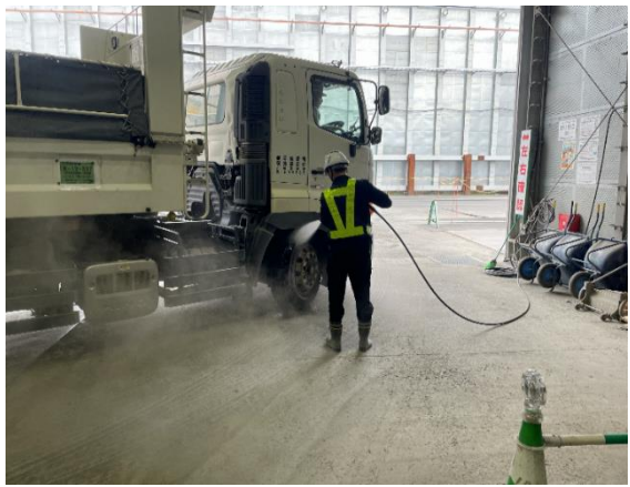
写真4-1-2-10 資材及び機械の運搬に用いる車両の 出入口等の清掃、散水及びタイヤの洗浄
