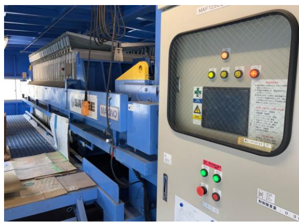
写真4-1-10-16 建設汚泥の脱水処理
