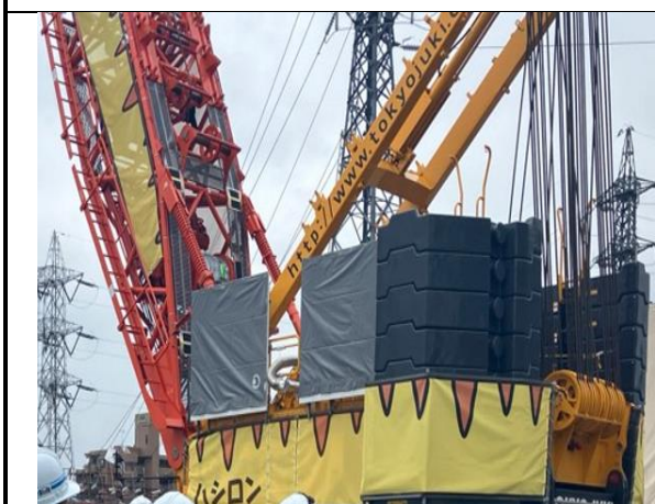
写真4-1-7-11 防音シート等の設置 (350tクレーン)
