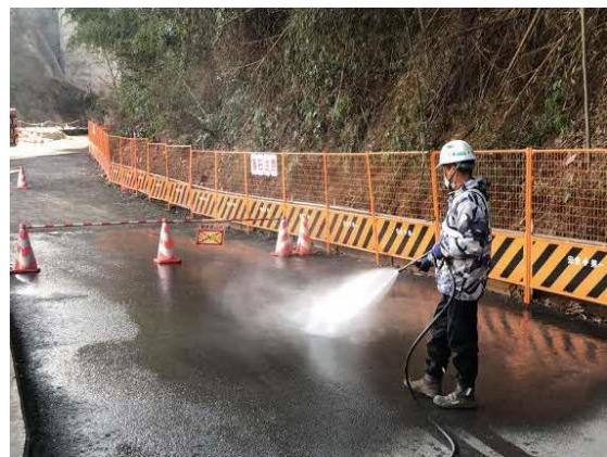
写真 4-1-9-6 工事現場の清掃及び散水
