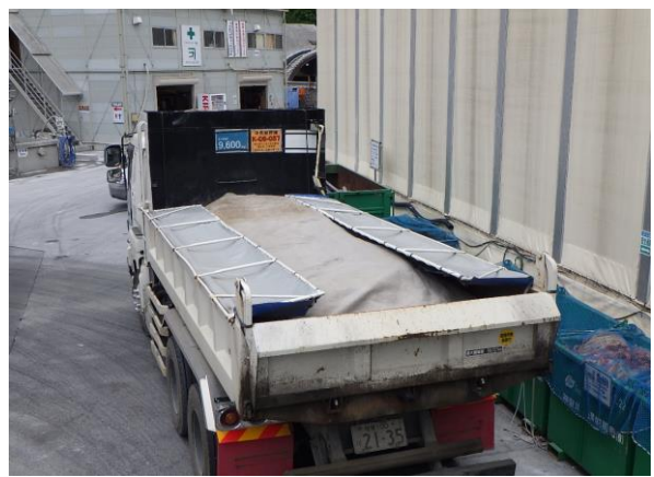
写真4-1-10-6 荷台への防じんシート敷設及び散水 (防じんシートの敷設)
