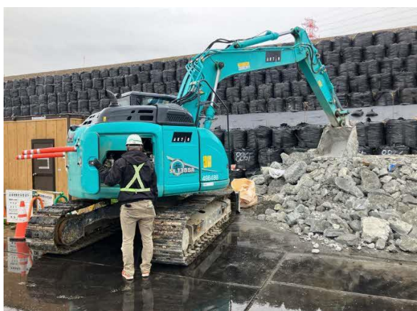
写真4-1-6-5 建設機械の点検および整備による性能維持
