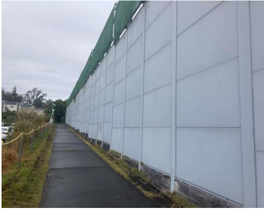
写真4-1-5-1(1) 仮囲い・防音シート等の設置
