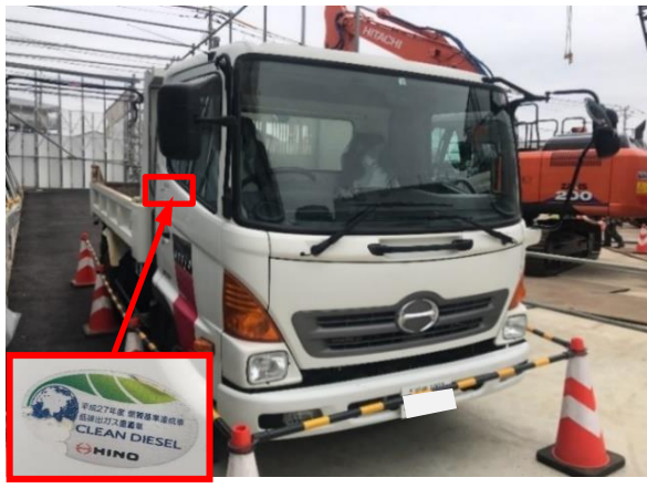
写真4-1-3-13 低燃費車種の選定、積載の効率化、 運搬計画の合理化による運搬距離の最適化
