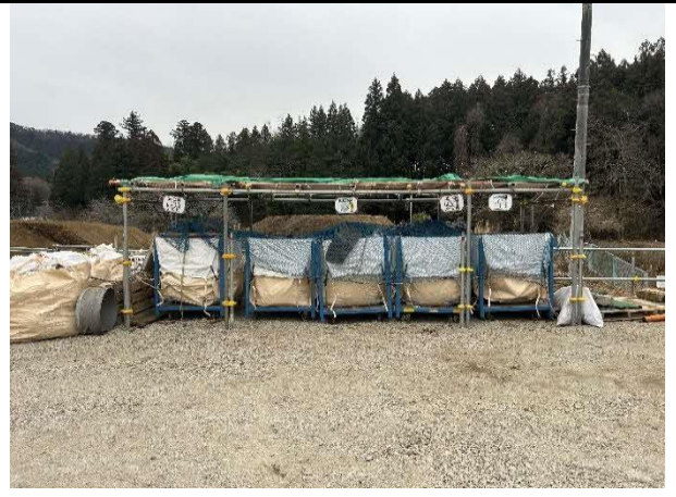
写真4-1-11-14 副産物の分別・再資源化
