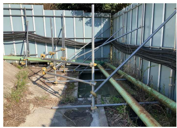
写真4-1-12-10 濁水処理設備及び仮設沈砂池の設置
