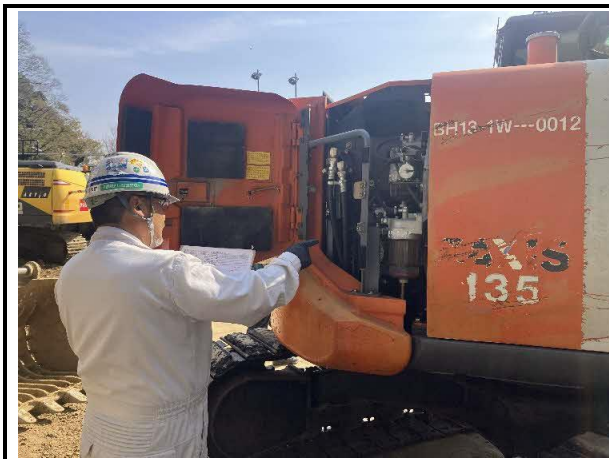
写真4-1-8-7 建設機械の点検及び整備による性能維持
