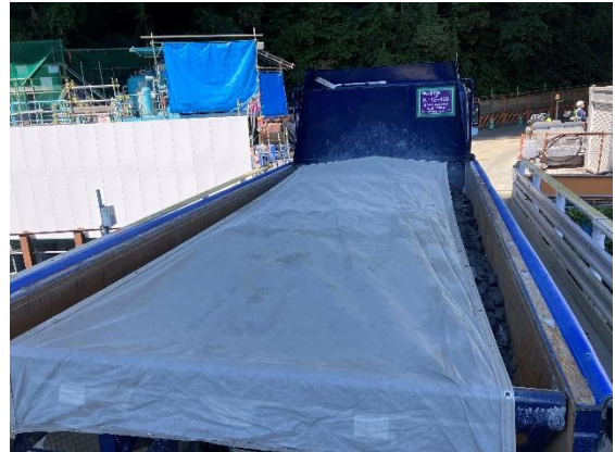
写真 4-1-9-10 荷台への防じんシート敷設及び散水 (防じんシートの敷設)
