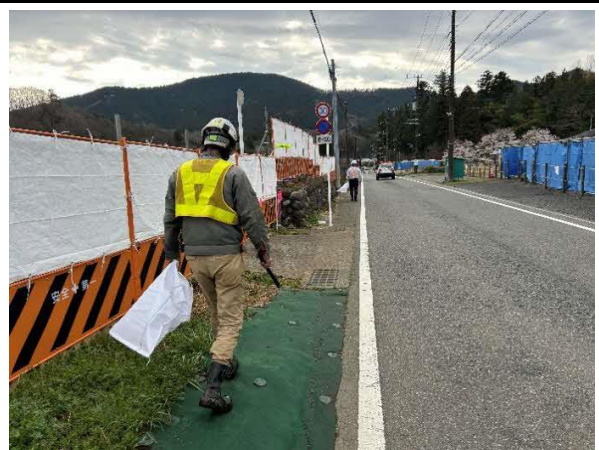
写真 4-1-11-2 工事現場の清掃及び散水
