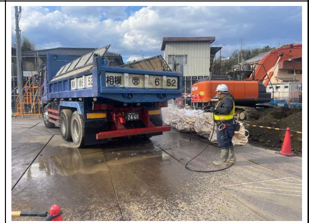
写真4-1-8-10 外来種の拡大抑制 (タイヤ洗浄)
