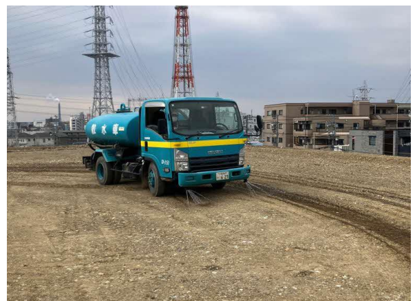
写真4-1-6-6 工事現場の清掃及び散水
