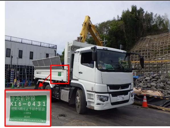
写真4-1-8-16 工事に使用する道路、 搬入時間及び法定制限速度の遵守 (車両標識明示による安全運転意識の向上)
