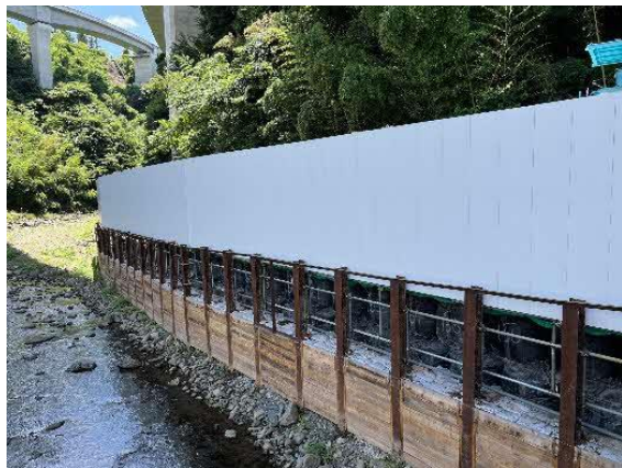
写真 4-1-9-3 仮囲い・防音シート等の設置 (仮囲い設置)
