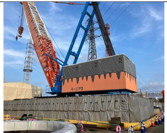
写真4-1-7-10 防音シート等の設置 (750tクレーン)
