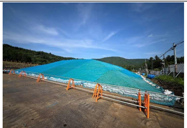
写真 4-1-11-12 仮置き場における発生土の適切な管理
