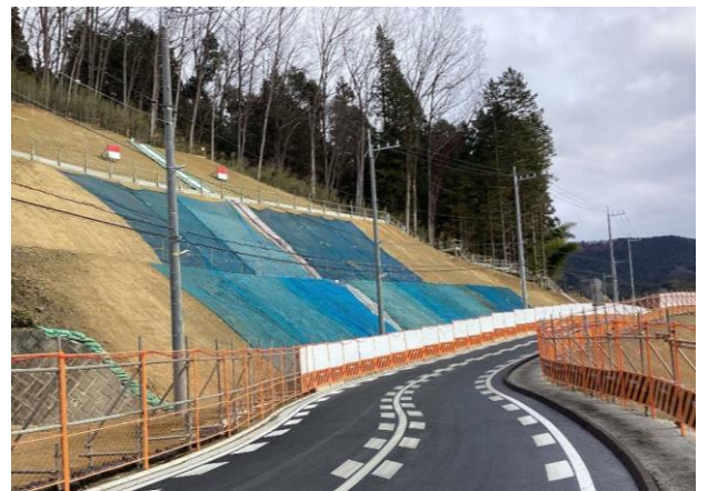
写真4-1-11-10 法面等の防護
