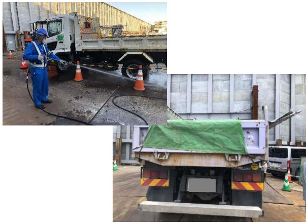
写真4-1-2-9 荷台への防じんシート敷設及び散水
