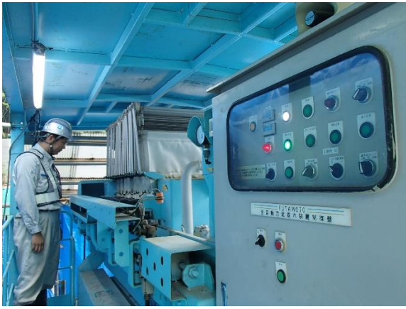
写真 4-1-9-7 建設汚泥の脱水処理
