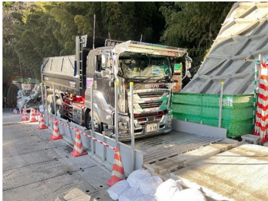
写真 4-1-9-9 資材及び機械の運搬に用いる 車両の出入り口等の清掃、散水及びタイヤの洗浄 外来種の拡大抑制のためのタイヤ洗浄
