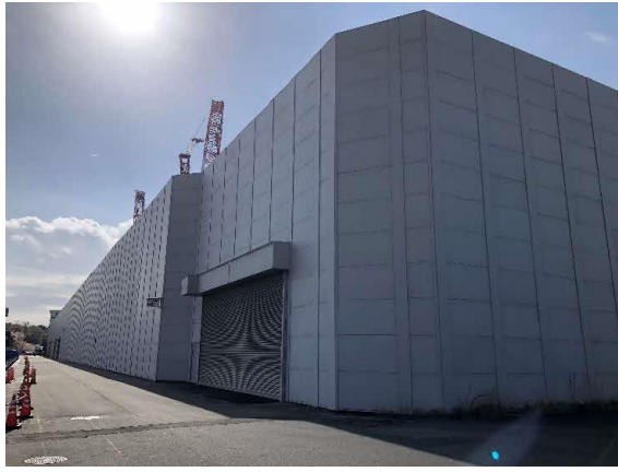
写真4-1-2-1 仮囲い・防音シート等の設置 (仮囲い設置)
