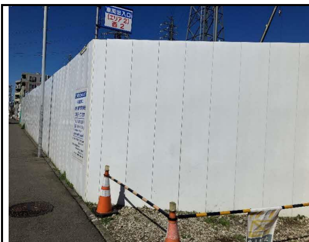
写真4-1-7-1 仮囲いの設置
