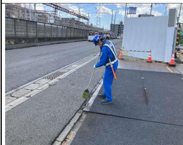
写真4-1-7-5 工事現場の清掃、散水
