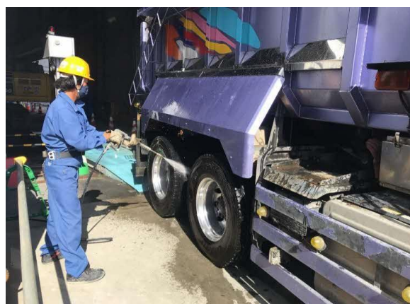
写真4-1-3-11 資材及び機械の運搬に用いる 車両の出入口等の清掃、散水及びタイヤの洗浄
