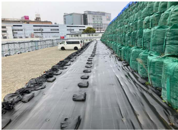
写真4-1-6-9 仮置場における発生土の適切な管理
