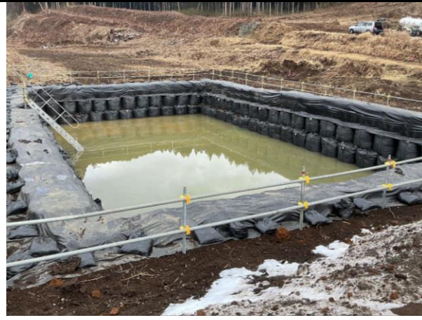
写真 4-1-11-7 工事排水の適切な処理
