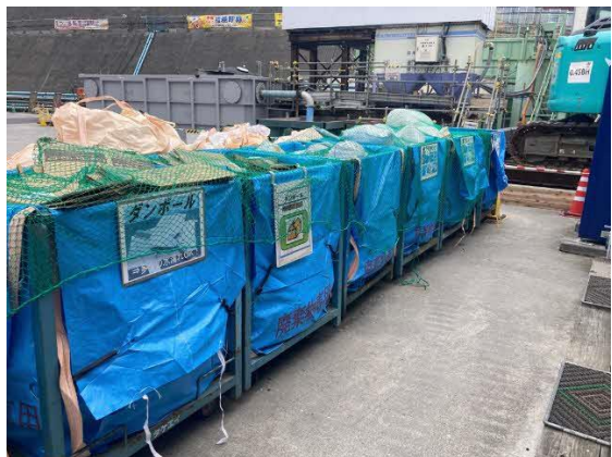
写真 4-1-4-10 副産物の分別、再資源化
