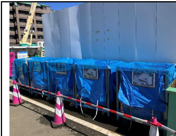
写真4-1-7-7 副産物の分別、再資源化
