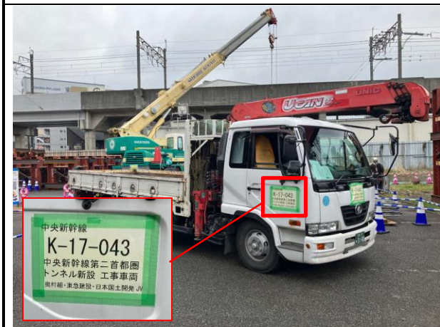
写真4-1-7-9 工事に使用する道路、 搬入時間及び法定制限速度の遵守 (車両標識明示に依る安全運転意識)
