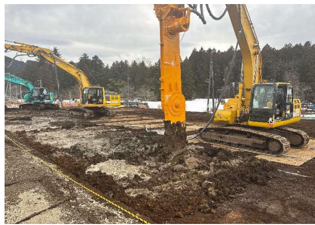
写真 4-1-11-9 地盤改良及び補強材の適切な配置
