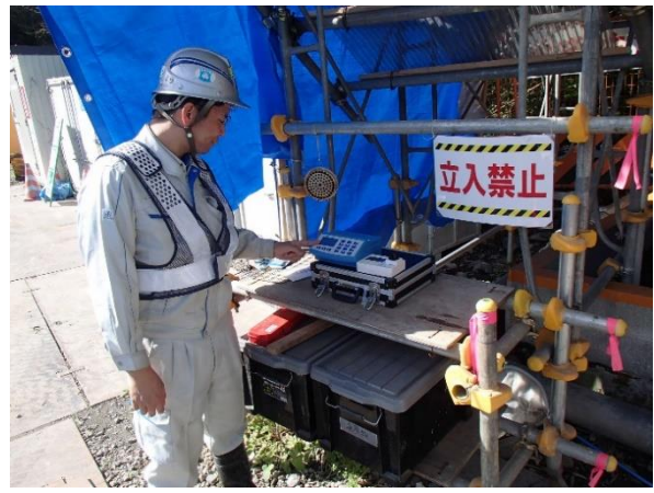
写真 4-1-9-14 工事排水の監視
