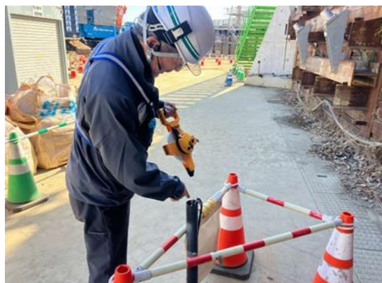
写真4-1-5-9 工事排水の監視 工事排水の適切な処理 濁水処理設備の設置
