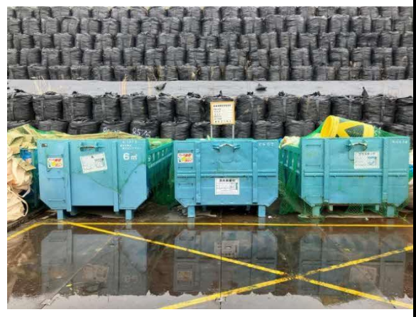
写真4-1-6-14 副産物の分別・再資源化
