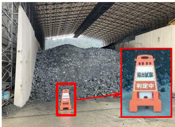
写真4-1-12-9 発生土に含まれる自然由来の重金属等の定期的な調査
