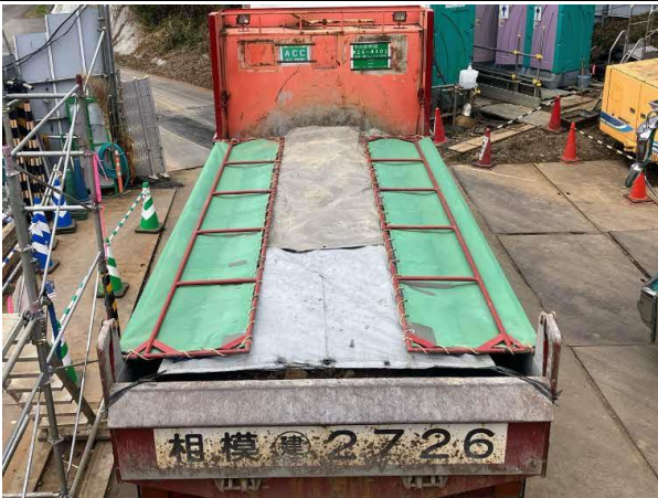
写真4-1-8-15 荷台への防じんシート敷設及び散水 (防じんシートの敷設)
