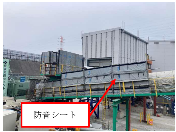
写真 4-1-4-1(2) 仮囲い・防音シート等の設置
