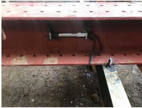
写真4-1-6-13 山留め材及び周辺地盤の計測管理
