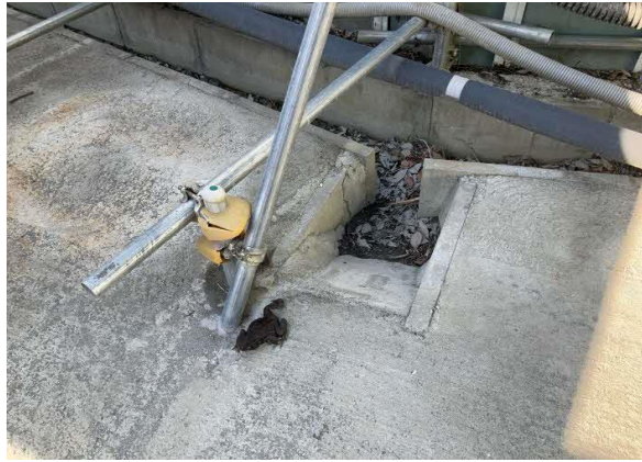
写真4-1-12-7 小動物が脱出可能な側溝の設置
