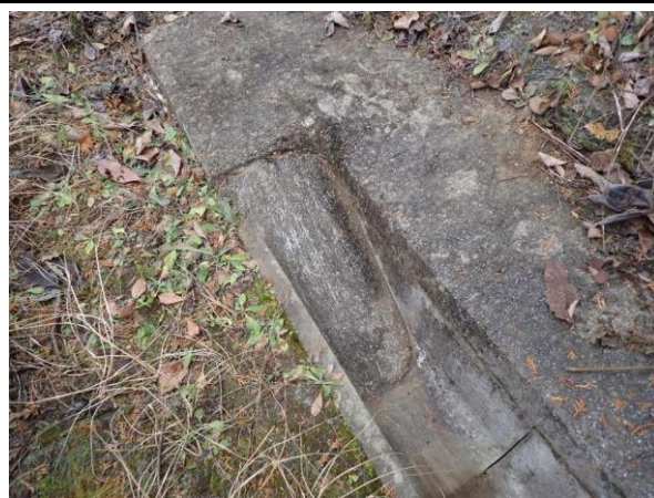
写真4-1-10-14 小動物が脱出可能な側溝の設置
