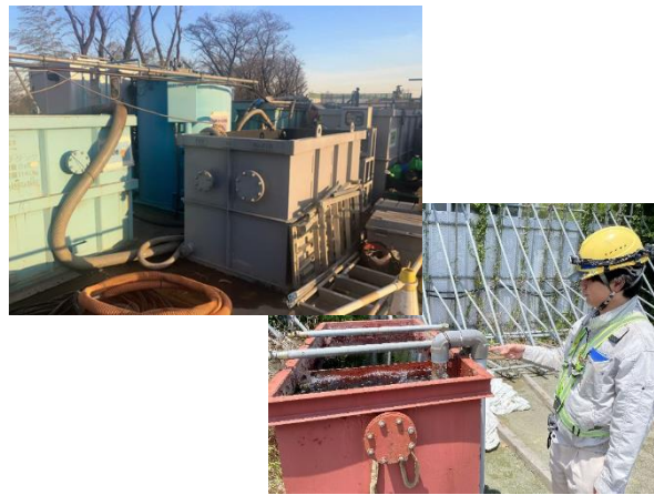
写真4-1-5-9 工事排水の監視 工事排水の適切な処理 濁水処理設備の設置
