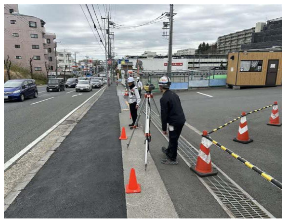
写真4-1-2-8 山留め材及び周辺地盤の計測管理
