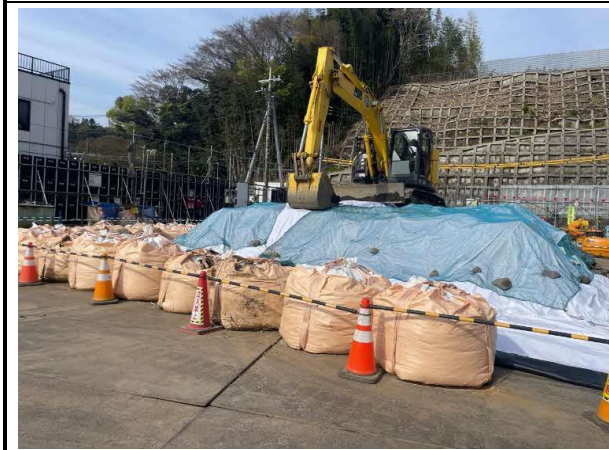
写真4-1-8-9 仮置き場における掘削土砂の適切な管理
