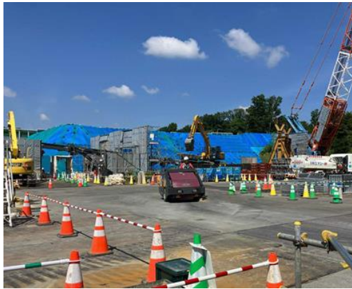
写真4-1-5-6 工事現場の清掃及び散水
