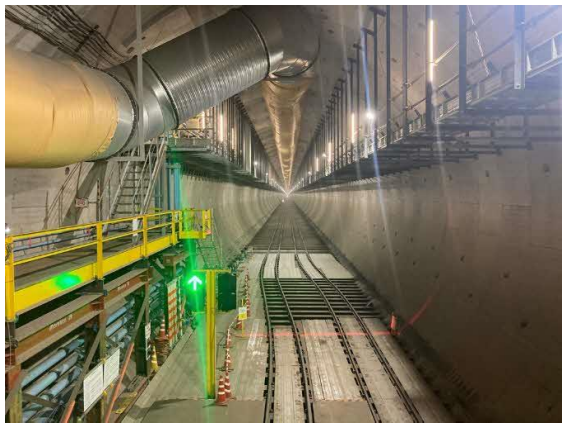
写真 4-1-4-6 適切な構造及び工法の採用 (密閉性の高いシールド工法の採用)
