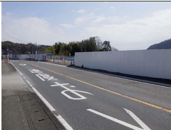
写真4-1-8-3 仮囲いの設置
