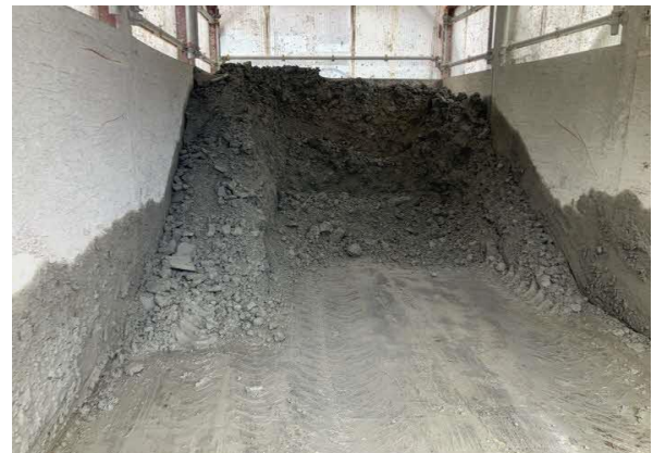
写真4-1-12-12 建設汚泥の脱水処理
