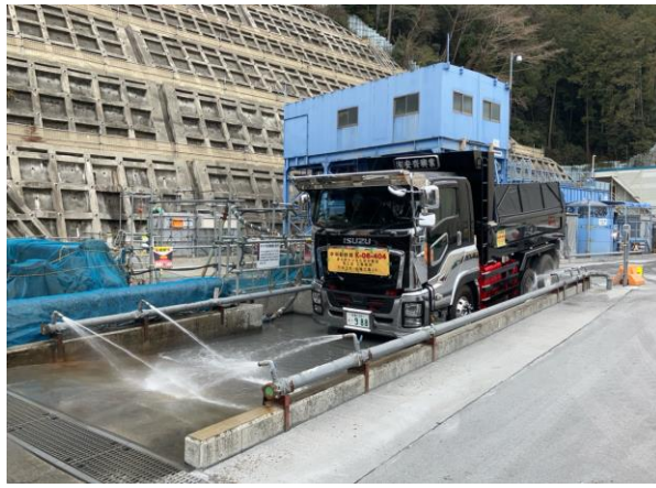
写真4-1-10-7 資材及び機械の運搬に用いる 車両の出入り口等の清掃、散水及びタイヤの洗浄 外来種の拡大抑制（タイヤ洗浄の実施）
