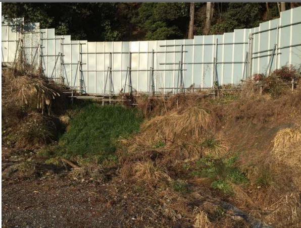
写真4-1-10-3 仮囲い・防音シート等の設置 (仮囲い設置)
