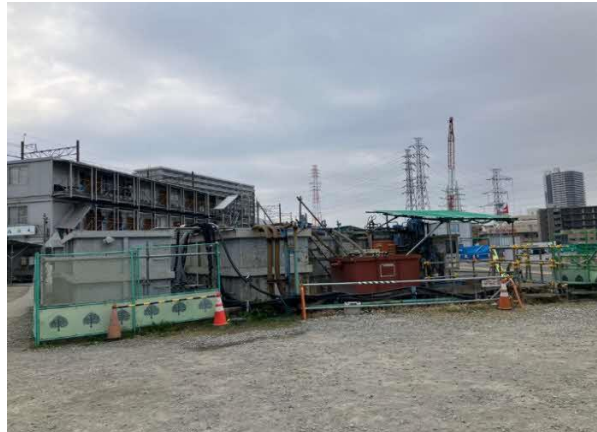
写真4-1-6-10 工事排水の監視 処理設備の点検・整備による性能維持 工事排水の適切な処理
