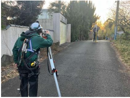
写真4-1-5-12 山留め材及び周辺地盤の計測管理
