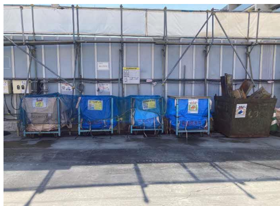
写真4-1-3-10 副産物の分別・再資源化
