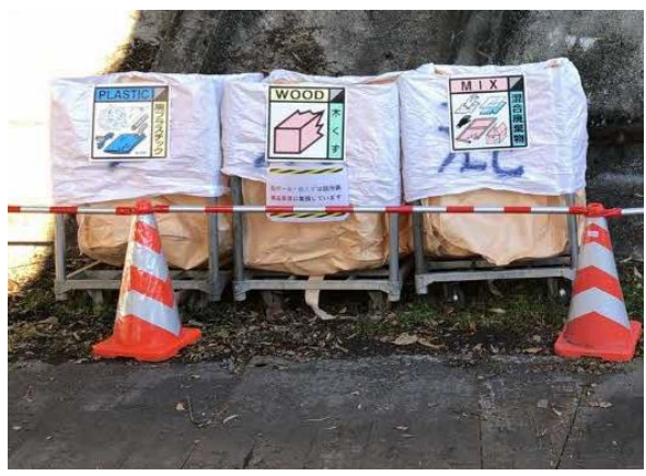
写真 4-1-9-8 副産物の分別・再資源化
