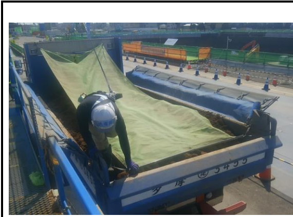
写真4-1-6-19 荷台への防じんシート敷設及び散水 (防じんシートの敷設)
