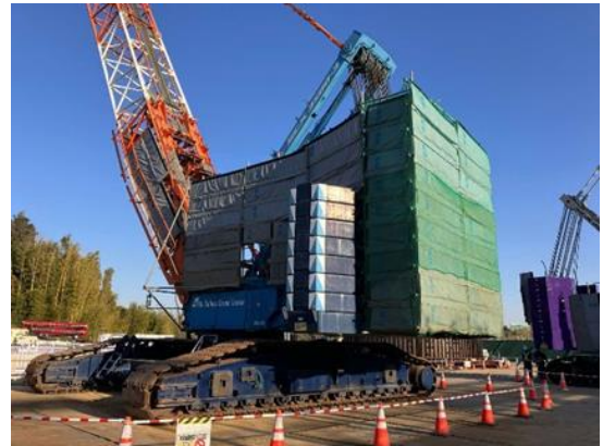
写真4-1-5-1(2) 仮囲い・防音シート等の設置 (エンジン周りに防音シートを設置)
