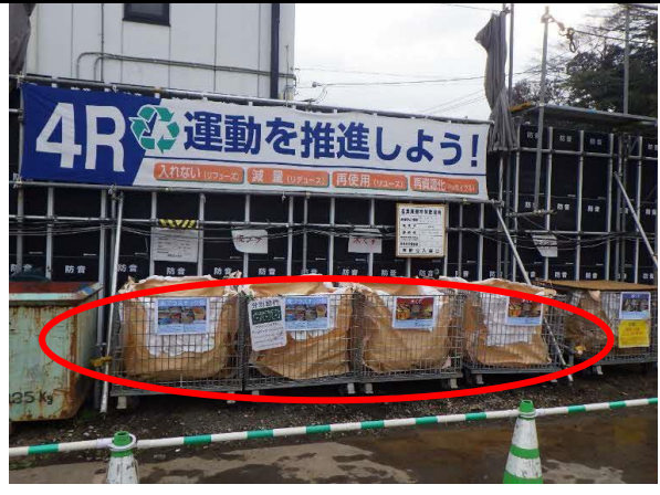
写真4-1-8-14 副産物の分別、再資源化
