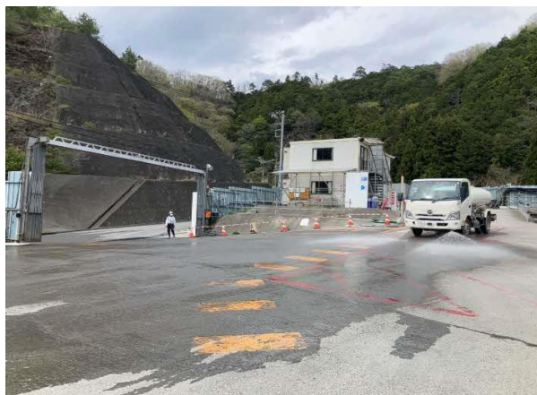
写真4-1-12-5 工事現場の清掃及び散水
