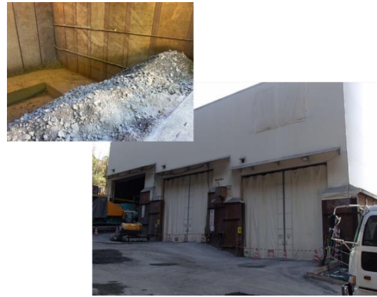
写真 4-1-9-16 土砂ピットにおける発生土の適切な管理
