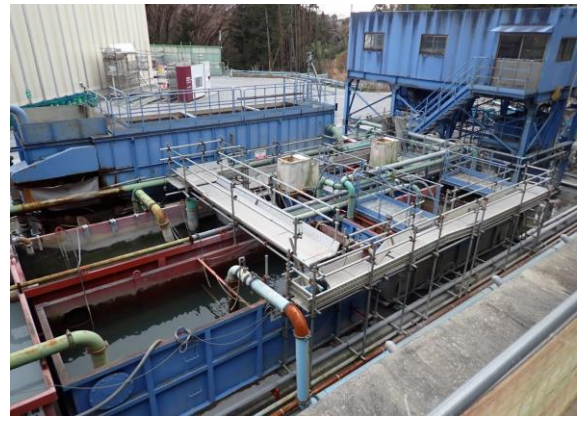
写真4-1-10-8 工事排水の適切な処理
