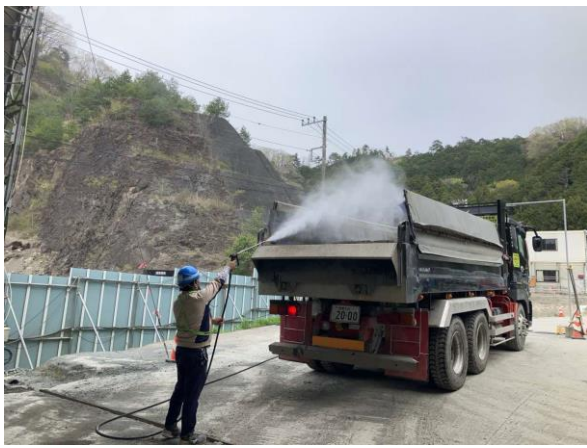
写真4-1-12-13 荷台への防じんシート敷設及び散水
