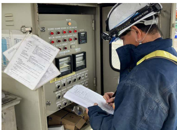
写真4-1-6-11 工事排水の監視 処理設備の点検・整備による性能維持
