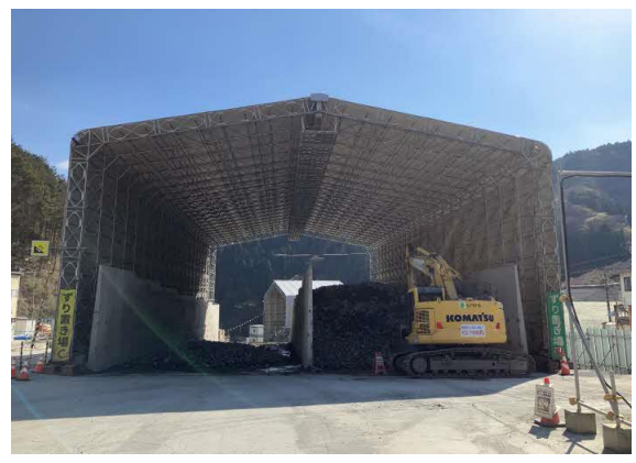
写真4-1-12-8 仮置場における発生土の適切な管理
