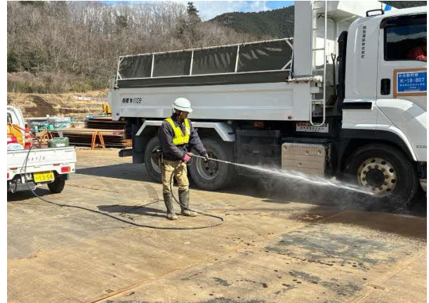
写真 4-1-11-4 資材及び機械の運搬に用いる 車両の出入り口等の清掃、散水及びタイヤの洗浄 外来種の拡大抑制（タイヤ洗浄）
