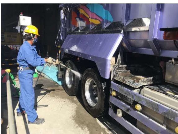
写真4-1-2-11 資材及び機械の運搬に用いる 車両の出入口等の清掃、散水及びタイヤの洗浄
