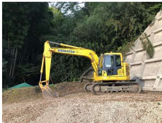
写真 4-1-8-2 工事規模に合わせた建設機械の選定
