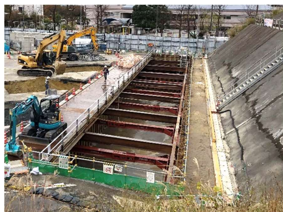
写真 4-1-3-9 仮置き場における発生土の適切な管理 (土砂ピット)
