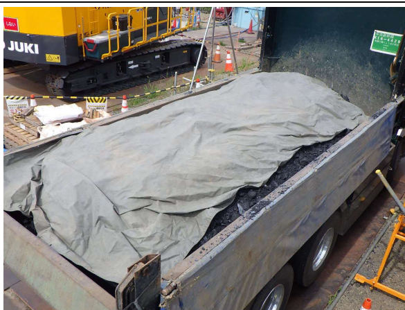
写真 4-1-7-17 荷台への防じんシートの敷設状況
