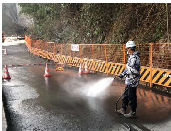
写真 4-1-8-6 現場の清掃及び散水
