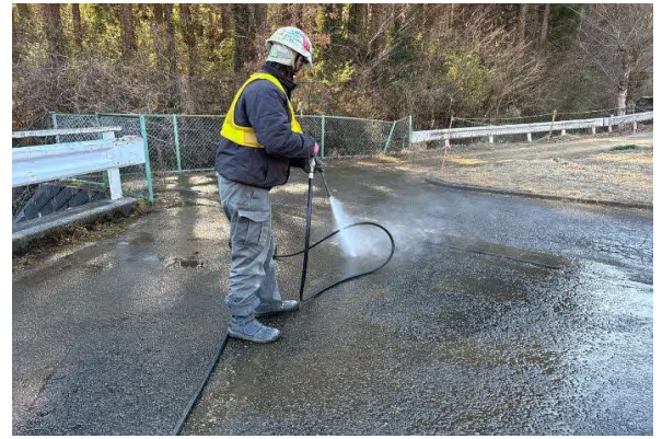
写真 4-1-10-2 工事現場の清掃及び散水
