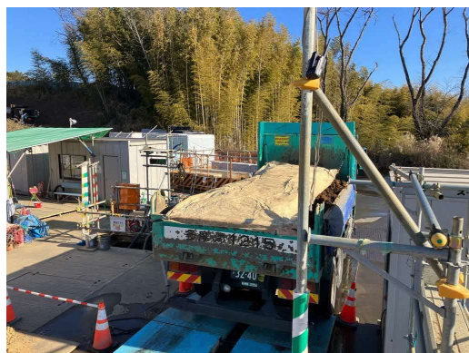
写真4-1-4-7 荷台への防塵シート敷設
