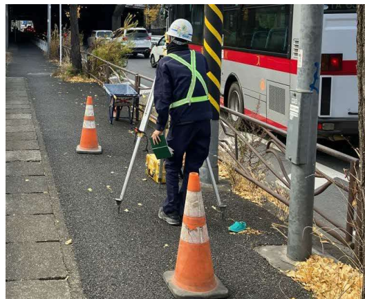
写真4-1-1-8 山留め材及び周辺地盤の計測管理
