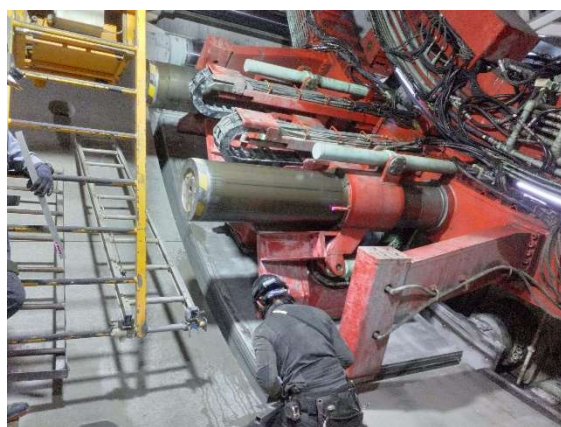
写真4-1-1-6 適切な構造及び工法の採用 (密閉性の高いシールド工法の採用)
