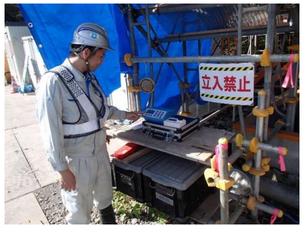
写真 4-1-8-14 工事排水の監視
