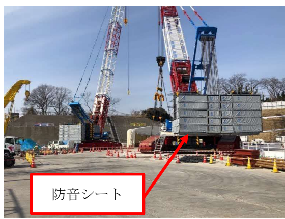
写真 4-1-3-1(2) 仮囲い・防音シート等の設置状況
