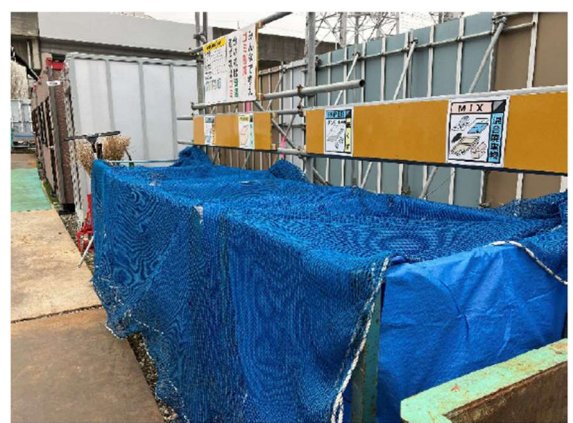
写真4-1-6-6 副産物の分別・再資源化
