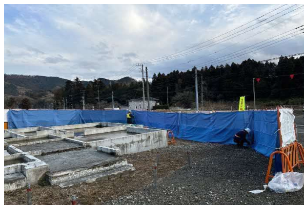
写真4-1-10-5 仮囲い・防音シート等の設置
