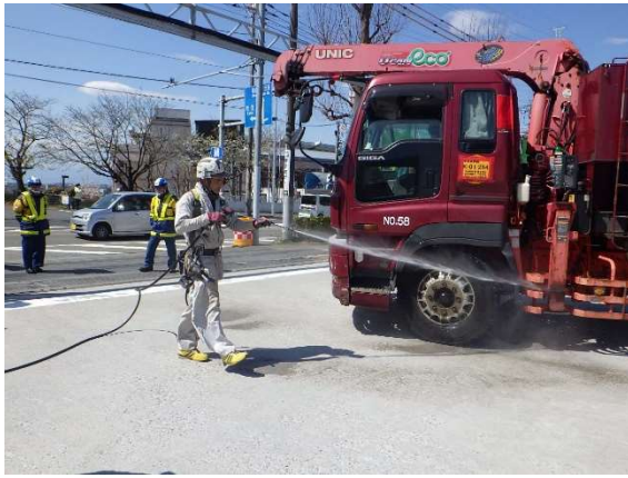
写真 4-1-3-12 資材及び機械の運搬に用いる車両の 出入り口等の清掃、散水及びタイヤの洗浄
