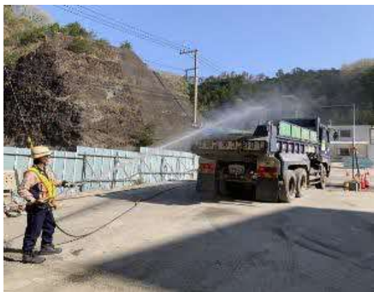
写真4-1-11-13 荷台への防塵シート敷設及び散水
