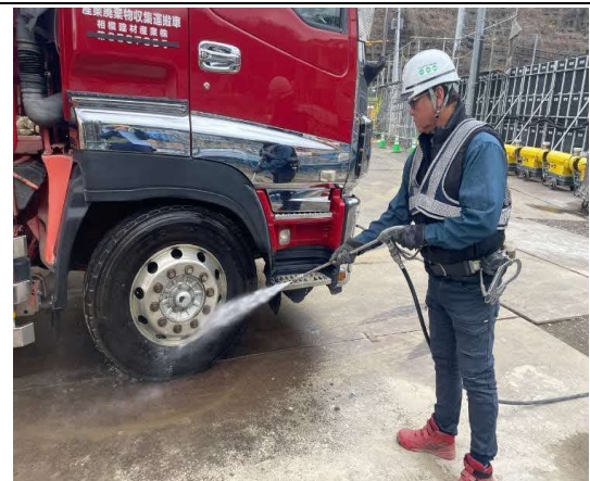
写真 4-1-7-12 外来種の拡大抑制 (工事用車両のタイヤの洗浄)
