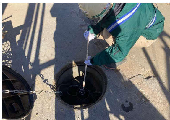
写真4-1-4-9 下水道への排水 工事排水の監視 工事排水の適切な処理 (濁水処理設備の設置状況)
