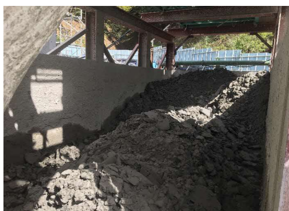
写真4-1-11-12 建設汚泥の脱水処理
