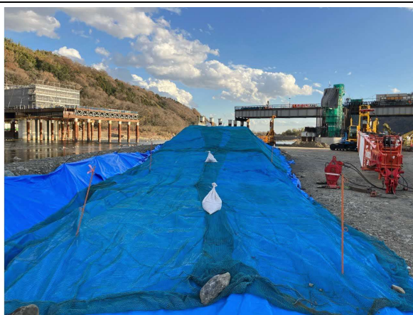
写真 4-1-7-11 仮置き場における掘削土砂の適切な管理
