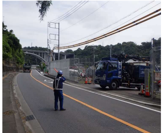
写真 4-1-7-20 交通誘導員による誘導
