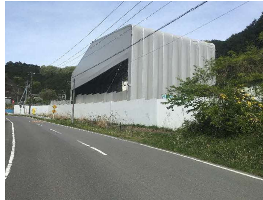
写真4-1-11-2 仮囲い・防音シート等の設置状況 (仮囲い設置状況)
