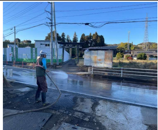
写真 4-1-7-16 資材及び機械の運搬に用いる車両の出入口、 周辺道路の清掃及び散水
