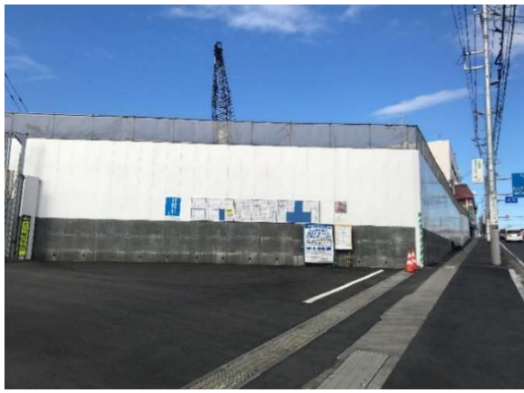
写真4-1-2-1 仮囲い・防音シート等の設置状況 (仮囲い設置状況)
