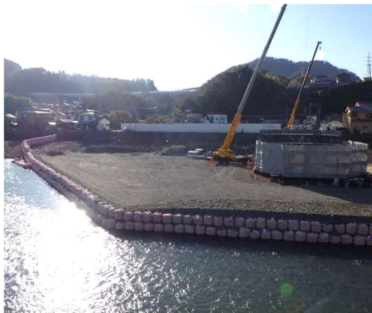
写真 4-1-7-9 仮締切工の実施
