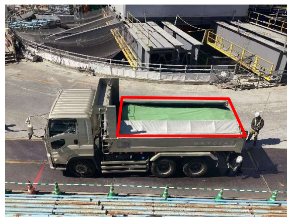
写真 4-1-3-11 荷台への防塵シート敷設
