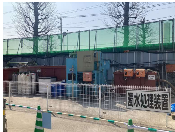
写真 4-1-3-7 工事排水の監視 工事排水の適切な処理 (濁水処理設備の設置状況)
