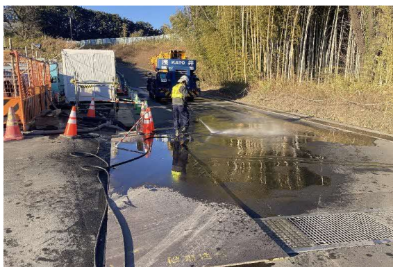
写真4-1-4-6 工事現場の清掃及び散水
