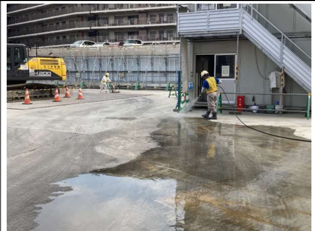
写真4-1-2-4 工事現場の清掃及び散水
