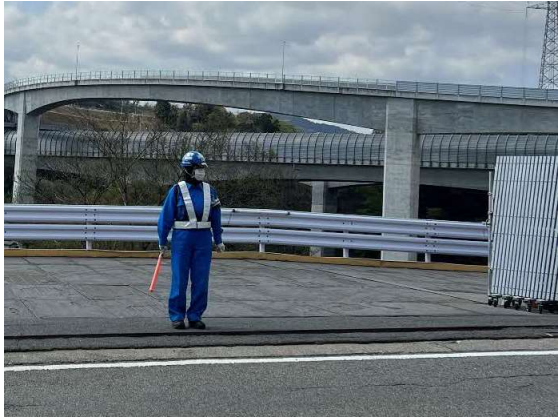
写真 4-1-8-18 交通誘導員による誘導
