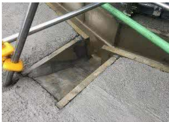
写真4-1-11-7 小動物が脱出可能な側溝の設置
