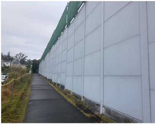
写真4-1-4-1 (1) 仮囲い・防音シート等の設置
