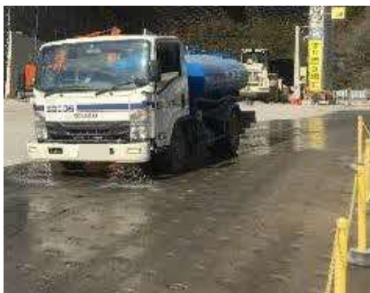
写真4-1-11-5 工事現場の清掃及び散水
