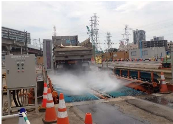
写真4-1-5-15 資材及び機械の運搬に用いる車両の出入り口等の 清掃、散水及びタイヤの洗浄
