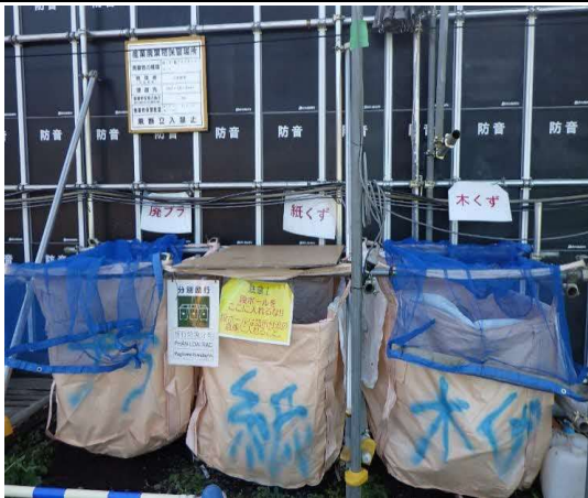
写真 4-1-7-15 副産物の分別、再資源化
