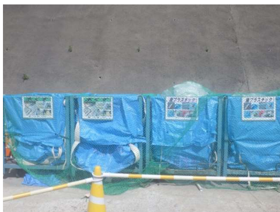
写真 4-1-3-10 副産物の分別、再資源化
