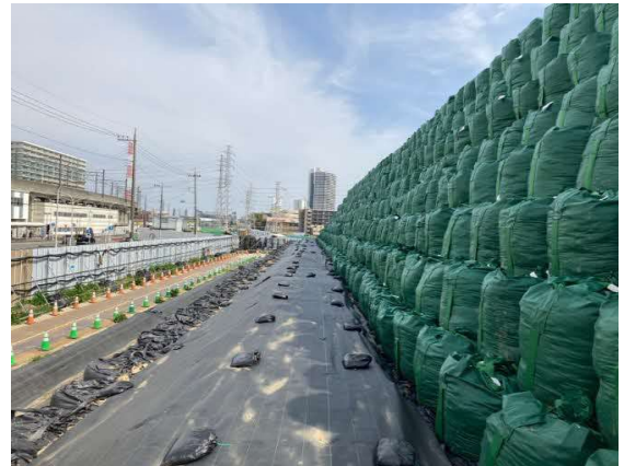
写真4-1-5-10 仮置場における発生土の適切な管理
