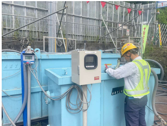
写真 4-1-7-7 工事排水の適切な処理 工事排水の監視
