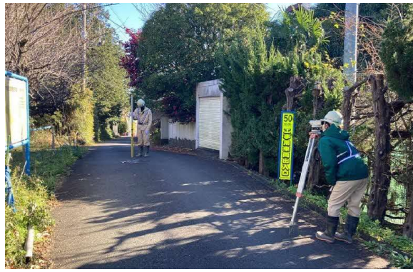
写真4-1-4-12 山留め材及び周辺地盤の計測管理
