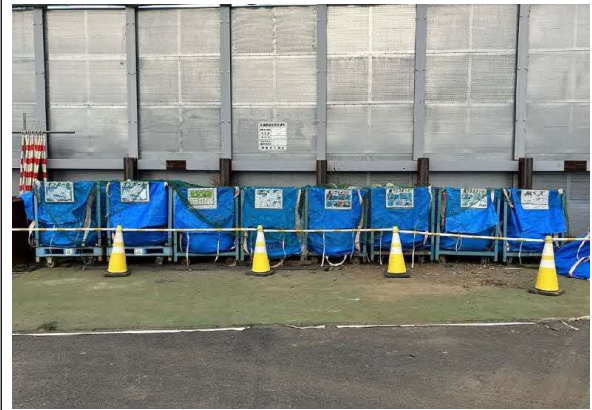
写真4-1-4-13 副産物の分別・再資源化
