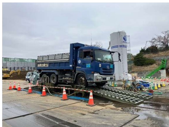
写真4-1-4-8 散水及びタイヤの洗浄
