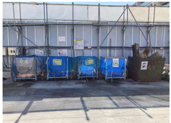
写真4-1-2-10 副産物の分別・再資源化
