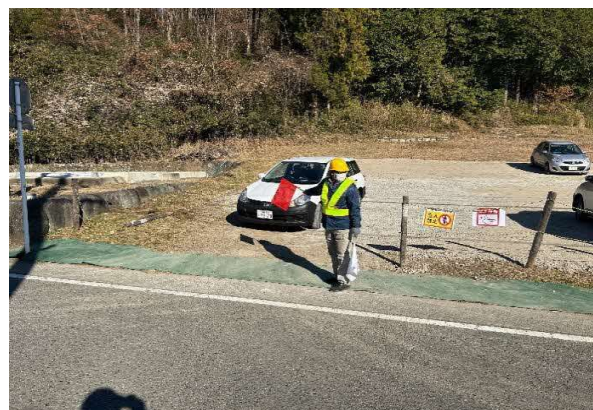
写真4-1-10-7 交通誘導員による誘導
