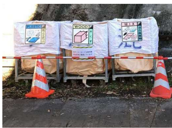
写真 4-1-8-8 副産物の分別・再資源化
