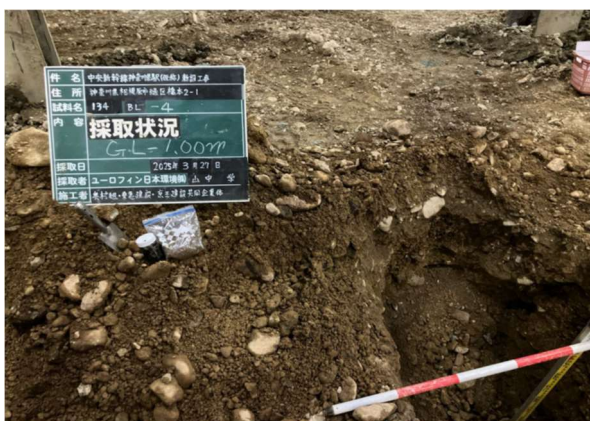
写真4-1-5-11 有害物質の有無の確認と汚染土壌の適切な処理
