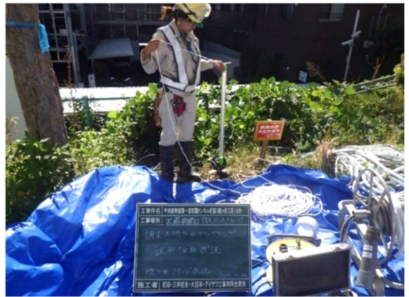
写真4-1-2-8 地下水の継続的な監視
