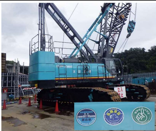
写真 4-1-7-3 排出ガス対策型建設機械の採用 低騒音型建設機械の採用
