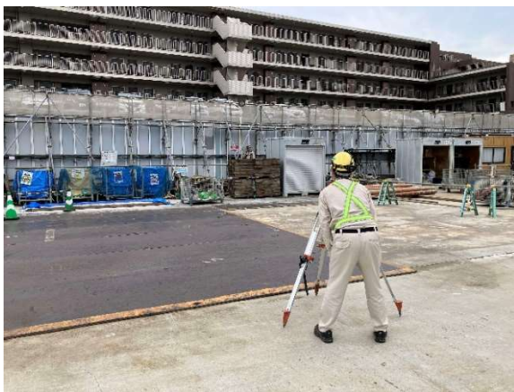
写真4-1-2-9 周辺地盤の計測管理
