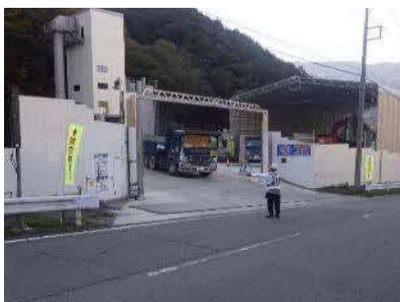
写真4-1-11-15 交通誘導員による誘導
