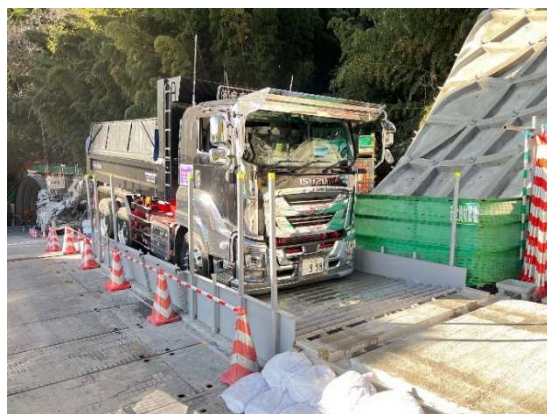
写真 4-1-8-9 タイヤ洗浄の実施
