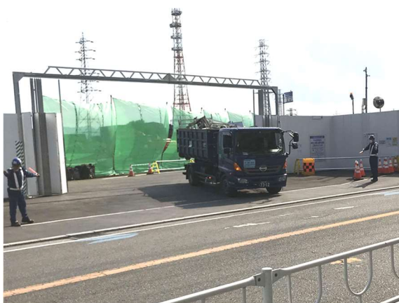
写真4-1-5-17 交通誘導員による誘導
