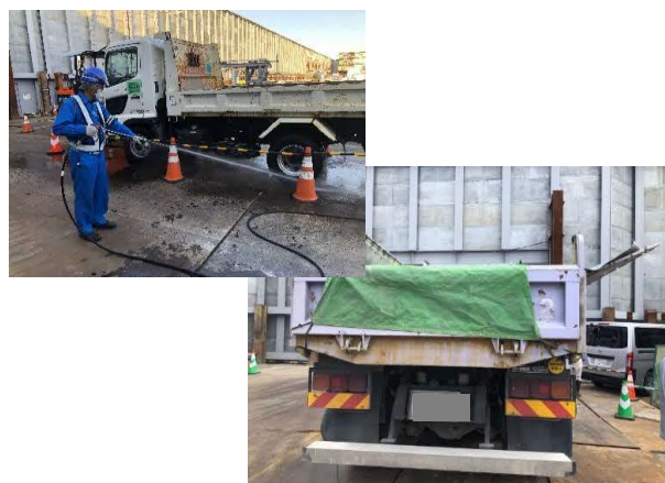
写真4-1-1-9 荷台への防塵シート敷設及び散水
