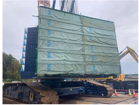
写真4-1-4-1 (2) 仮囲い・防音シート等の設置 (エンジン周りに防音シートを設置)
