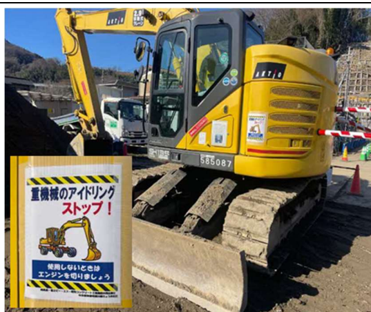
写真 4-1-7-5 建設機械の使用時における配慮 (重機運転者にアイドリングストップを促す 看板の設置)
