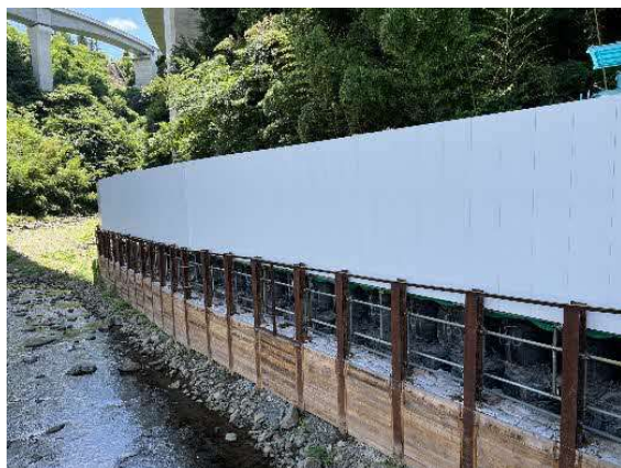
写真 4-1-8-3 仮囲い・防音シート等の設置状況 (仮囲い設置状況)
