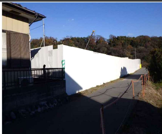
写真 4-1-7-2 仮囲い・防音シートの設置
