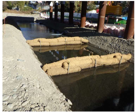
写真 4-1-7-8 汚濁処理施設及び仮設沈砂池の設置
