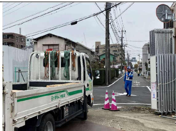
写真4-1-6-10 交通誘導員による誘導
