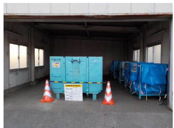
写真4-1-5-12 副産物の分別・再資源化
