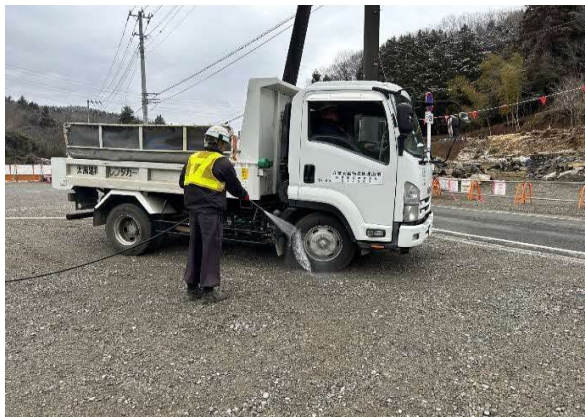
写真 4-1-10-3 資材及び機械の運搬に用いる車両の出入り口等の 清掃、散水及びタイヤの洗浄 外来種の拡大抑制
