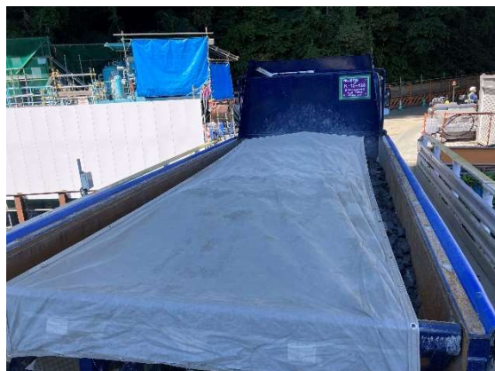
写真 4-1-8-10 荷台への防塵シート敷設
