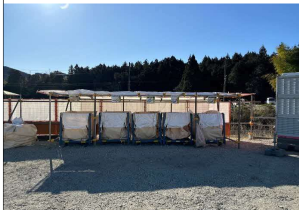
写真4-1-10-6 副産物の分別・再資源化
