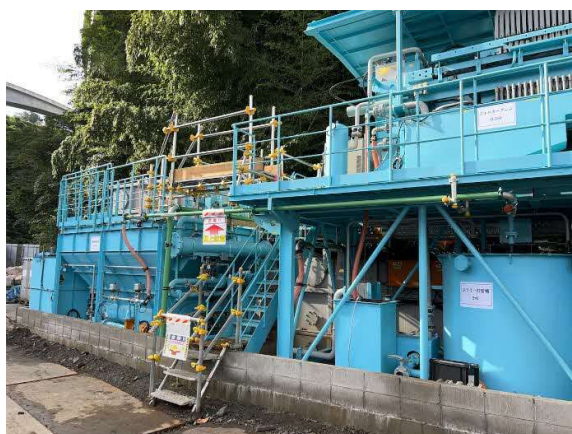
写真 4-1-8-11 工事排水の適切な処理
