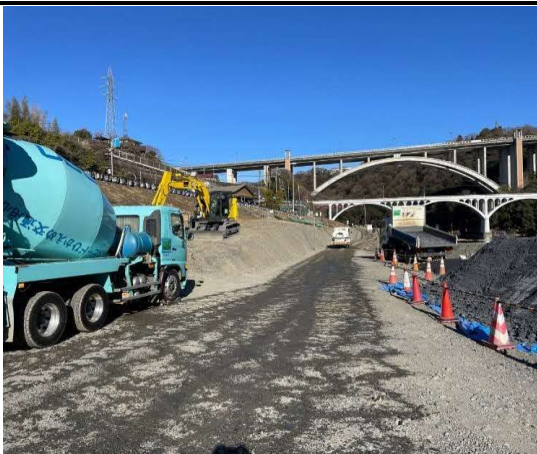
写真 4-1-7-1 工事現場の清掃及び散水
