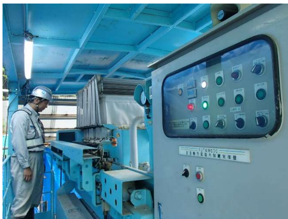
写真 4-1-8-7 建設汚泥の脱水処理
