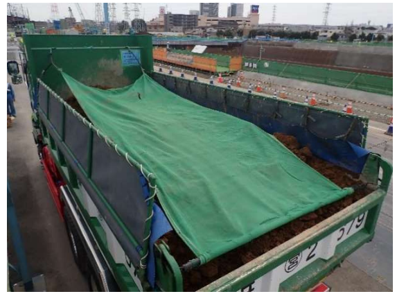
写真4-1-5-14 荷台への防じんシート敷設及び散水
