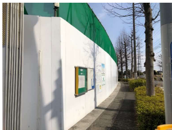
写真 4-1-3-1(1) 仮囲い・防音シート等の設置状況
