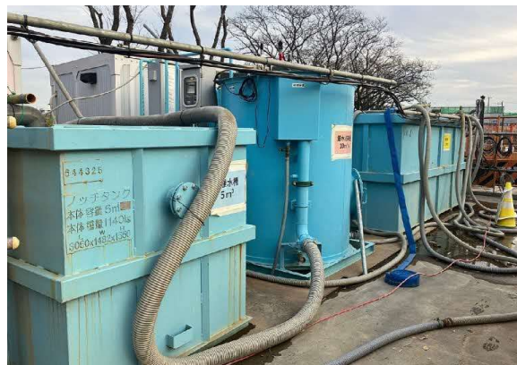
写真4-1-4-9 下水道への排水 工事排水の監視 工事排水の適切な処理 (濁水処理設備の設置状況)
