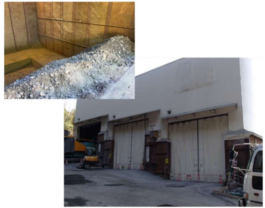
写真 4-1-8-16 土砂ピットにおける発生土の適切な管理
