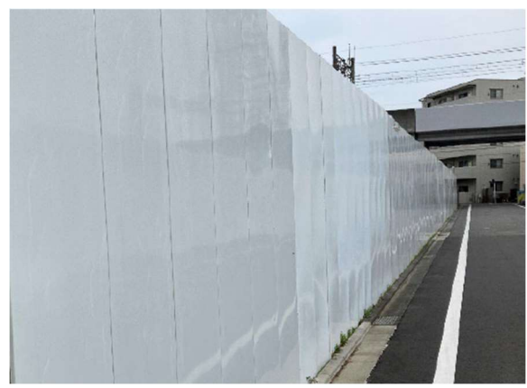
写真4-1-6-2 仮囲いの設置状況
