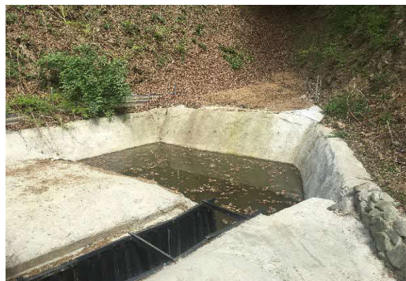
写真4-1-11-10 濁水処理設備及び仮設沈砂池の設置
