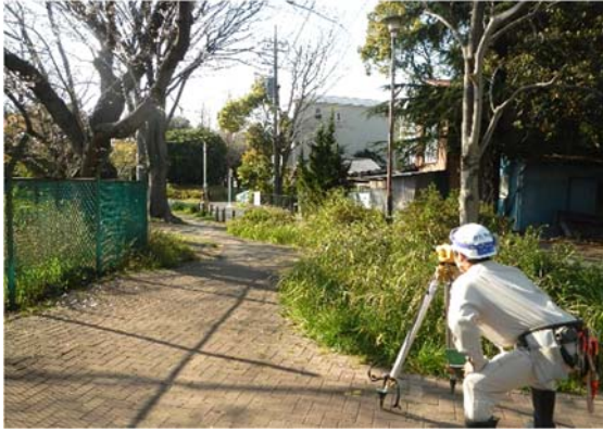
写真 4-1-1-7 山留め材及び周辺地盤の計測管理
