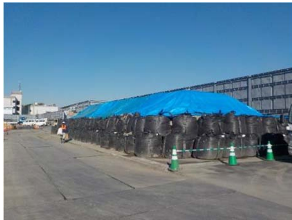
写真 4-1-2-7 土砂ピットにおける発生土の適切な管理 (シート覆いによる飛散防止)
