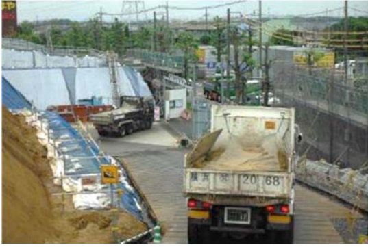
写真 4-1-3-13 荷台への防塵シート敷設
