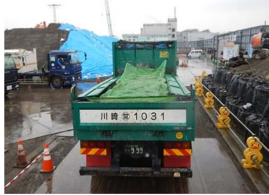
写真 4-1-2-12 荷台への防塵シート敷設及び散水
