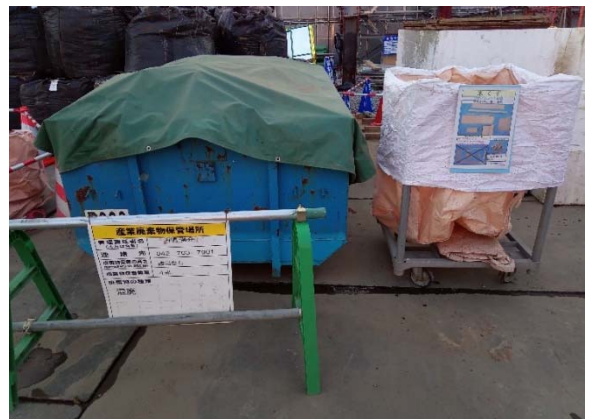
写真 4-1-4-12 副産物の分別・再資源化
