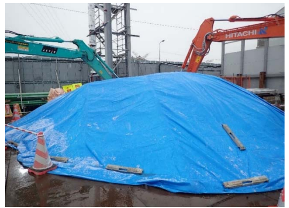
写真 4-1-4-10 土砂ピットにおける発生土の適切な管理 (シート覆いによる飛散防止)
