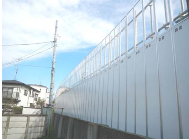
写真 4-1-1-1 仮囲い・防音シート等の設置
