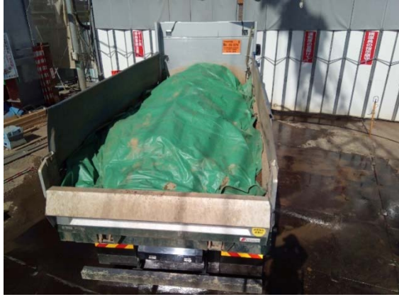
写真 4-1-4-13 荷台への防塵シート敷設及び散水
