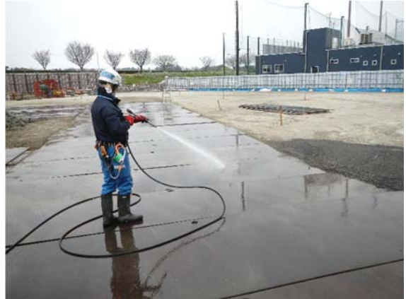
写真 4-1-1-4 工事現場の清掃及び散水
