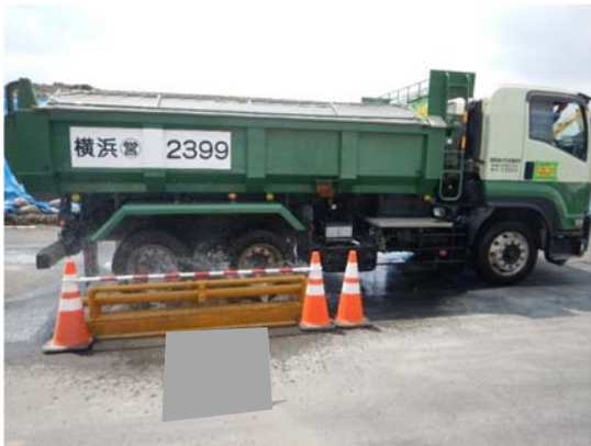
写真 4-1-2-13 資材及び機械の運搬に用いる車両の 出入口等の清掃、散水及びタイヤの洗浄
