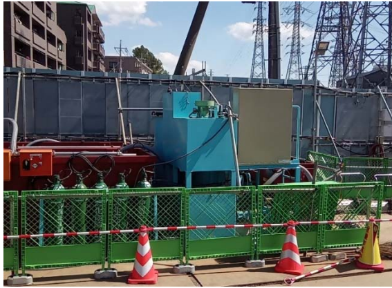
写真 4-1-4-7 工事排水の監視 工事排水の適切な処理
