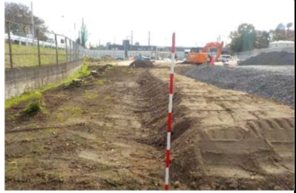
写真 4-1-1-8 建設発生土の再利用 (ヤード内発生土を出入口盛土に転用)
