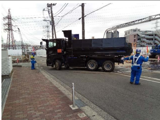
写真 4-1-4-17 交通誘導員による誘導写真
