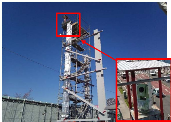
写真 4-1-4-11 山留め材および周辺地盤の計測管理 (測量機器を用いた地盤面高さの計測)
