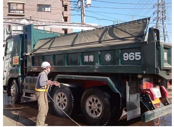
写真 4-1-4-14 資材及び機械の運搬に用いる車両の出入り口 等の清掃、散水及びタイヤの洗浄
