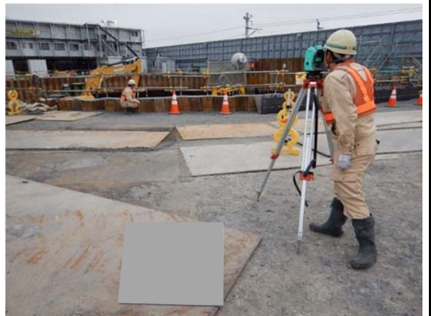
写真 4-1-2-8 山留め材及び周辺地盤の計測管理
