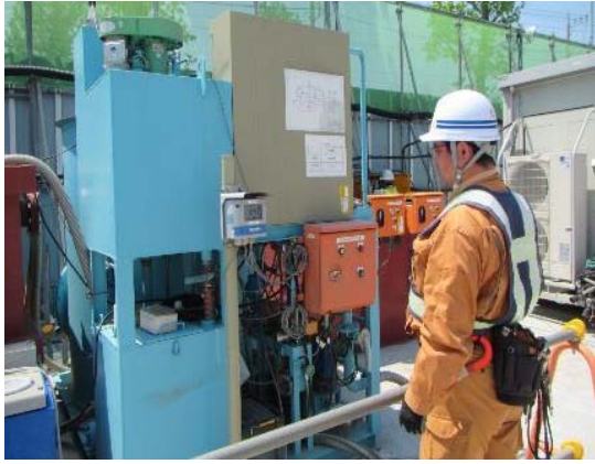
写真 4-1-3-7 工事排水の適切な処理
