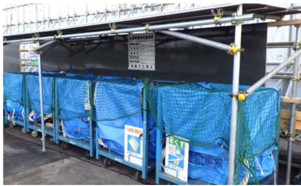
写真 4-1-1-9 副産物の分別・再資源化
