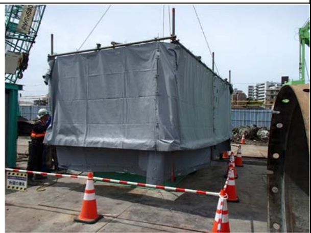
写真 4-1-2-2(2) 低騒音型建設機械の採用 (防音シート設置による音の低減)
