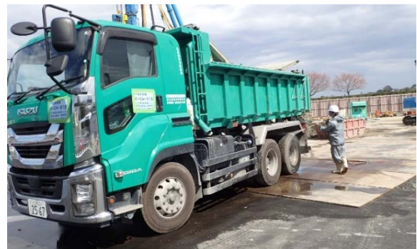
写真 4-1-1-10 資材及び機械の運搬に用いる車両の出入口 等の清掃、散水及びタイヤの洗浄
