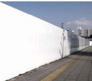
④仮囲い設置 (H=3.0m、1.8m)
