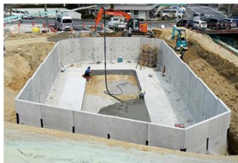
擁壁の設置～底板打設
