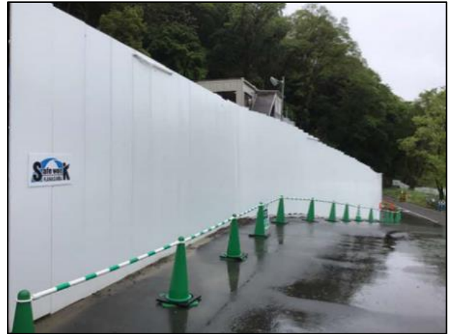
写真② 仮囲い
