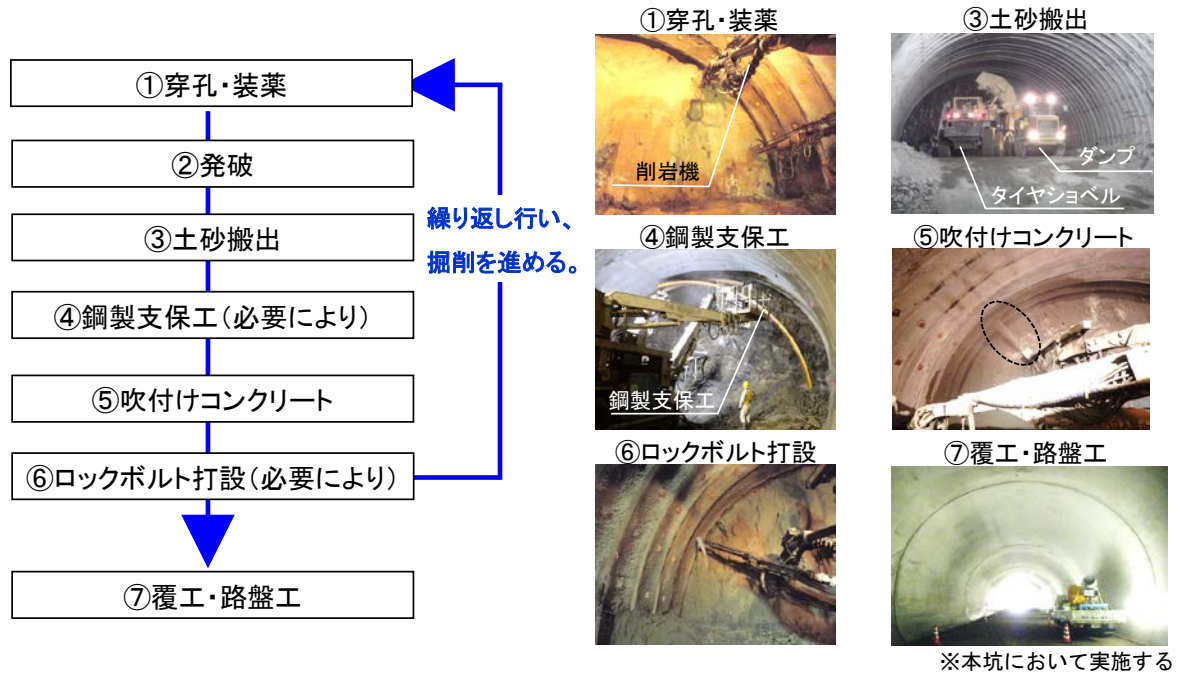
図 2-5 トンネルの施工手順
