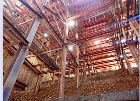
神奈川県駅（仮称）新設工事にて掘削・下床版構築が完了後、補強用の柱を設置する。
