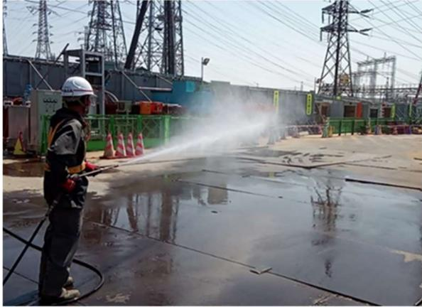
写真① 工事施工ヤード等の散水
