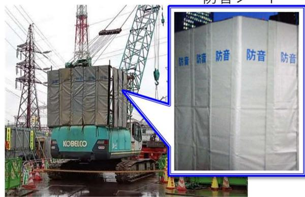
写真② 750t、350tクローラクレーンのエンジン部に防音対策を実施
