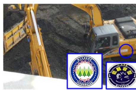
写真④ 排出ガス対策型、 低騒音型建設機械の使用
