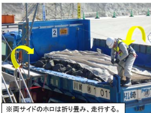
写真② 荷台への防じんシートの設置
