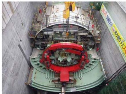
シールド機組立
