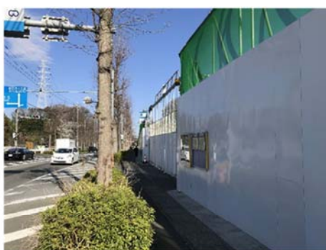
写真① 仮囲い設置
