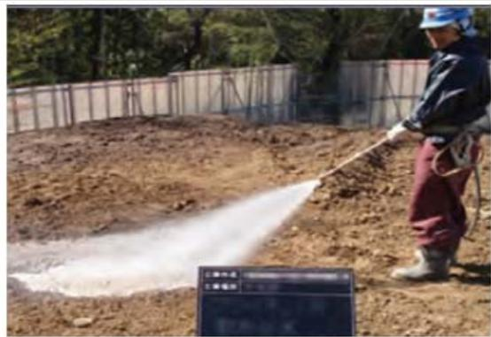
写真② 工事施工ヤード等の清掃散水
