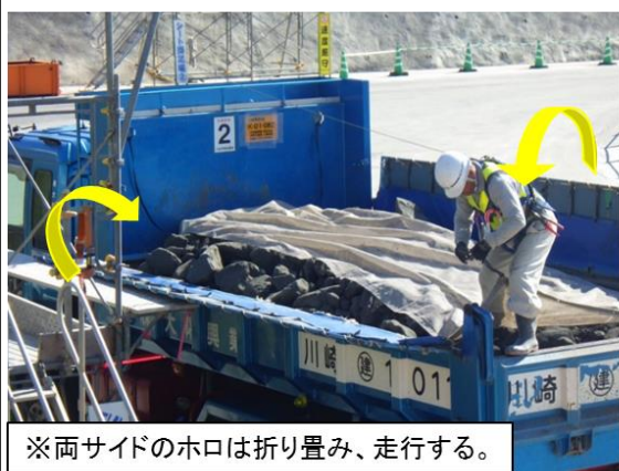
写真② 荷台への防じんシートの設置
