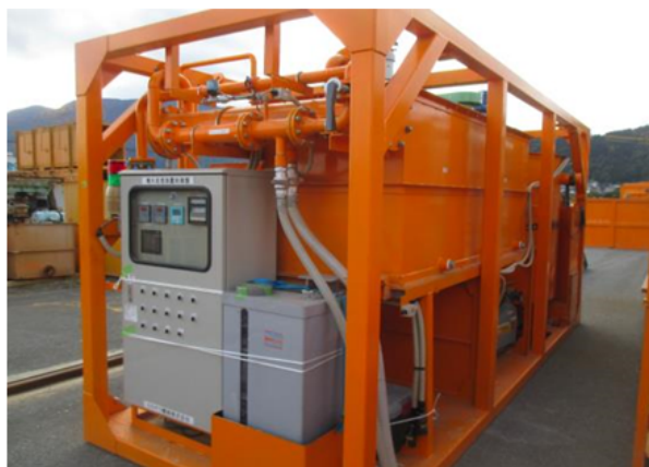
写真①濁水処理設備の設置 (ヤード内に設置)
