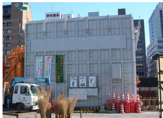
写真② 防音ハウスの設置
