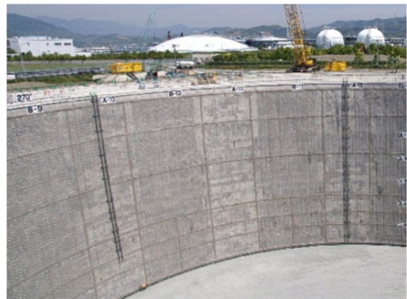
写真②止水性の高い土留壁の設置
